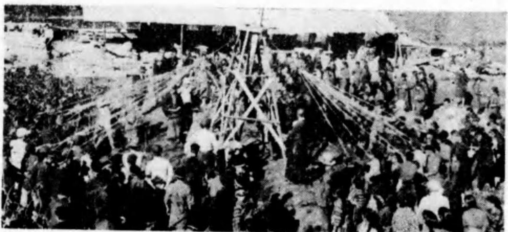
菊池西部實業學校講堂新築地固め 地搗の生徒の作業の状況
