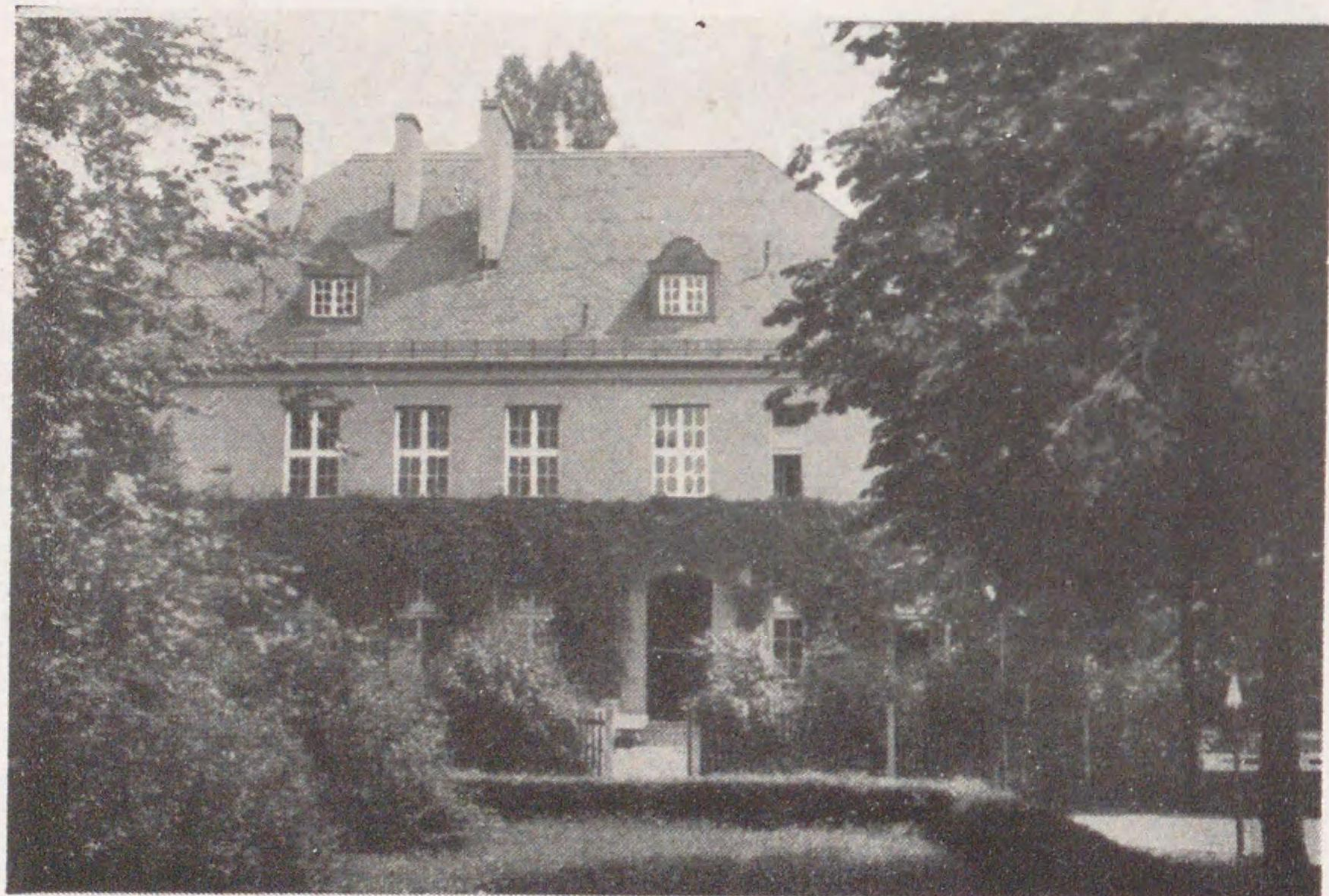
ドイツ精神病学研究所臨牀学研究室, 隔離病舎(ミュンヘン・シュワービング病院第五号別棟)の入口.
