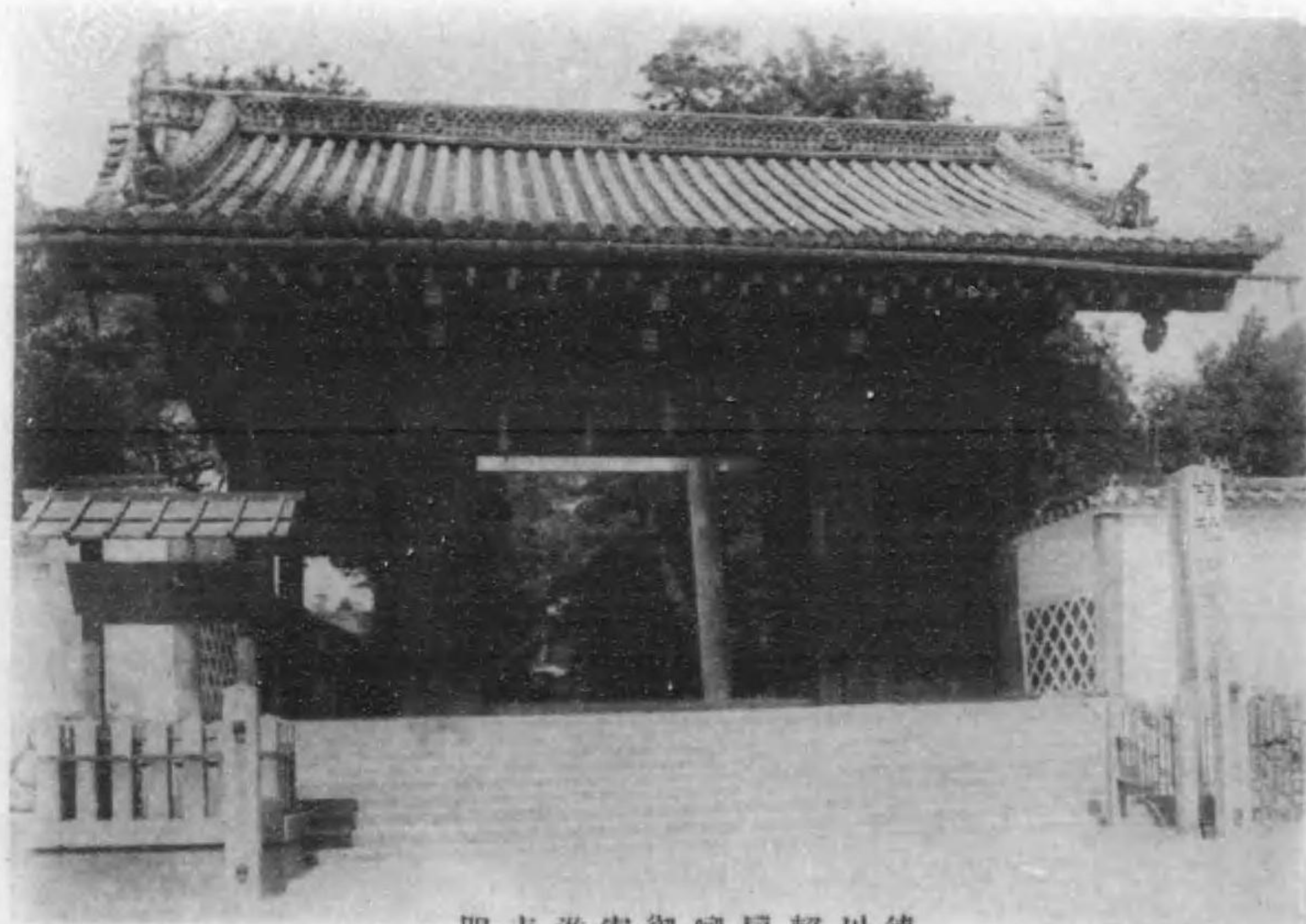
徳川頼房卿御寄進表門
