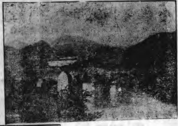
黔滇路黃果樹橋里程為 140K+900 5孔石拱橋孔徑為7.4至29.4 公尺 全長70公尺 此橋與壩陵橋相傳係古時兩姊妹 二人分別捐建以利行旅壩陵橋 於前西南局時在原下游另建新 橋通車黃果樹橋至今仍沿用之 兩端小孔因石質風化及灰漿冲 失一部份三十七年夏季重加觀 拱
