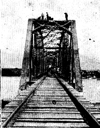
修復之涂家埠大橋(南潯段第一大橋)
