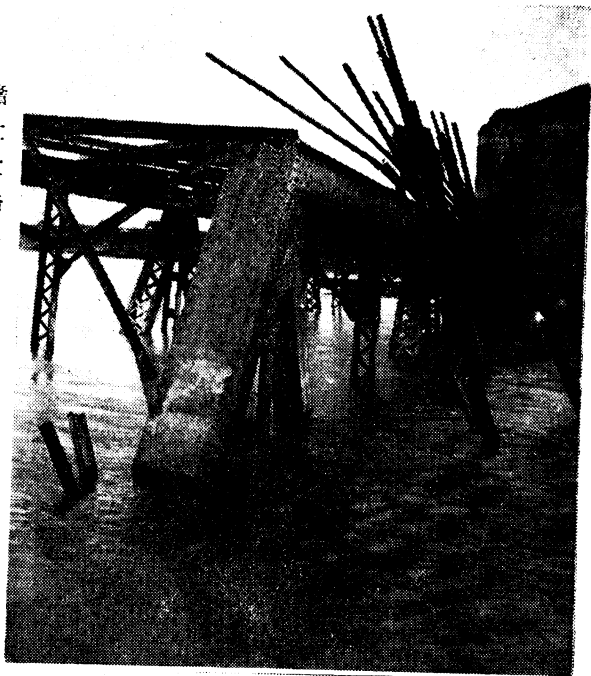
5.8.5 公里處鋼梁橋破壞情形：
