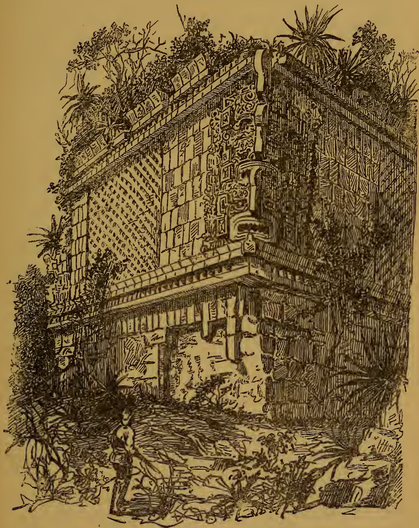
FAÇADE OF CASA DE LAS MONJAS.
