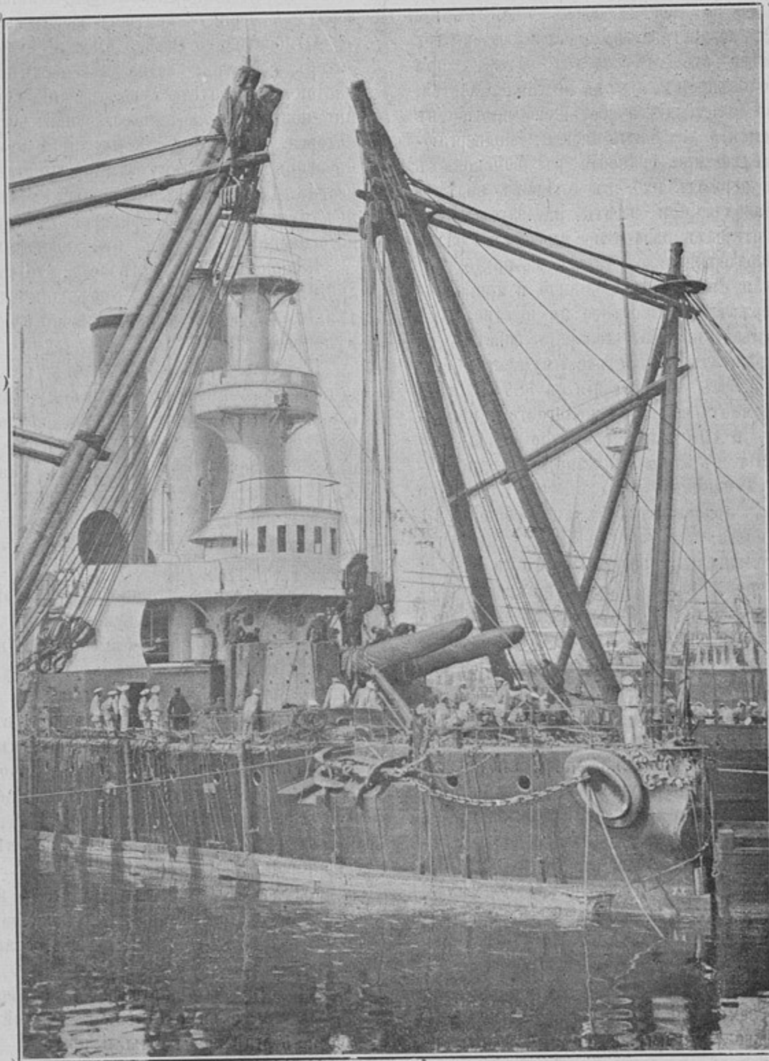
Съемка брони и орудій съ броненосца «Генераль-Адмиралъ Апраксинъ» передъ вводомъ его въ Константиновскій докъ.
