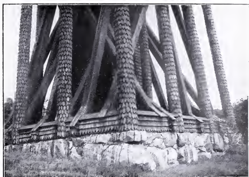
SKANSEN, DER UNTERBAU VON HÄLLESTADT-STAPEL
