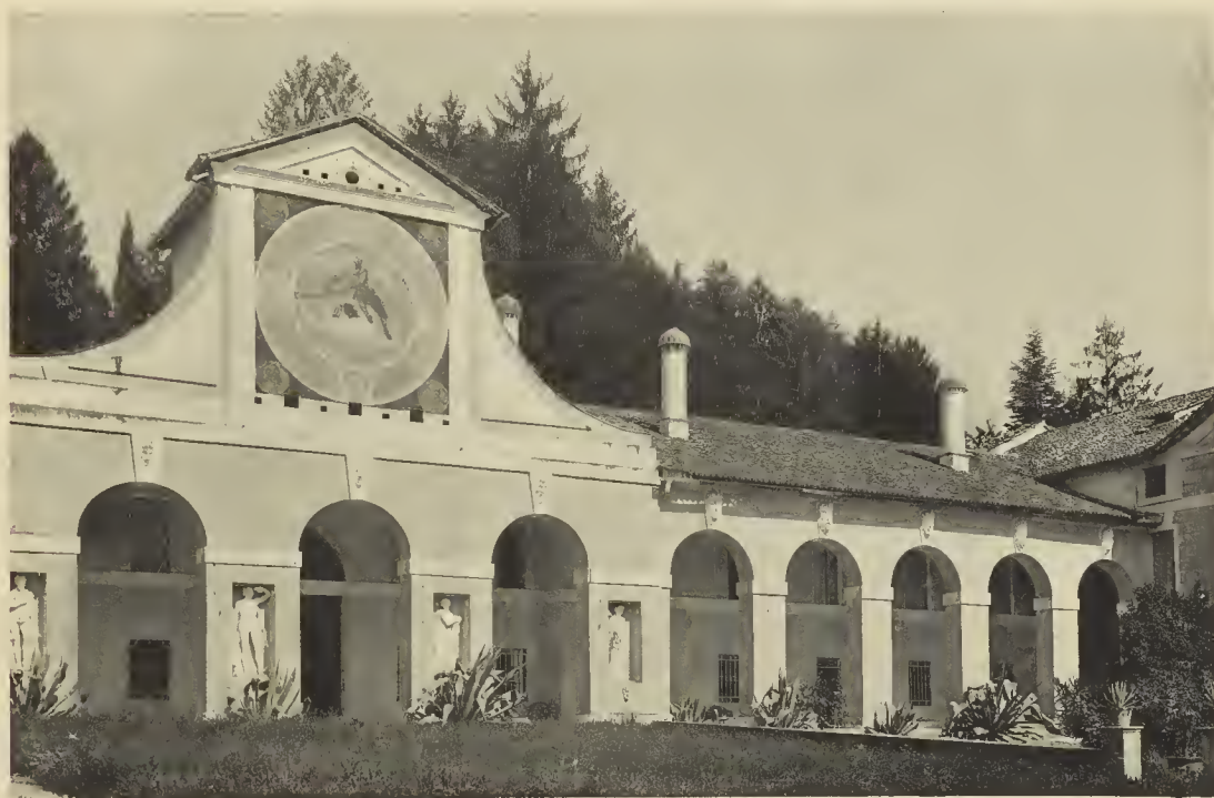
VILLE DE MÈLVRE À MASER RAIL ET DÉTAIL D'UNE DES AILES
