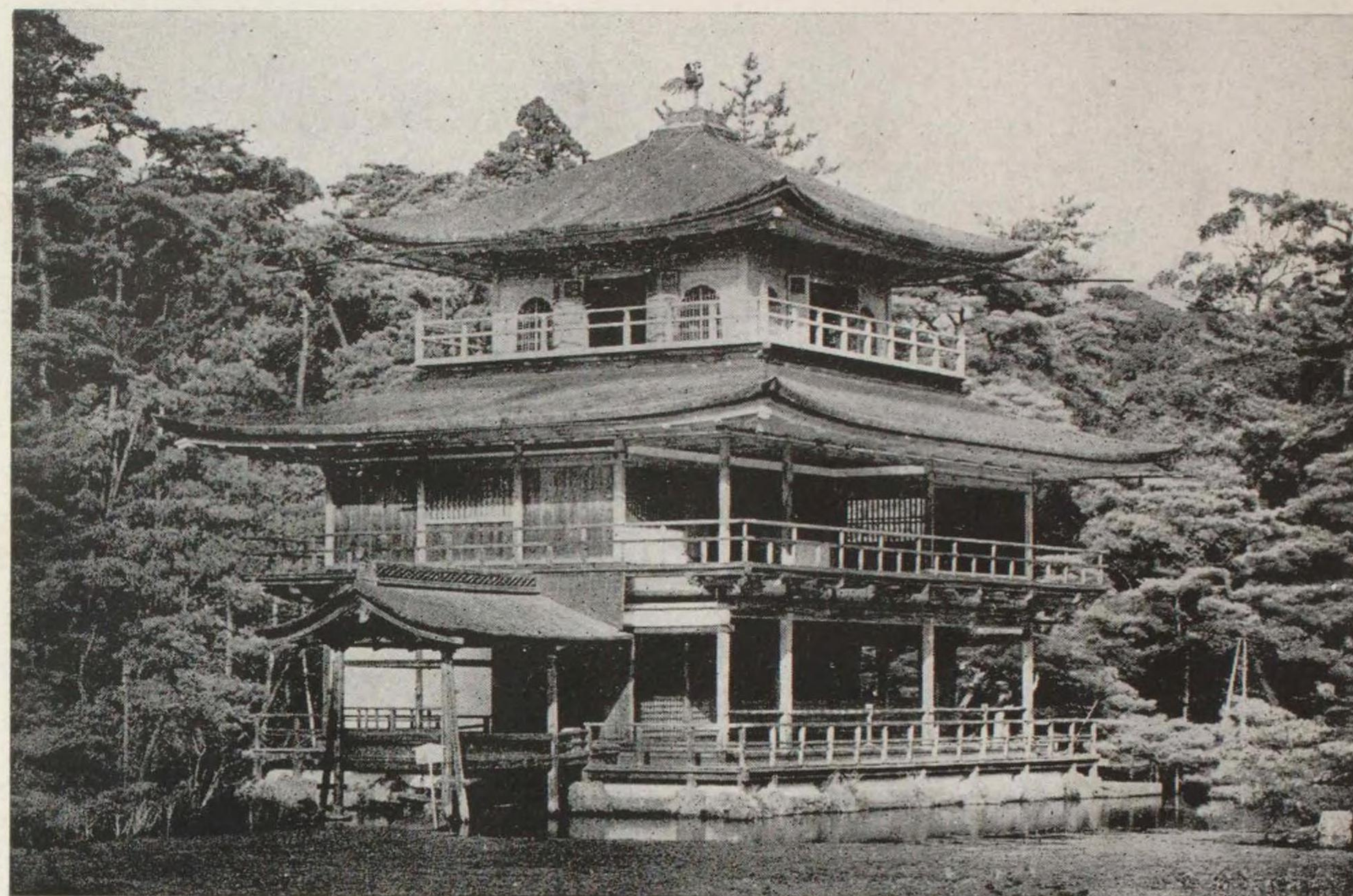
京都市 鹿苑寺 金閣 三層閣 屋根上層寶形造檜皮葺
