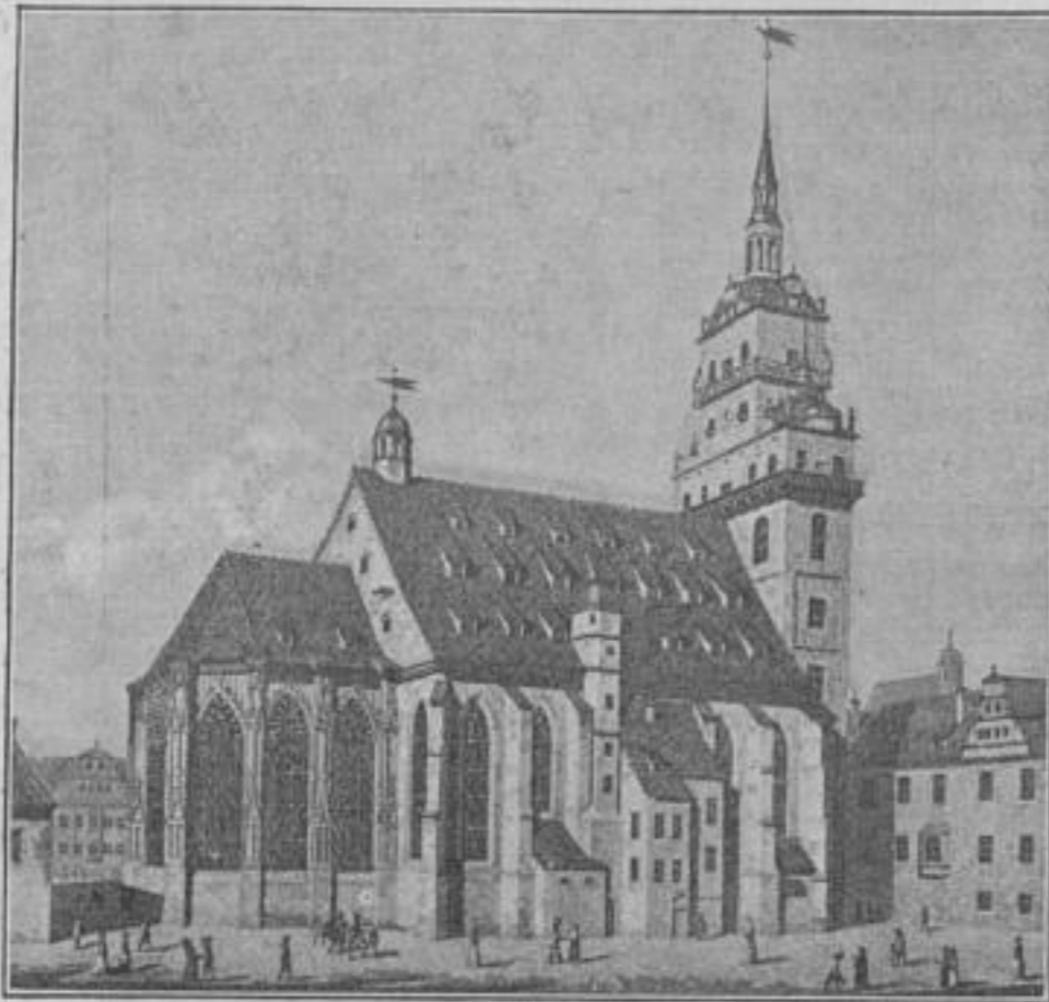
Alte Kreuzkirche, Nordseite.
