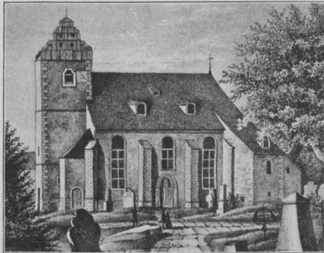
Kirche zu Kaditz vor der Erneuerung.
