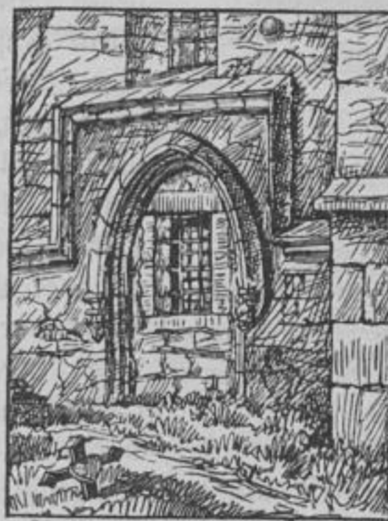
Ehemaliges gotisches Portal.
