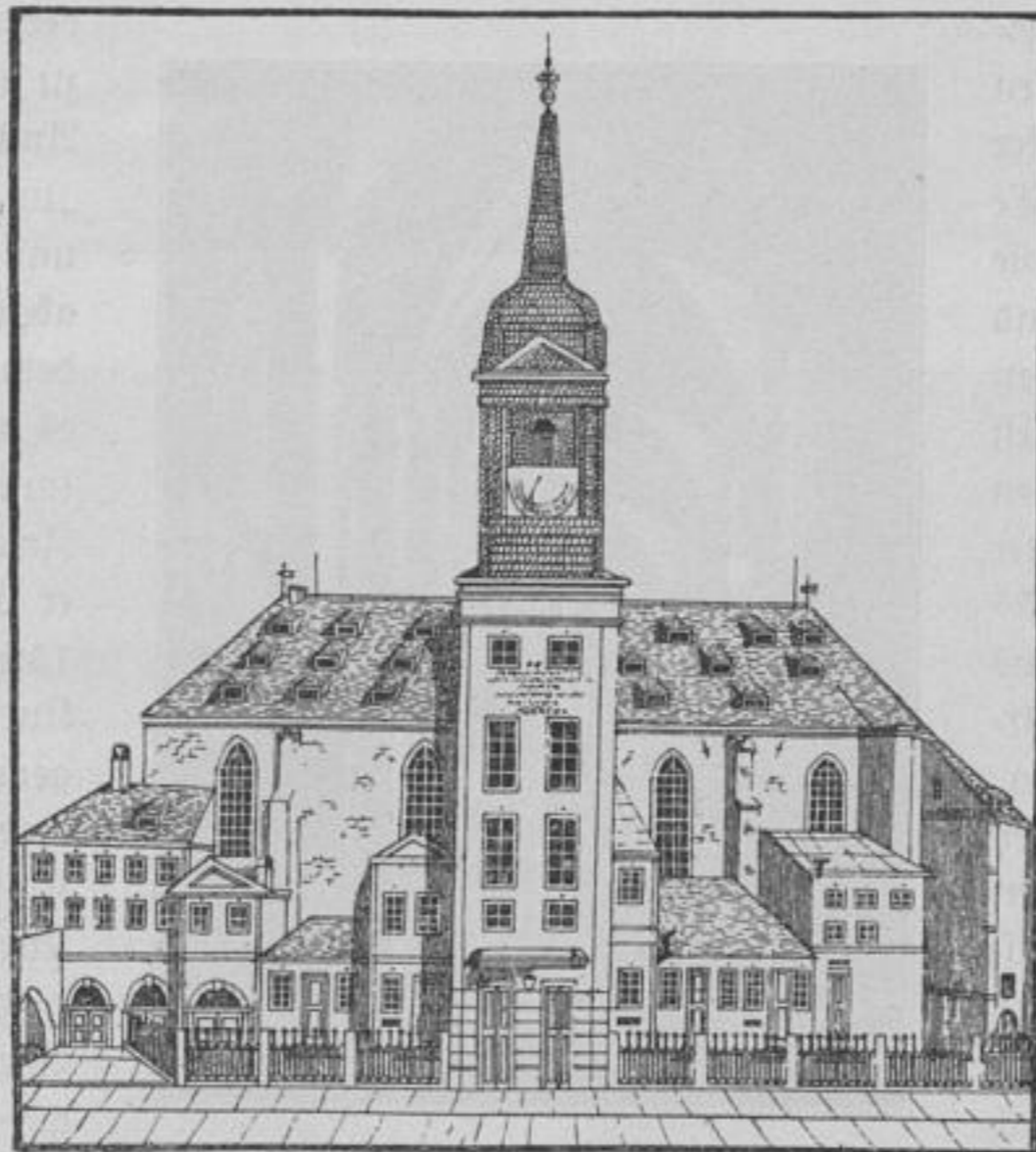
Ev. Hofkirche vor der Erneuerung, von Süden (von Westen f. S. 277).
