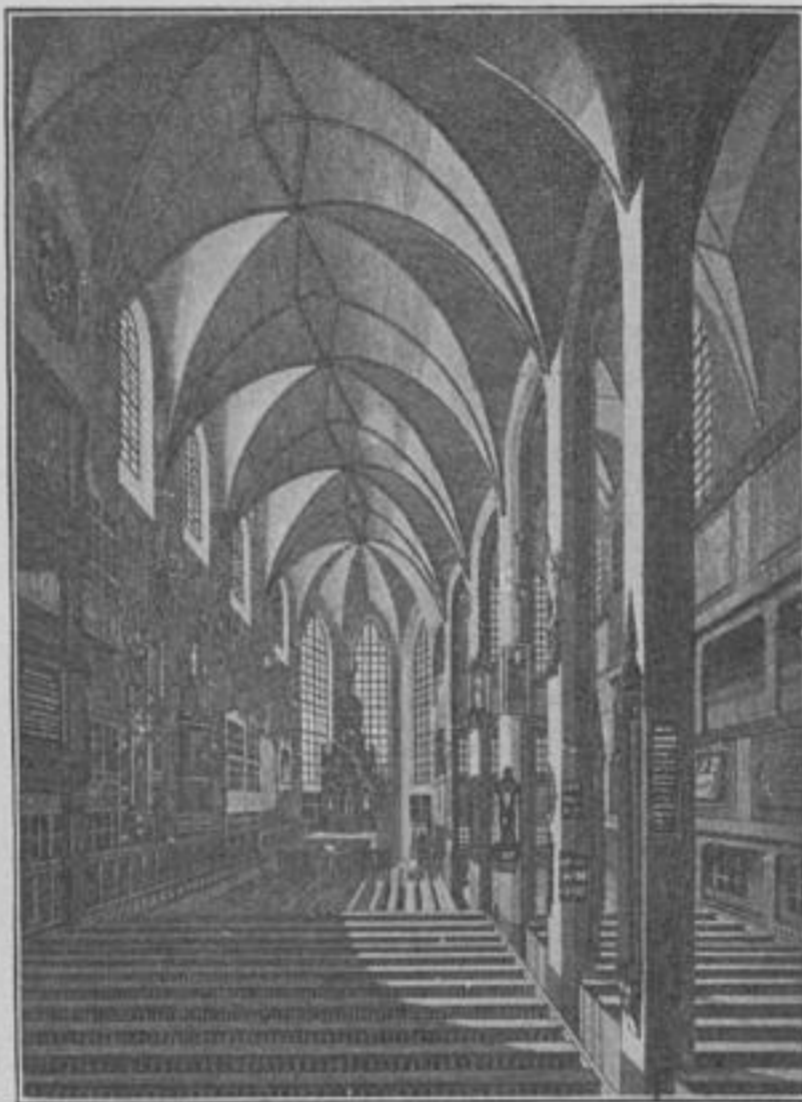
Innere der ev. Hofkirche vor der Erneuerung.
