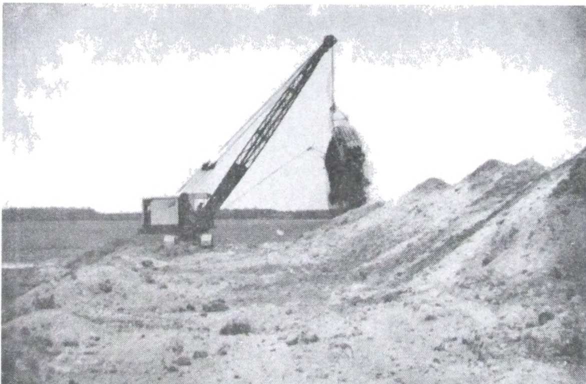
Fot. N° 22. — Desagüe de los partidos de General Belgrano y Las Flores. Excavadora trabajando en la canalización de Arroyo Poronguitos.
