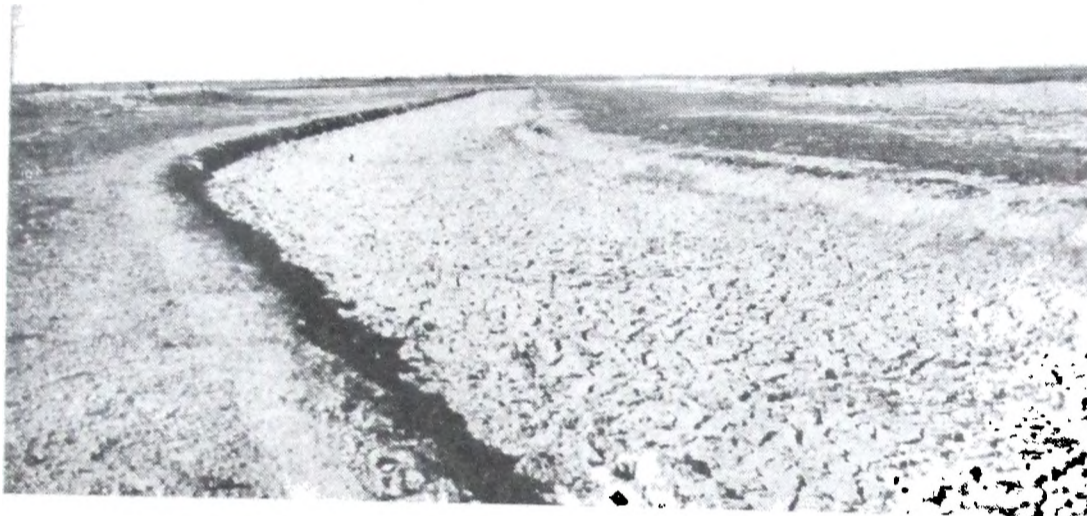
Fot. N° 7. — Plan de obras de Castelli. Desviación del Canal «B» al arroyo Corralito. Vista hacia aguas abajo del Hm. 11.
