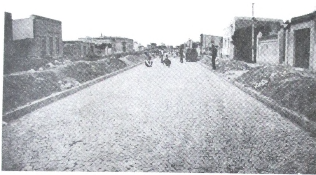
Calle 44 (1 faja) — Granitullo colocado.
