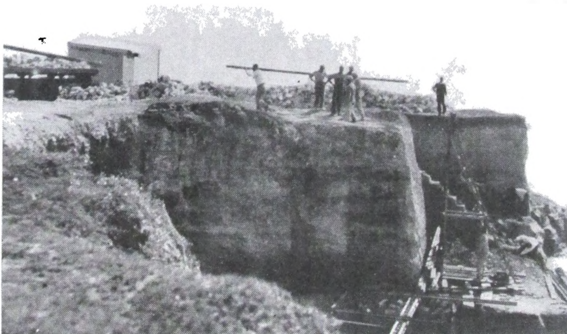
Nº 2. — Espigón «Solarium Nº 3» — Año 1938. — Iniciación de la obra. Desmante de la barranca frente al arranque.
