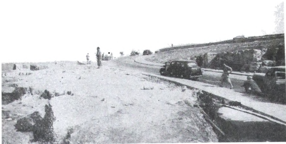
Cabo Corrientes sección de acceso a la Explanada Sud.
