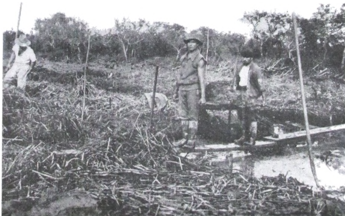
Desvío zanja Torres a Punta Morán (2ª sección de Islas).— Esta vista es un complemento de la anterior, donde muestra la pésima calidad del terreno por donde deberá pasar la draga. Terrenos anegadizos que hacen imposible el empleo de carretillas y que sólo es posible retirar la tierra y embalsado con el empleo de «angarillas» y tablonés para el paso de los peones.
