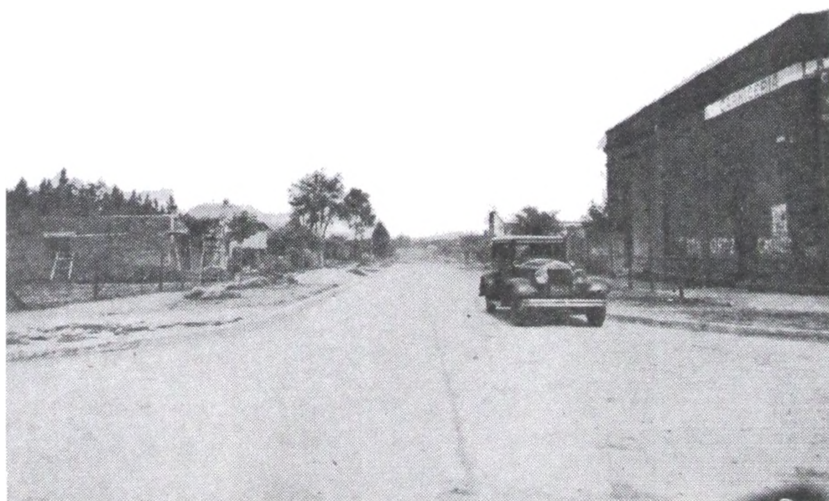
Calle Pavimento Hormigón Armado.
