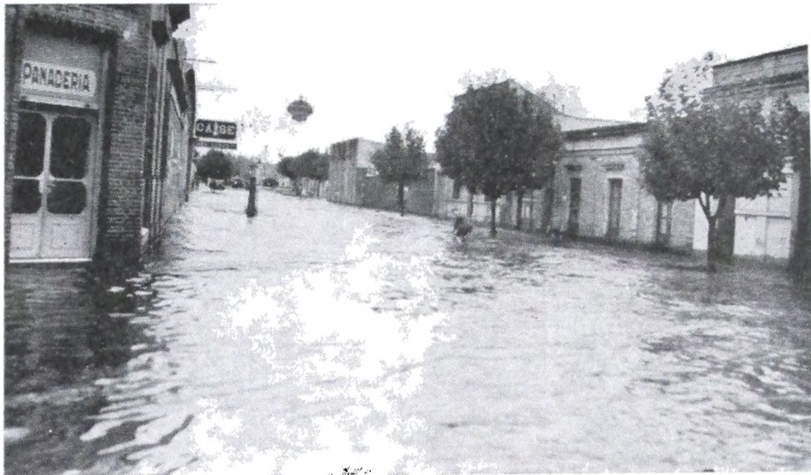
Intersección de las calles Belgrano y España, después de una lluvia de 60 mm.
