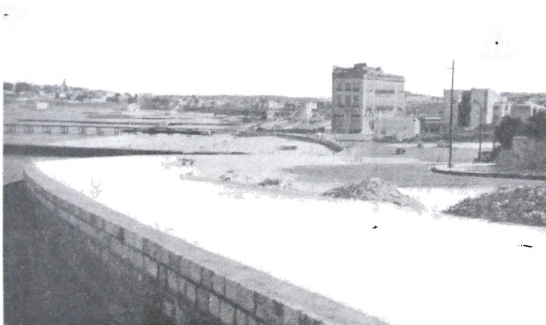
Nº 28. — Explanada Norte — Año 1938. — Murete de piedra, sin la cupertina que se colocó después.
