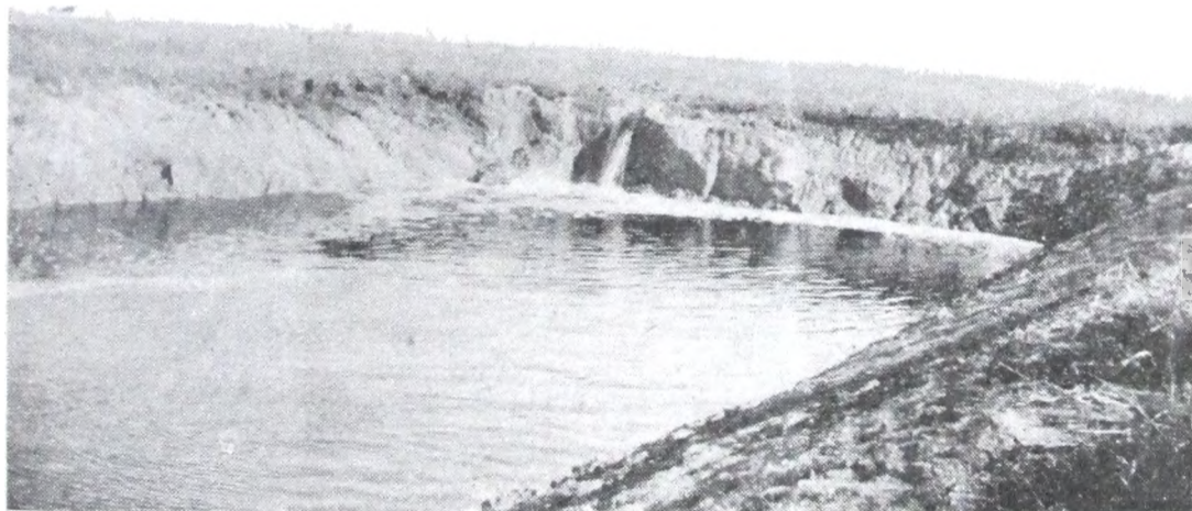
Fot. N° 8. — Plan de obras de Castelli. Canal Principal. Vista de un trecho en ejecución, actualmente totalmente terminado.
