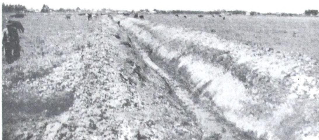
Fot. N° 31. — Desagüe del ejido de General Belgrano. Trecho terminado del Canal N° 1 en el Hm. 4.
