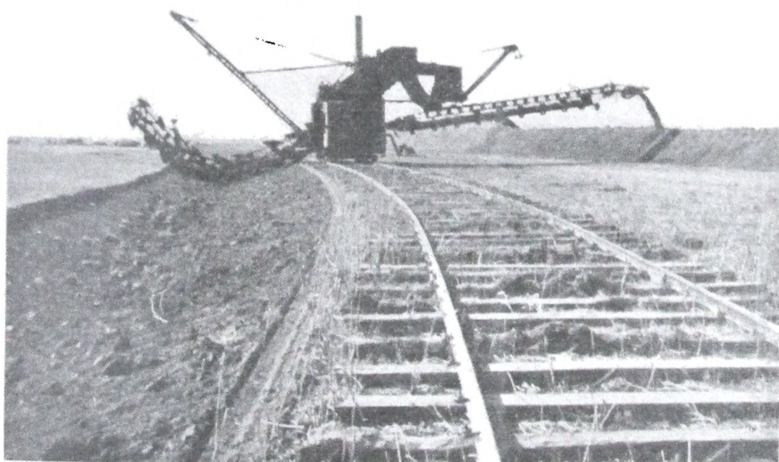
Fot. N° 24.— Desagüe de los partidos de General Belgrano y Las Flores. Máquina excavadora utilizada en la ejecución del canal al Bajo de Cerrillos.
