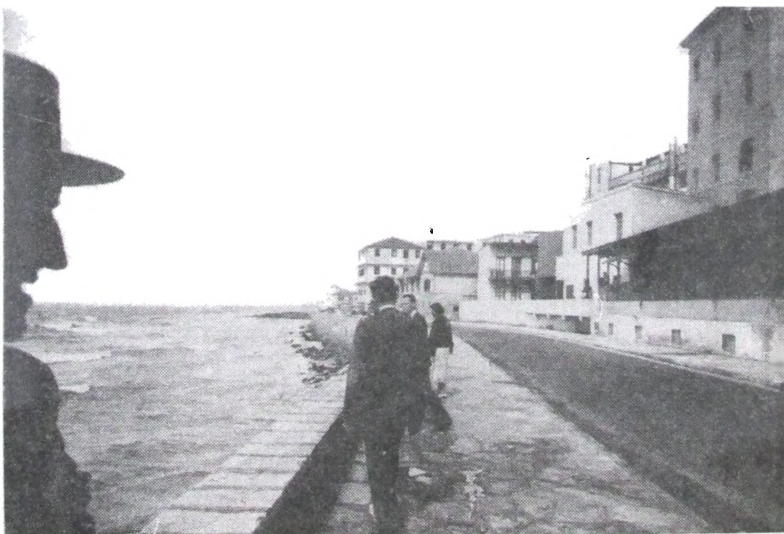
Vista de una sección terminada.
