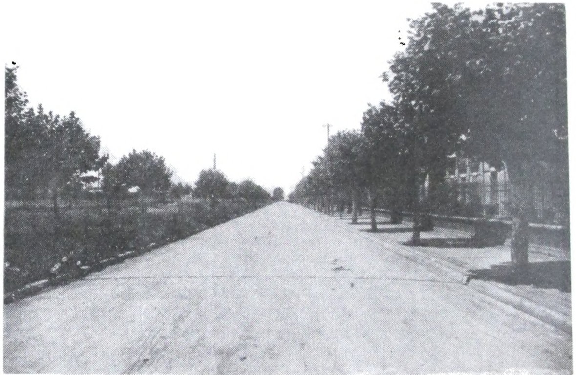
Pavimento y veredas construídas frente al Hospital Municipal.
