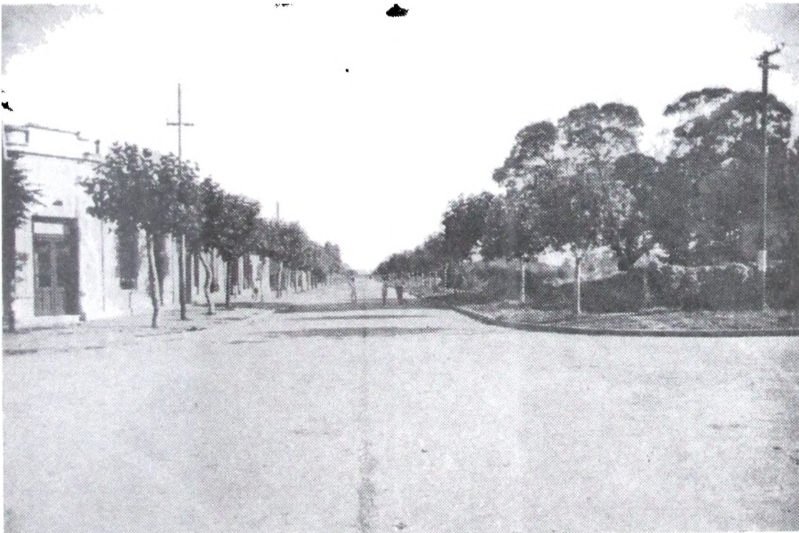
Calle Belgrano, pavimento Hormigón Armado.
