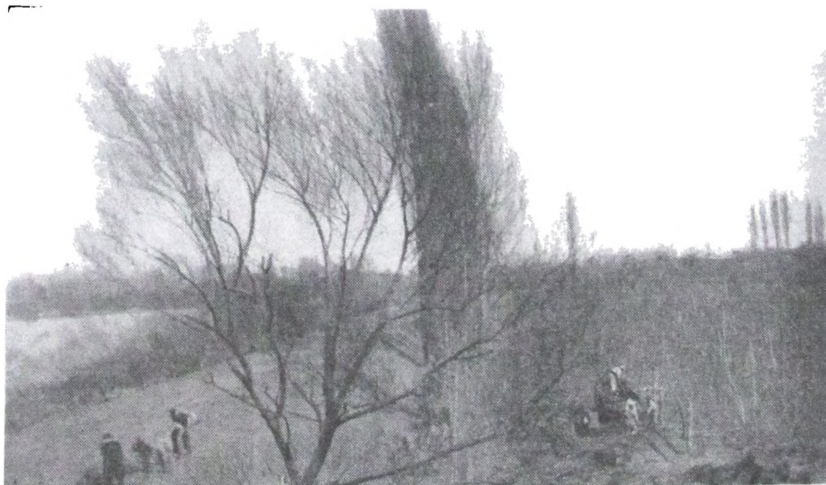
2/X/1938. — Vista del terreno de propiedad de la señora Herta Pacwschies de Mau, antes de iniciar el zanjeo sobre el lado S. O.
