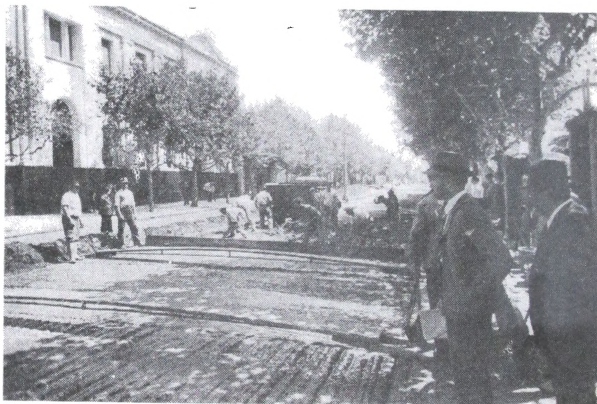
Calle 29 de 24 a 26. Pavimento Hormigón Armado.
