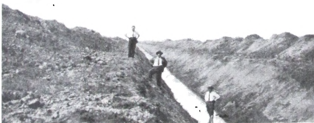
Desagüe de Mercedes. Canal excavado por la máquina en terreno seco, y taludes 1:1 peinados por dos peones que siguen la máquina.
