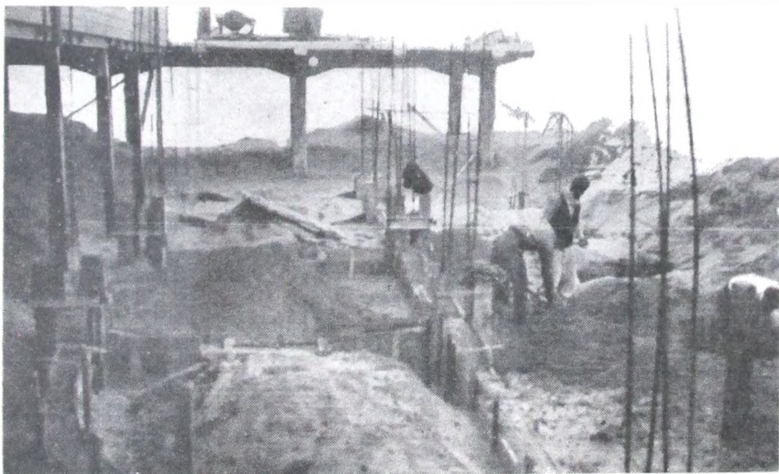
Nº 36. — Miramar — Año 1938. — Arriostado inferior del muro de unión entre la antigua rambla y muro de defensa.
