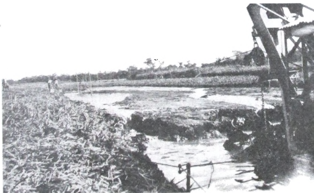
Desvío zanja Torres a Punta Morán (2ª sección de Islas). — Draga 254 D durante los trabajos de canalización. Esta vista fué tomada cuando la draga está haciendo la primera «pasada»; véase la escasa «carga» de los baldes, debido al embalsado, que no es posible sacarlo en su totalidad con la cuadrilla.
