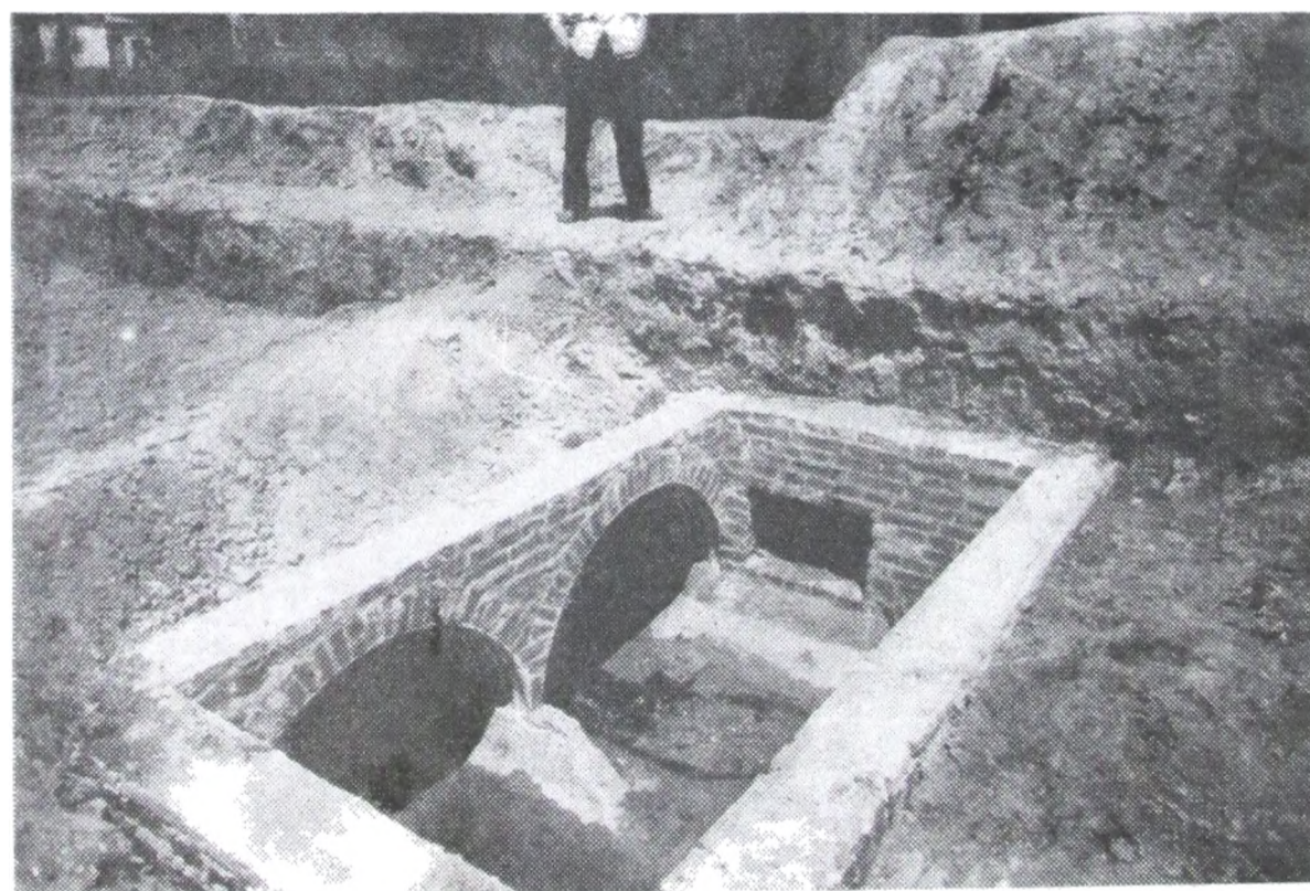
Cámara de desagüe calle 23 y 38.
