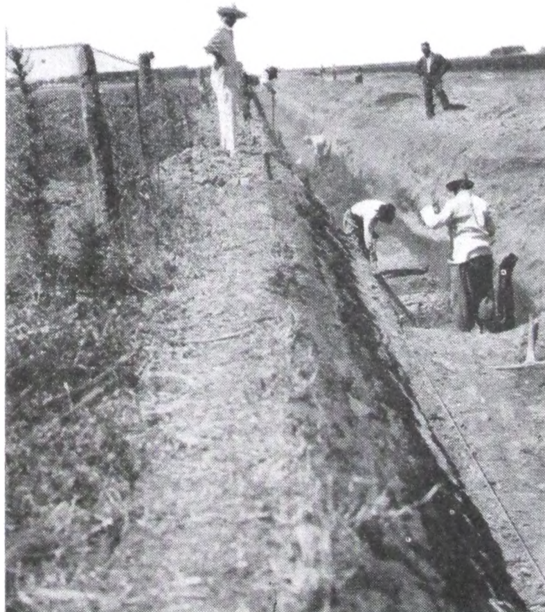
Desagüe zona del Hospital hasta el Río Salado. Terminado con pala a mano el trabajo de pala de buey. — Enero 1938.
