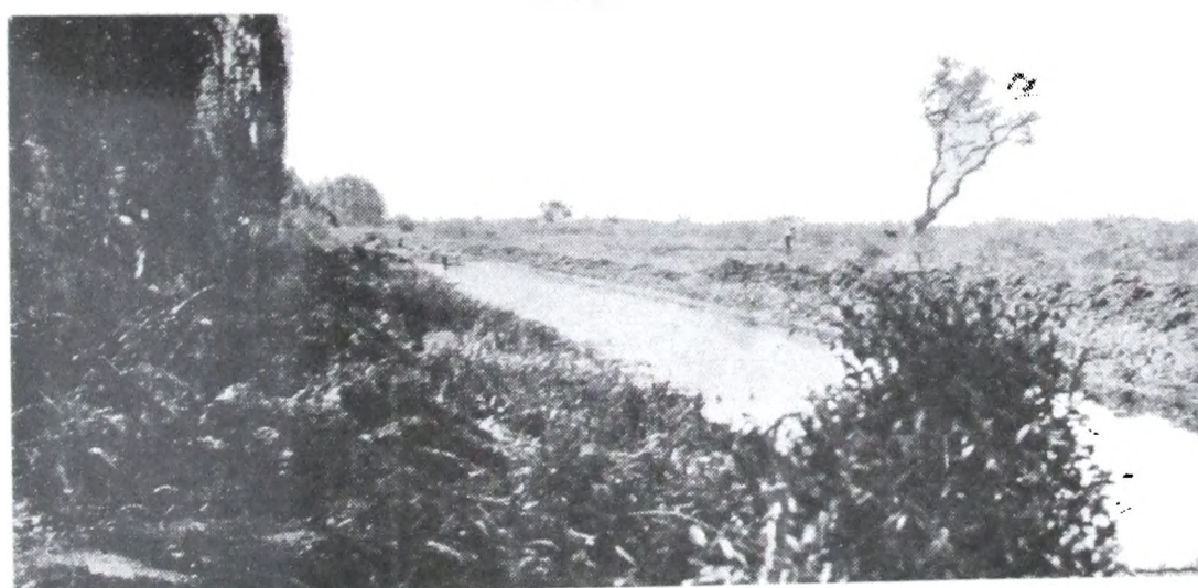
Arroyo Las Piedras (4ª sección de Islas).—Tramo del arroyo, terminado.
