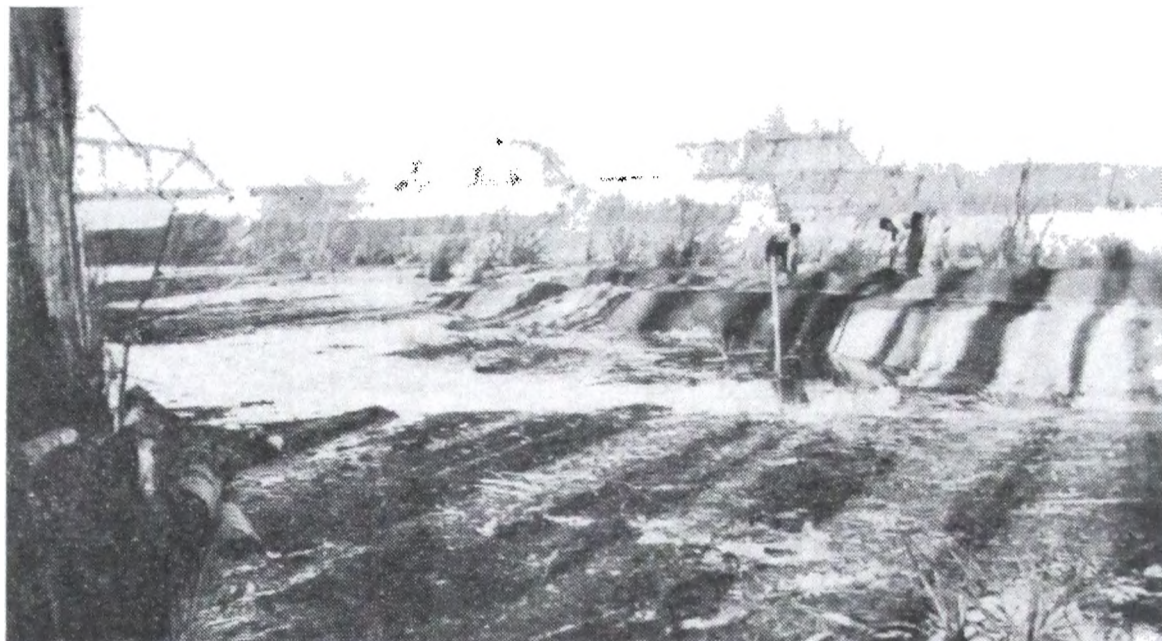
Octubre 1938. — Progresiva 1675 - 1775. Vista tomada durante la construcción del terraplén
