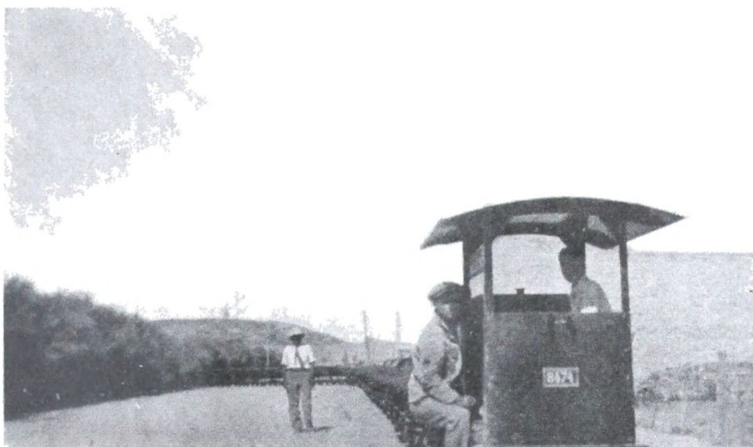
a). 21/III/1938. — Tren en marcha hacia la carga de tierra en el terreno Villalba
