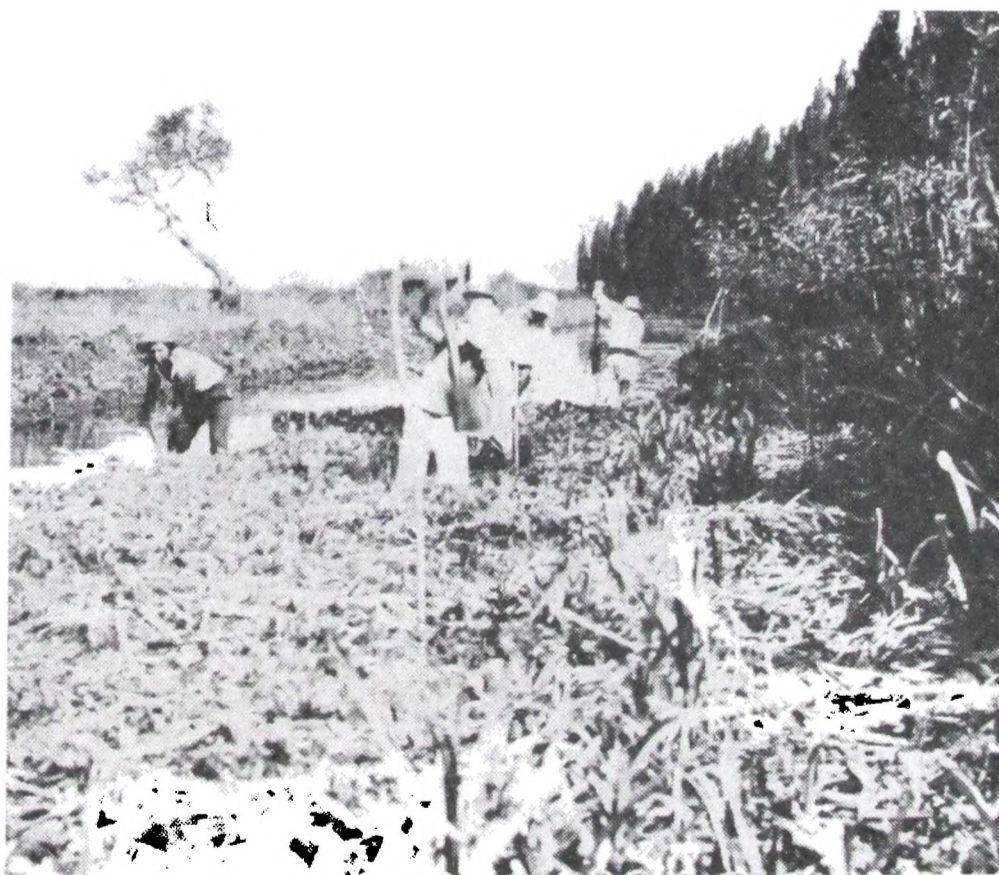
Arroyo Las Piedras (4ª sección de Islas). — Estas vistas muestran dos fases de los trabajos de la cuadrilla, en la extracción de embalsados.
