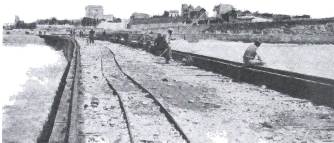
Nº 25. — Espigón Punta Iglesia — Año 1938. — Estado del espigón antes de iniciarse el revestimiento.
