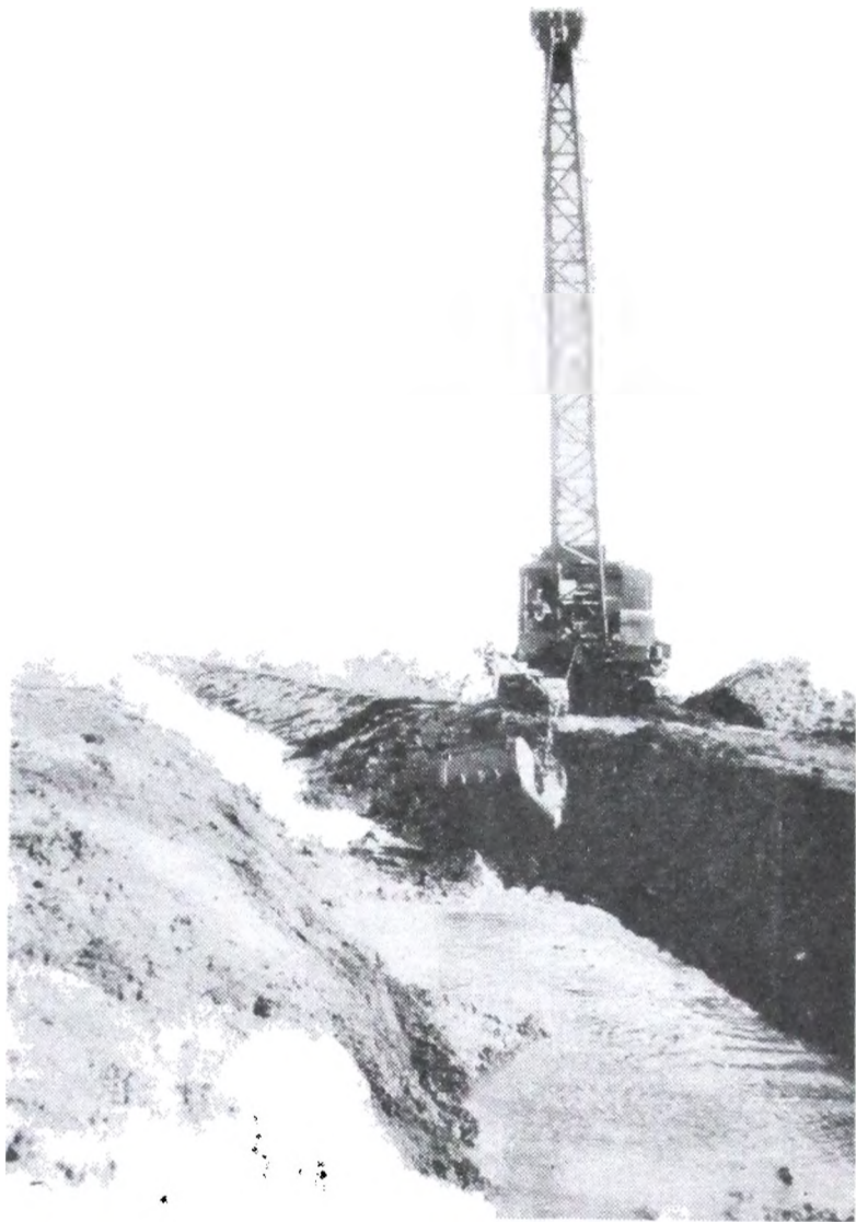
Fot. N° 13. — Desagüe del partido de General Paz. Canal de la Laguna de Ranchos al Arroyo Vitel. Máquina excavadora trabajando
