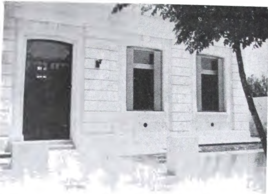
Detalle entrada principal
