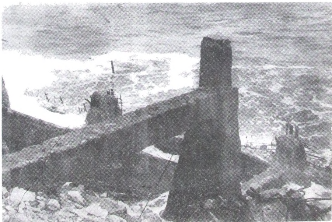
Detalle de la demolición de las construcciones existentes.
