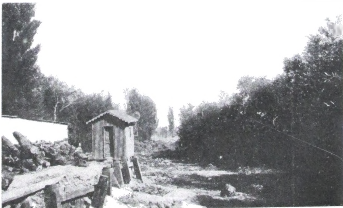
b). 18/I/1938. — Al terminar el desmonte
