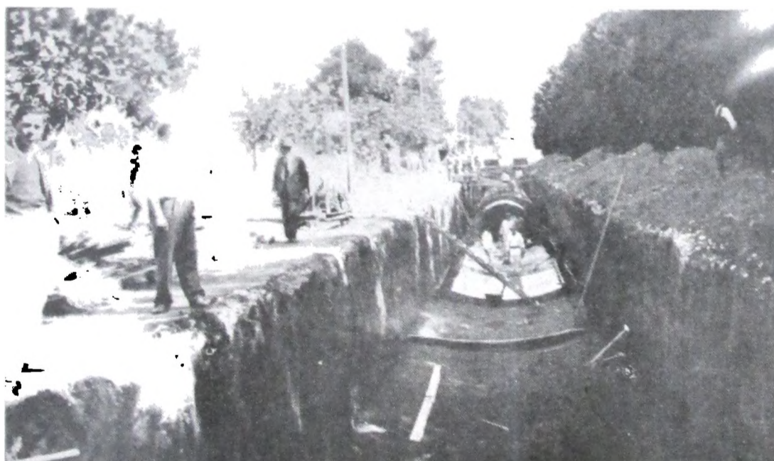
Construcción del conducto de desagüe en la calle Uriburu.
