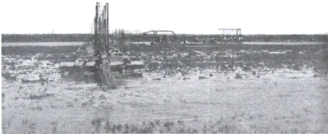
Fot. N° 3. — Limpieza de los canales «1» y «C». Descarga del material de «refouillage».
