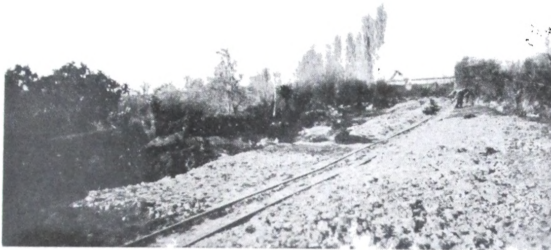
30/VI/1938. — Progresiva 1150 hacia la 1350. Estado actual del terraplén
