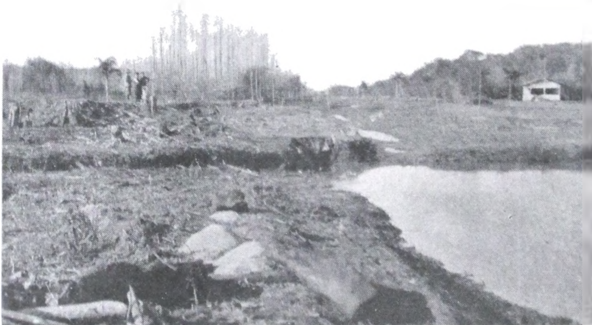
Arroyo Manzano de la Barca (3ª sección de Islas).— En primer plano una parte de sección dragada; más adelante, cancha libre de malezas y árboles y tajamares de contención ya terminados, tramo listo para la canalización.
