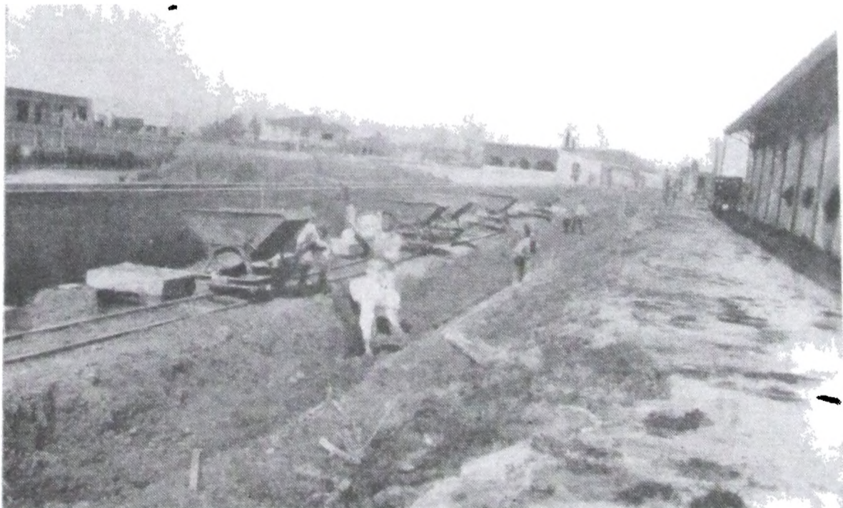
Se inicia la excavación en lado Oeste dársena 2, para poder colocar el martinete.
