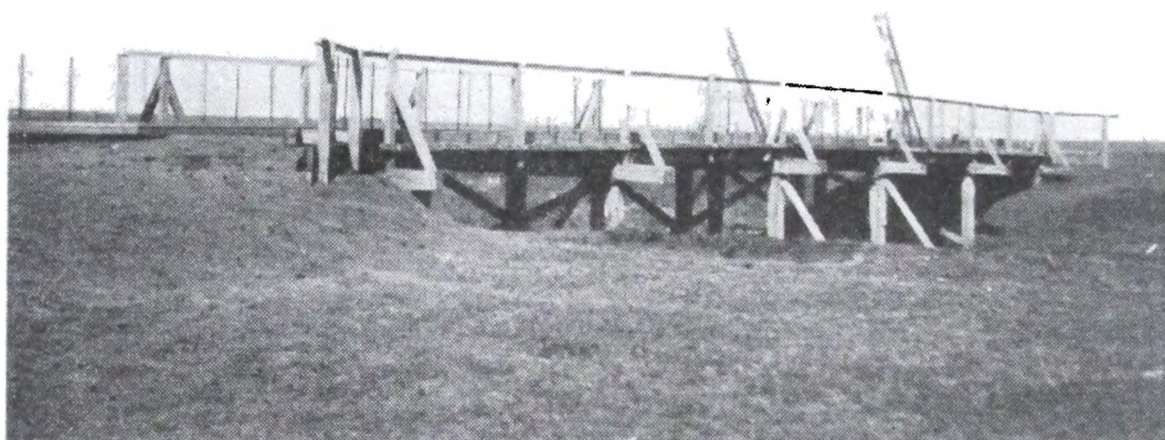
Fot. N° 5. — Canal N° 2 en Km. 14,175. Puente de 25,40 m. de luz con tramo central levadizo.
