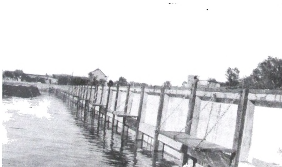
Vista de un muro vertical terminado en lado Oeste de la dársena 2.
