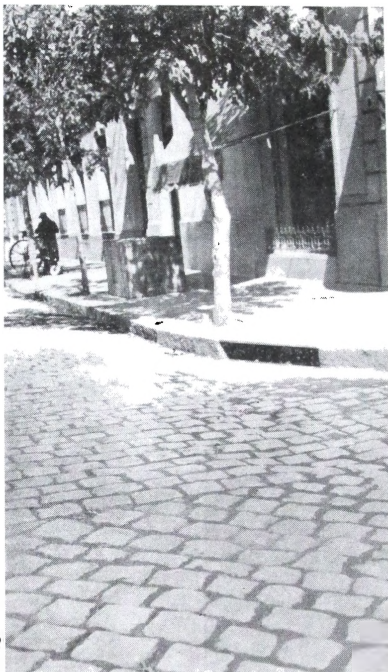
Desagües en Lobos. Boca tormenta en la calle Buenos Aires y Necochea.
