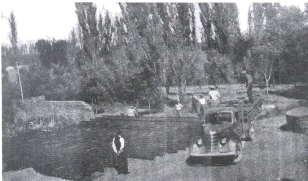
b). 21/III/1938. — Depósito de materiales
