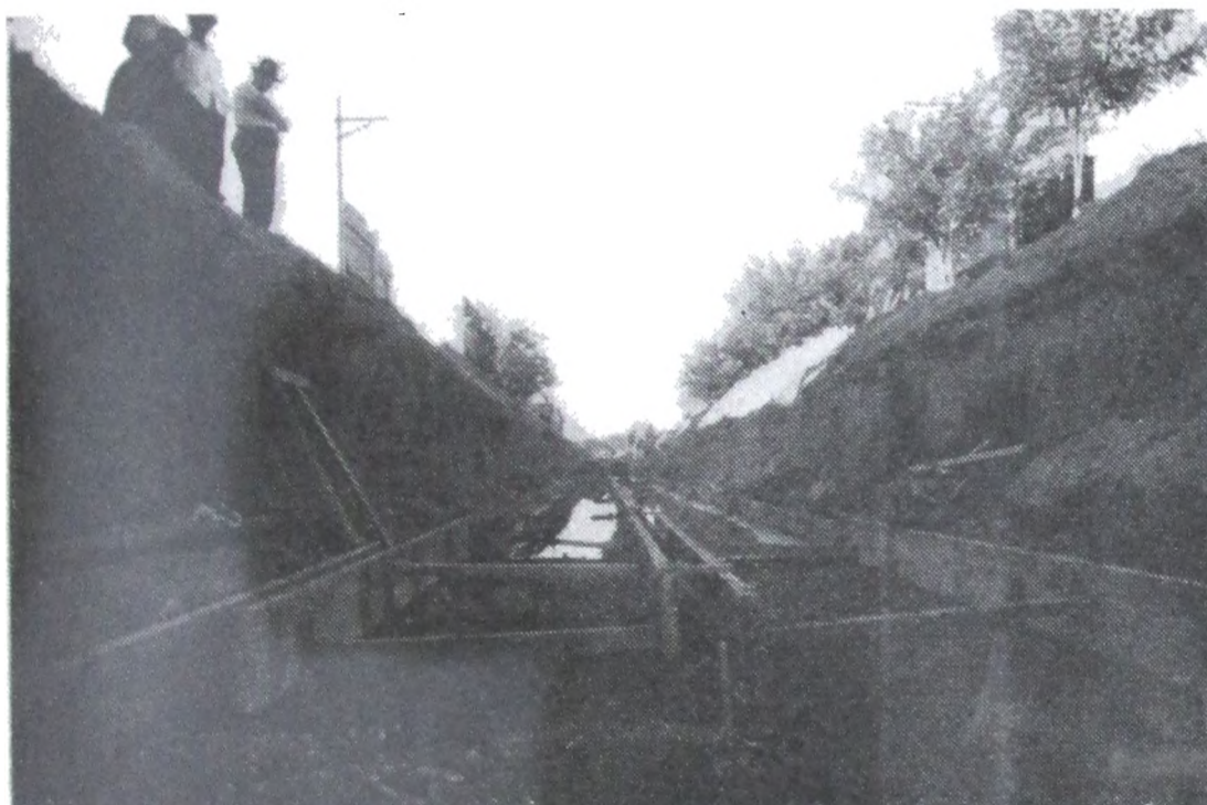
Conducto doble, calle 23 a hormigonar.
