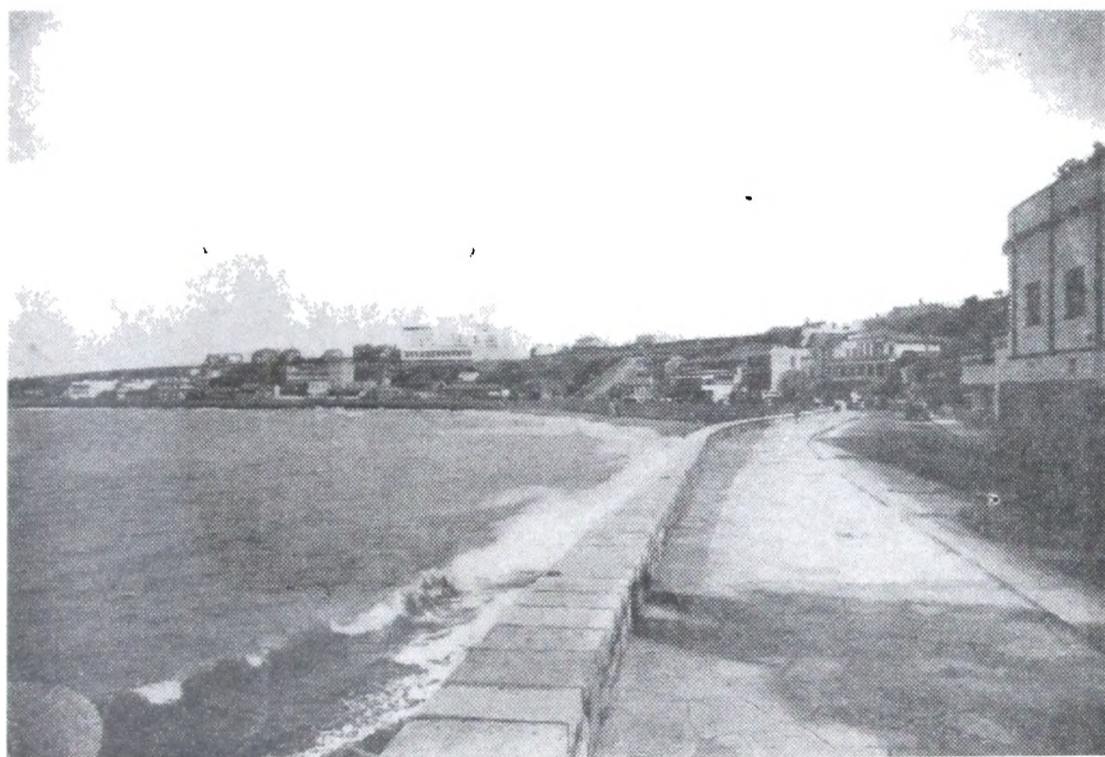
Vista a la sección de enlace entre el 1º y 2º tramo.
