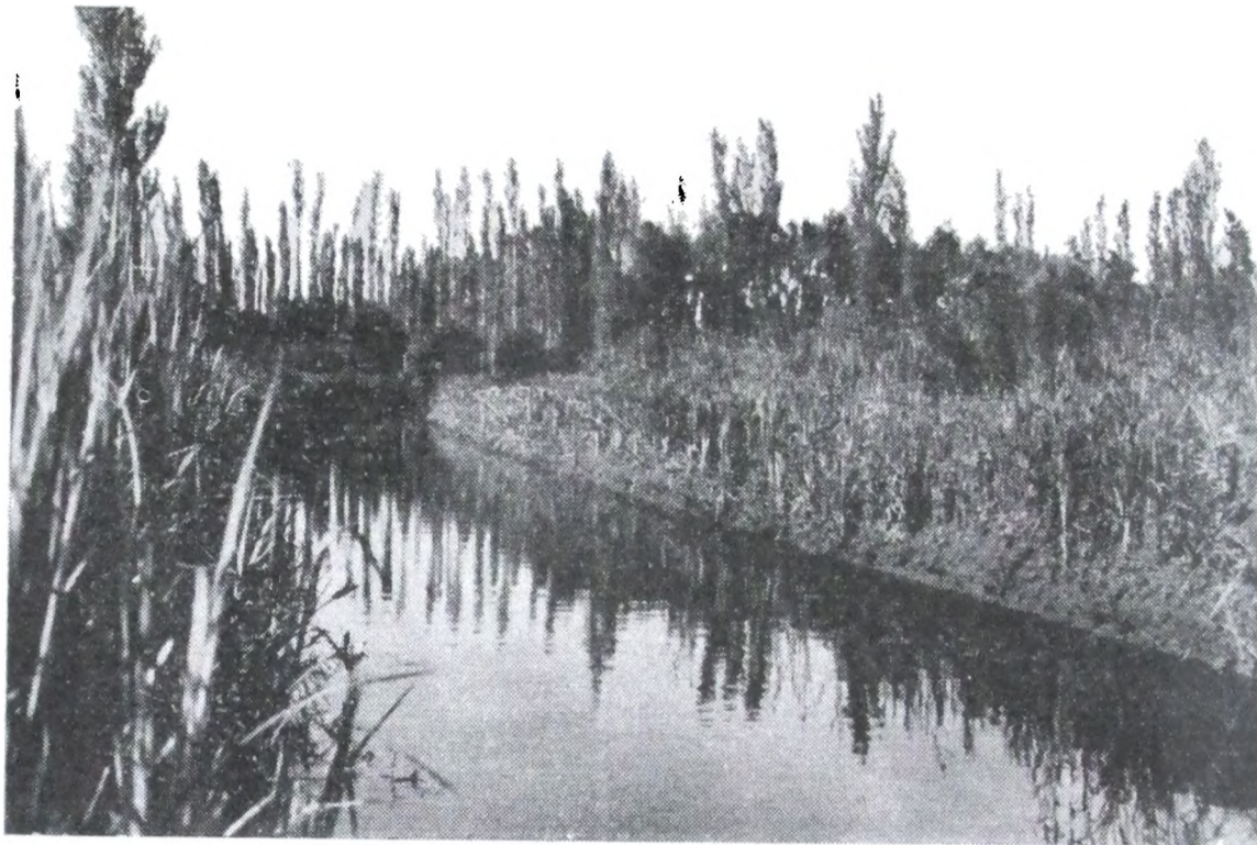
Arroyo Rico (2ª sección de Islas). — Esta vista muestra un tramo de arroyo, terminado.
