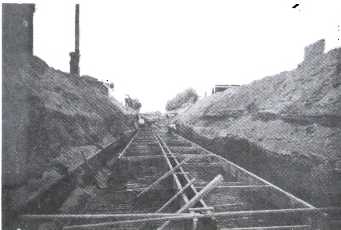
Encofrado conducto do- ble calle 23.
