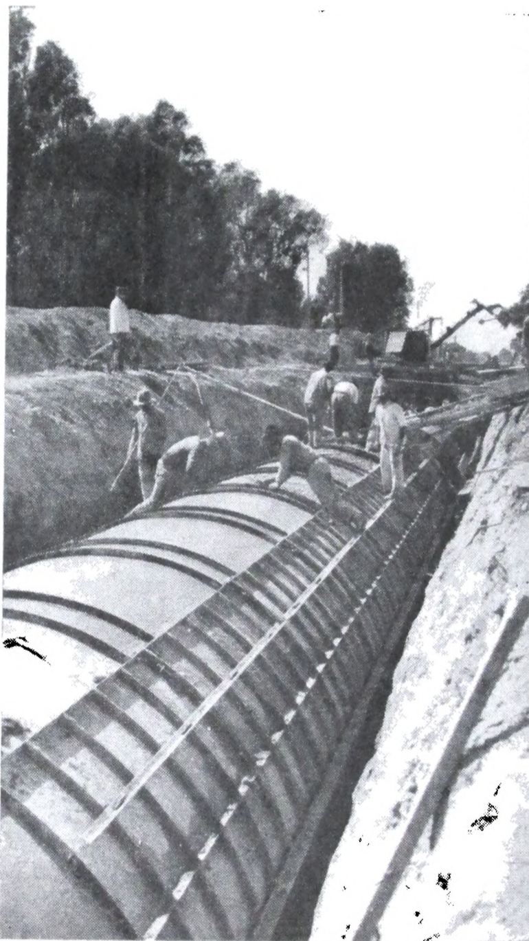
Hormigonando la parte superior del conducto de desagüe en la calle General Viamonte.
