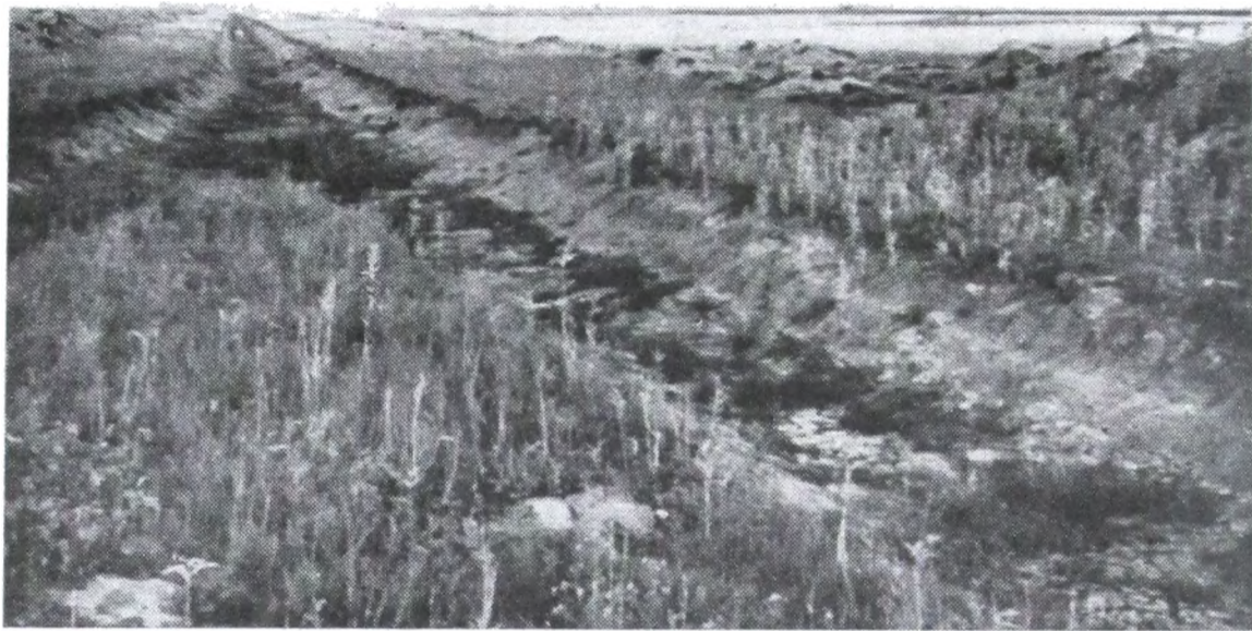
Fot. N° 9. — Plan de obras de Castelli. Ramal a la Laguna Lastra, totalmente terminado.
