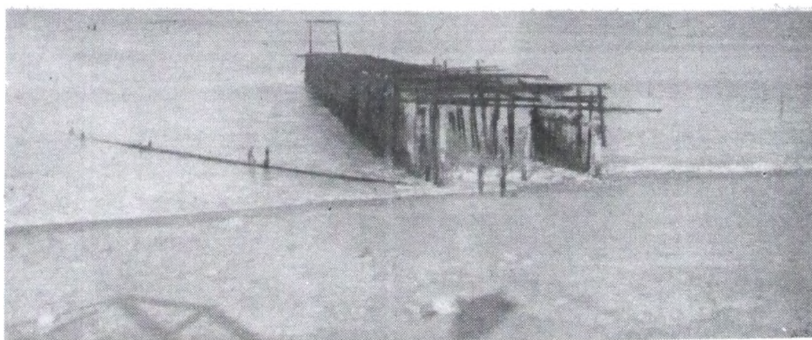
Nº 14. — Playa La Perla — Año 1938. — Estado del espigón particular Ciacaglia y Pierini, sin la piedra del relleno retirada casi totalmente.
