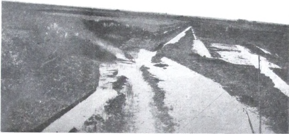
Canal N° 6 (4ª sección de Islas).— Esta vista muestra los trabajos preparatorios de la cuadrilla terraplenera, antes del dragado. A la izquierda puede verse la boca de una zanja que va del Arroyo La Unión, que en la canalización se dejará de un lado para proseguir en línea recta hasta el Río Carabelas.
