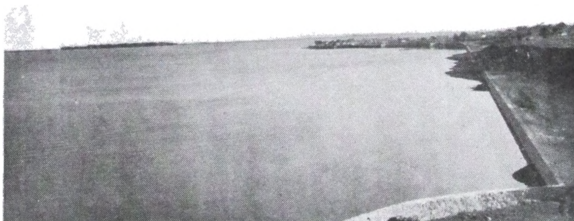
Estado de los trabajos al 31 de diciembre de 1938. — Tramo B
