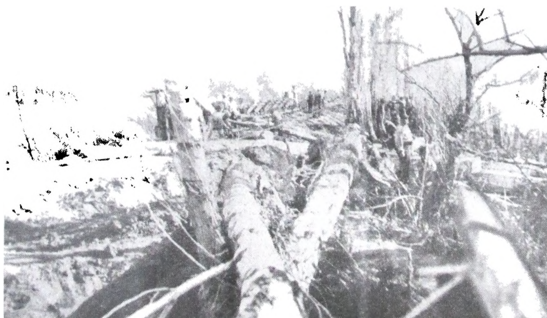
30/VII/1938. — Progresiva 1700 hacia la 1650. Derribando álamos
