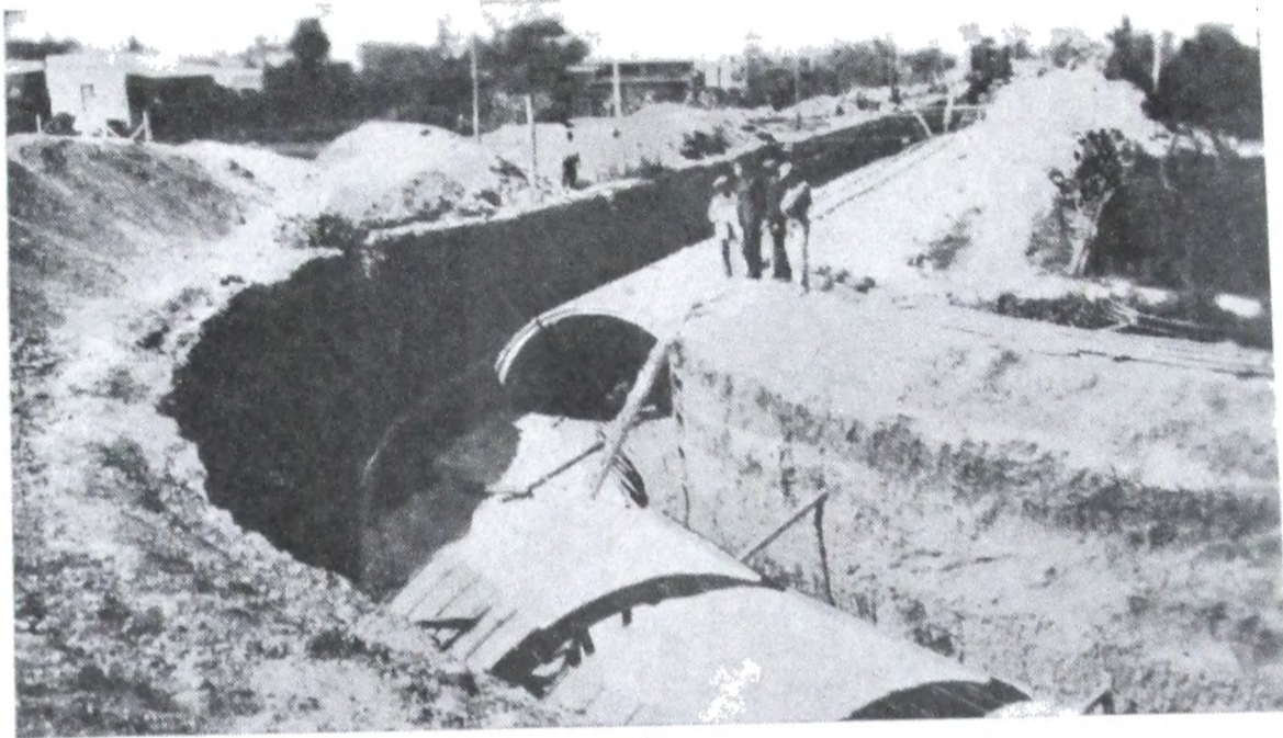
Construcción del conducto de desagüe en la calle Presidente Quintana.
