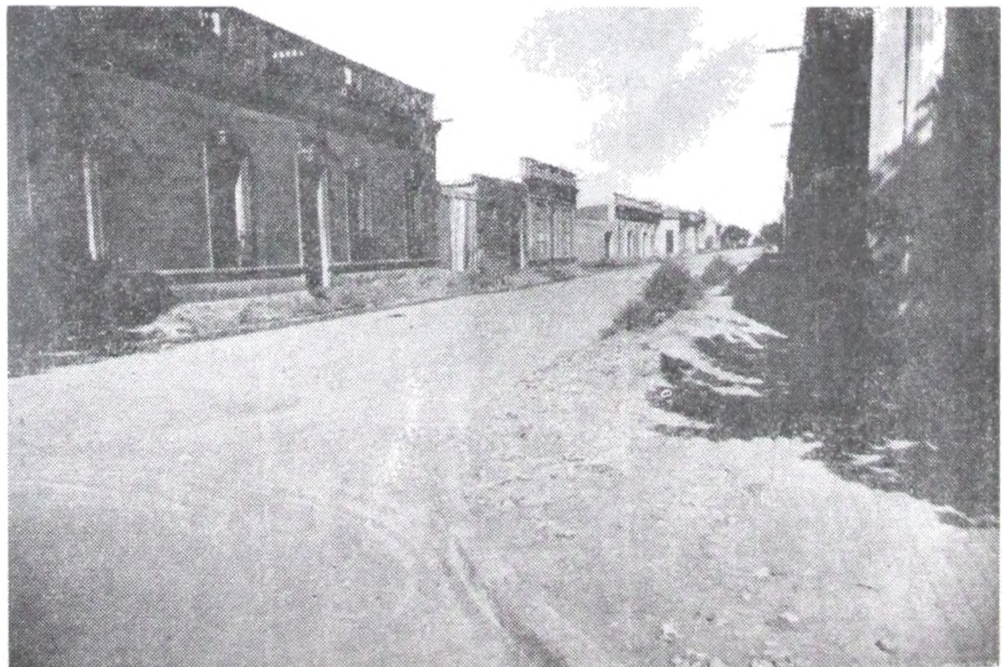
Calle 17 y 16. — Pavi- mento Hormigón Armado.
