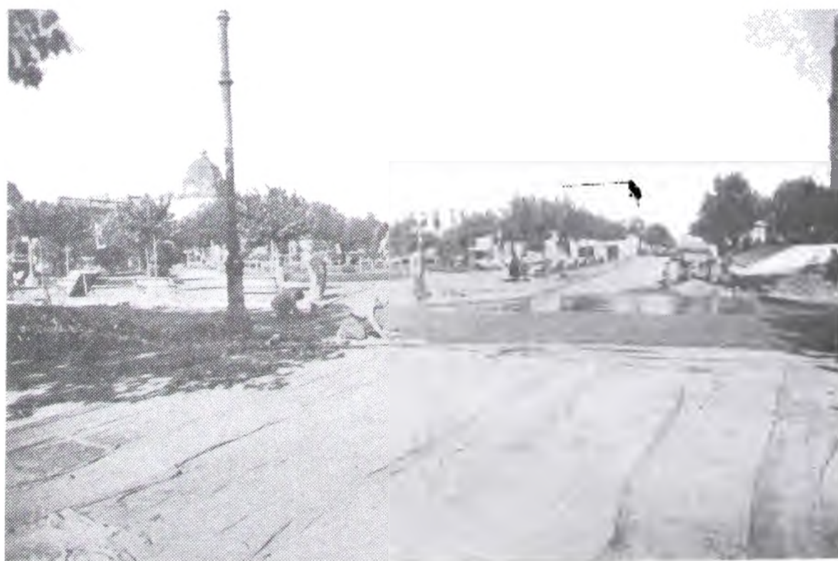
Frente a la Plaza rectificando líneas de cordones
