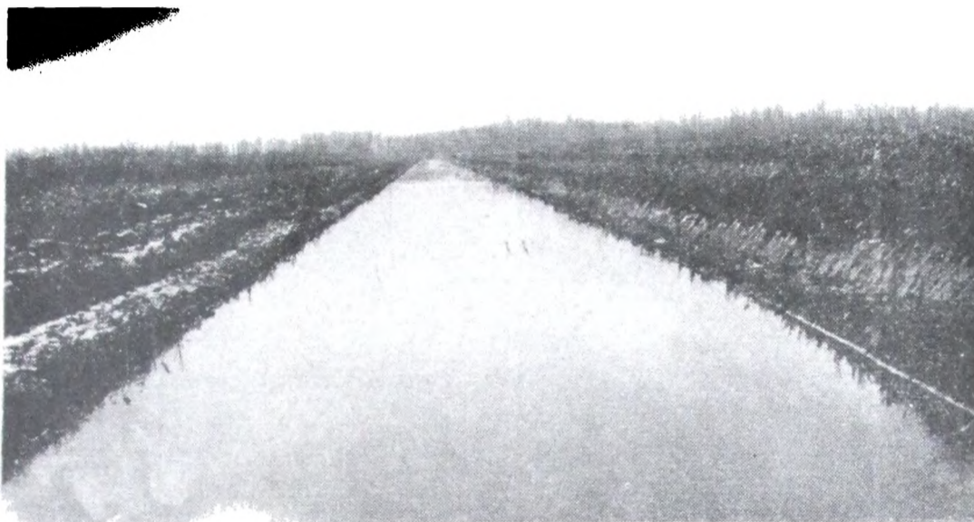
Arroyo Canelones (2ª sección de Islas).— Esta vista muestra la zanja terminada, que rectifica el Arroyo Canelones uniéndolo con el Arroyo Fredes. Este trabajo fué hecho en su totalidad con cuadrilla.
