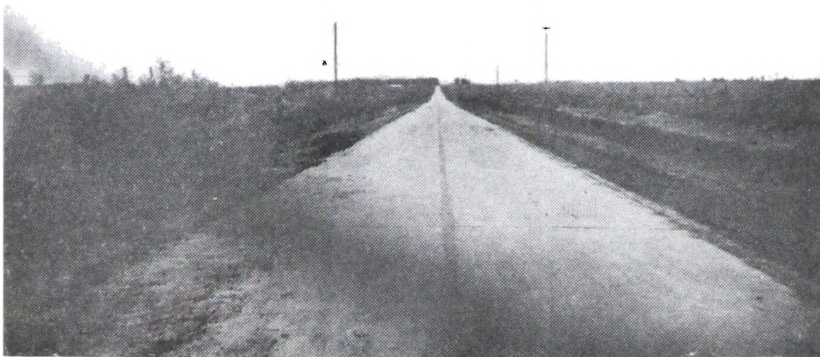
Avenida San Martín. Pavimento Hormigón Armado.
