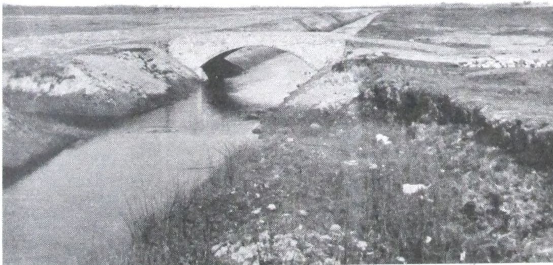
Puente de 6,10 ms. luz, chapa «Armco», sobre el canal de alimentación del canal del Norte, ensanche y profundización. Mayo 1938.
