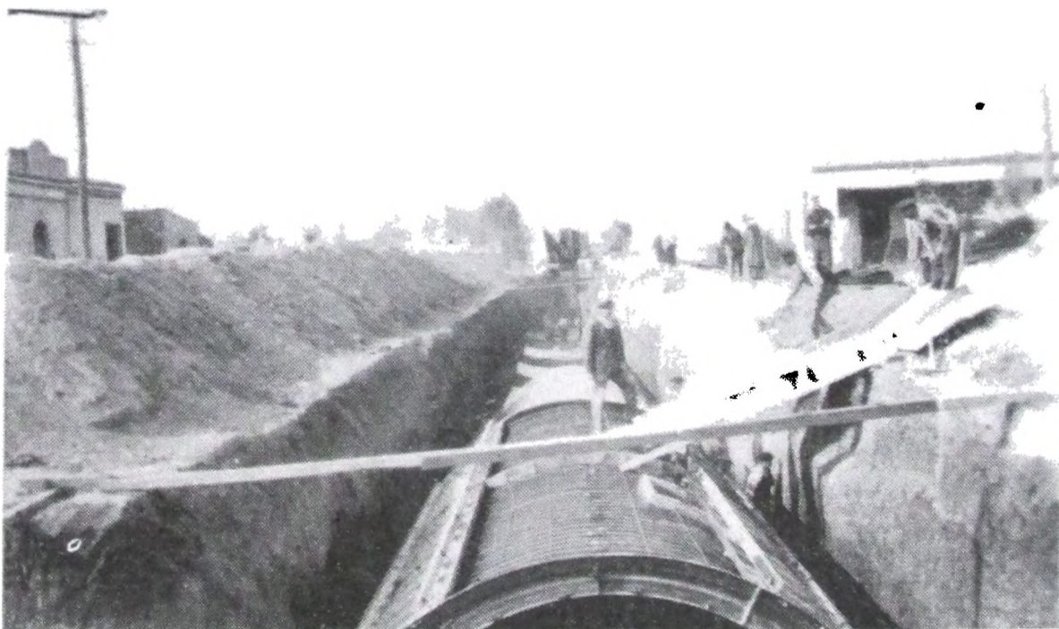
Colocación del encofrado metálico para la construcción del conducto de desagüe en la Avenida Talleres.
