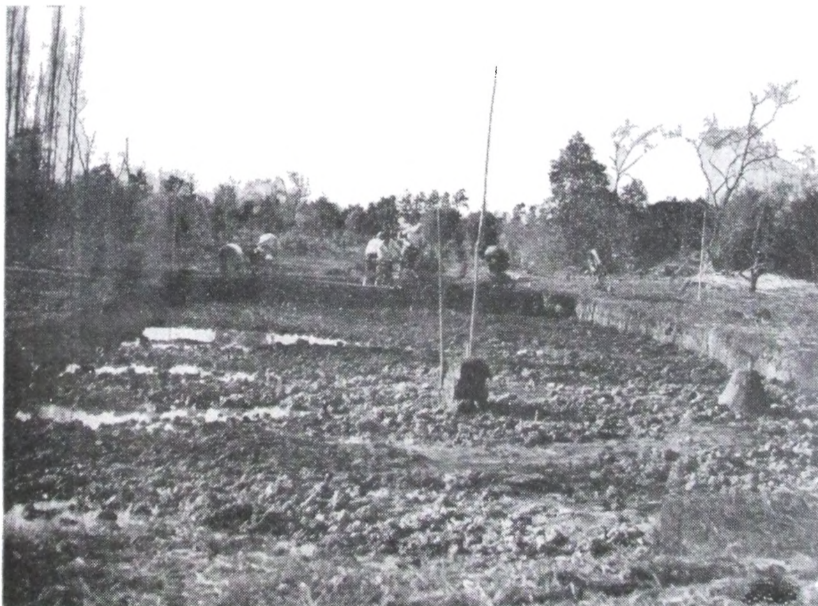
Arroyo Fredes (2ª sección de Islas). — Esta vista muestra los trabajos preparatorios de la cuadrilla para el dragado de la rectificación del Arroyo Fredes para su comunicación con el Río Paraná Miní.
