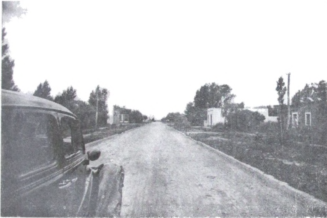
Calle Pavimento Hormi- gón Armado.
