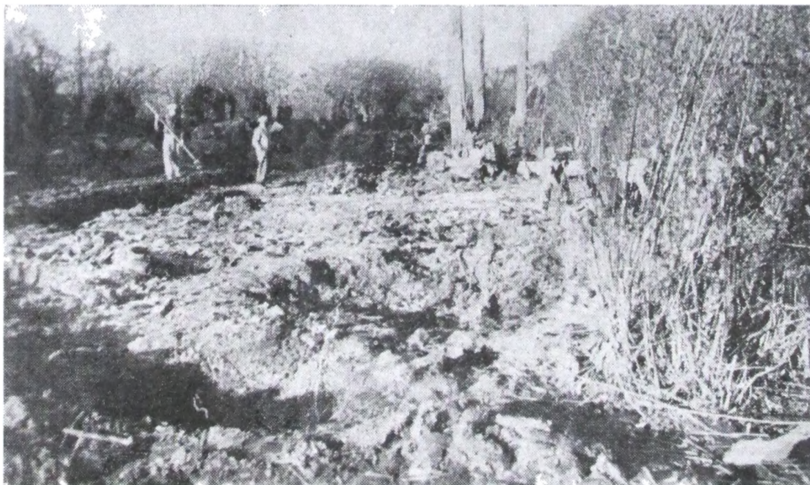
b). 13/VI/1938. — Progresiva 1200 hacia la 1300. Durante el desmorte
