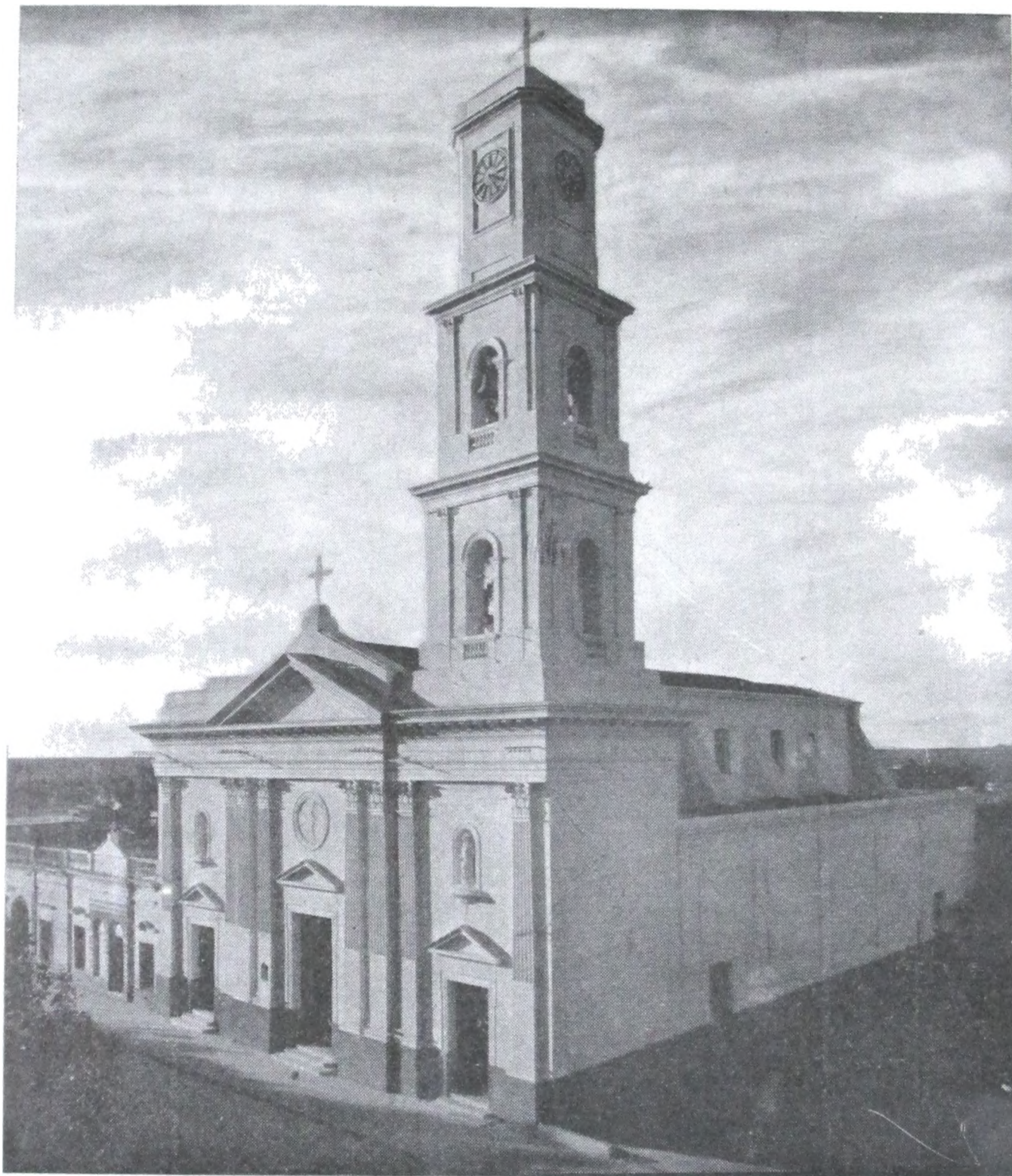
Vista de conjunto
