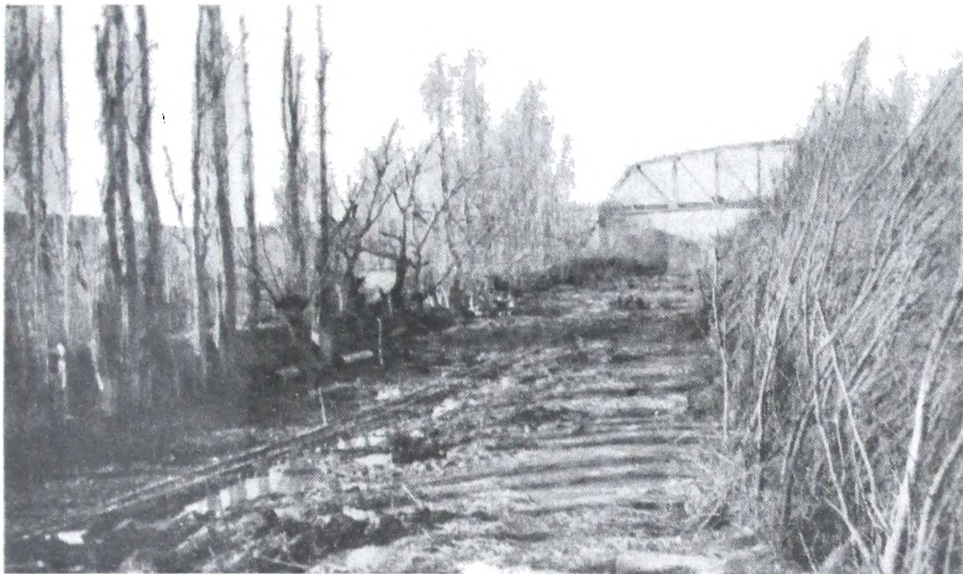
12/VII/1938. — Prog. 1630 hacia la prog. 1700; después del desmonte y al iniciar la construcción del terraplén
