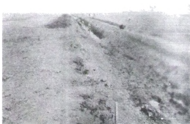
Vista en Estac. 20 hacia aguas abajo.
