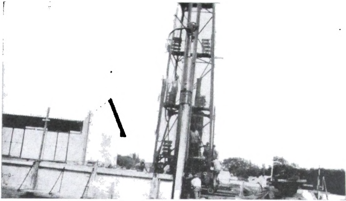
Comienzo de la hinca del tablestacado metálico en lado Oeste, cabecera dársena 2.
