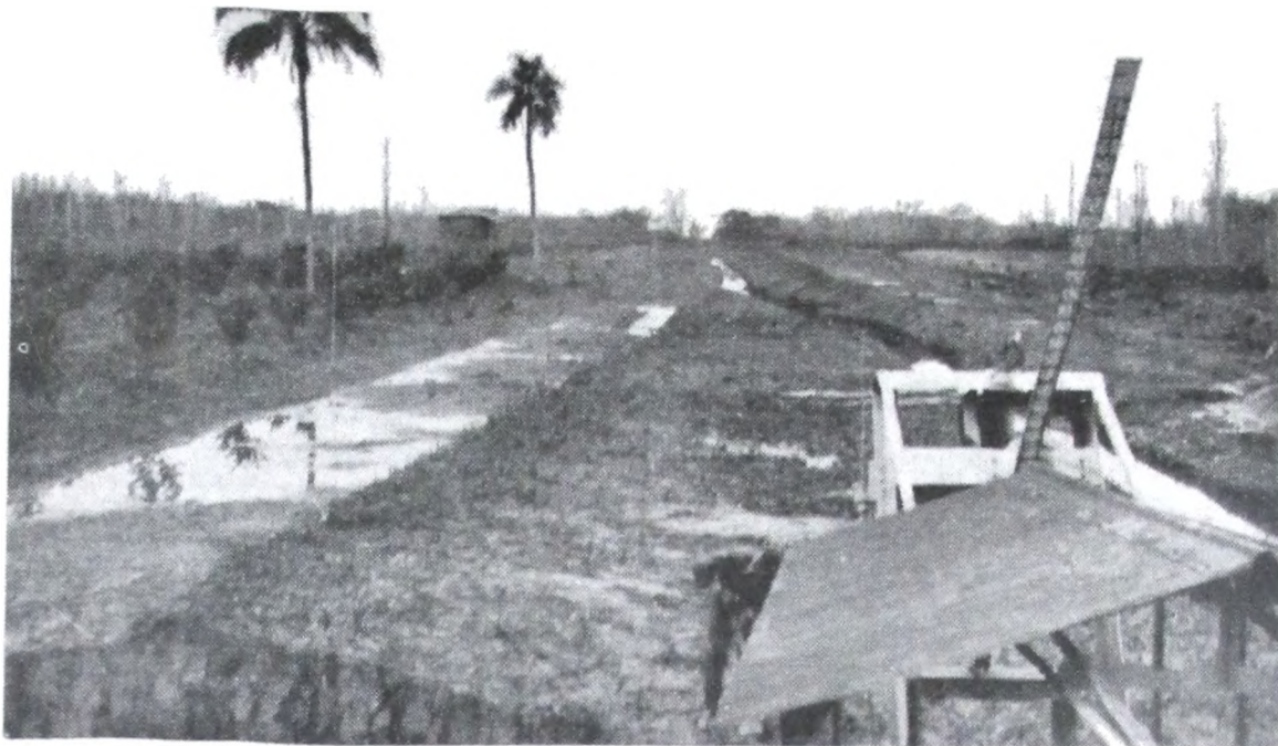
Arroyo Manzano de la Barca (3ª sección de Islas).— Durante los trabajos de dragado realizados con la draga 253 D.
