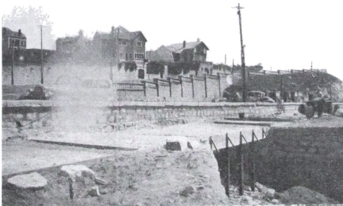
Nº 22. — Pileta Municipal — Año 1938. — Losa de unión en la vereda interna, entre la pileta y espigón P. Iglesia.
