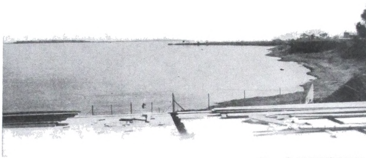
Vista antes de iniciarse la construcción. — Tramo B
