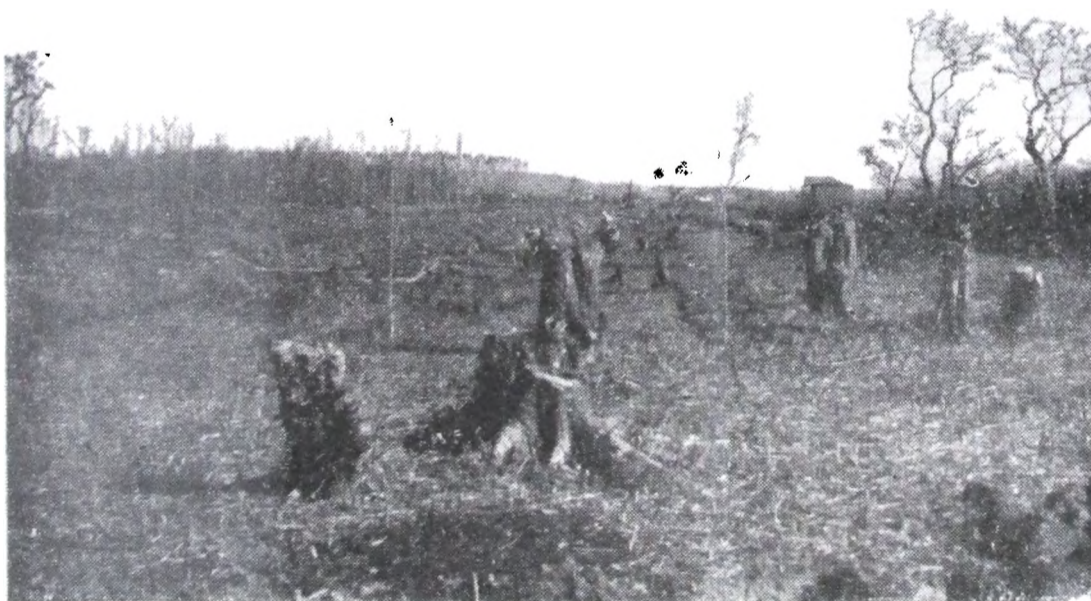
Arroyo Manzano de la Barca (3 a sección de Islas). — El mismo tramo descrito anteriormente, donde pueden apreciarse los trabajos de la cuadrilla terraplenera en la limpieza de la cancha del dragado, corte de árboles, troncos que deberán ser previamente sacados, construcción de tajamares para el material extraído, etc.
