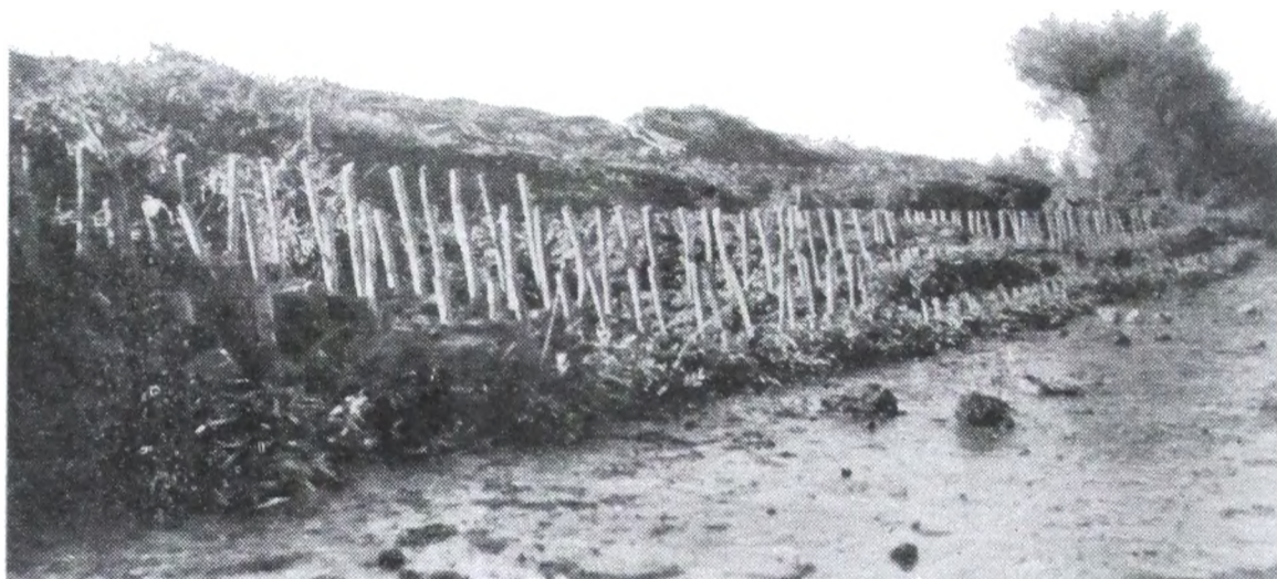
b). 17/IV/1938. — Construcción de la palizada entre las estacas 8 y 9
