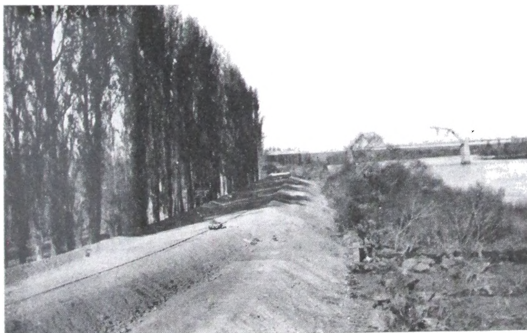
30/IX/1938. — Prog. 1350 hacia la prog. 1675 al terminar el terraplén entre las mismas
