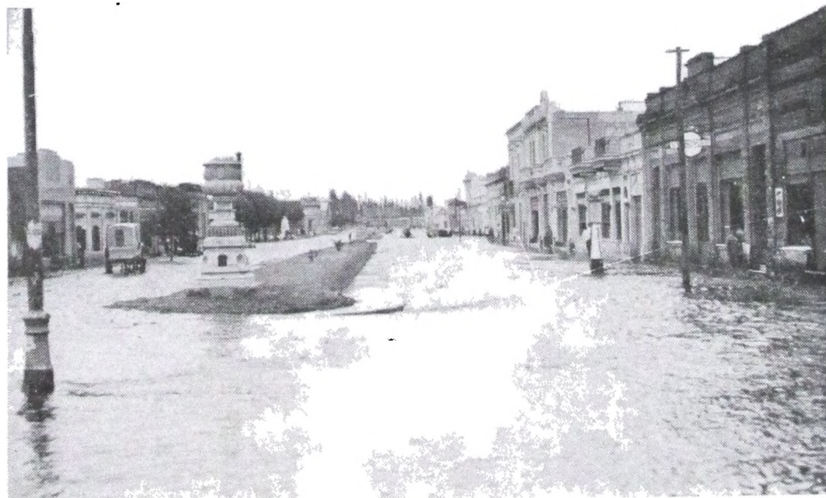
Avenida Eduardo Casey, en su intersección con la calle España, después de una lluvia de 60 mm.
