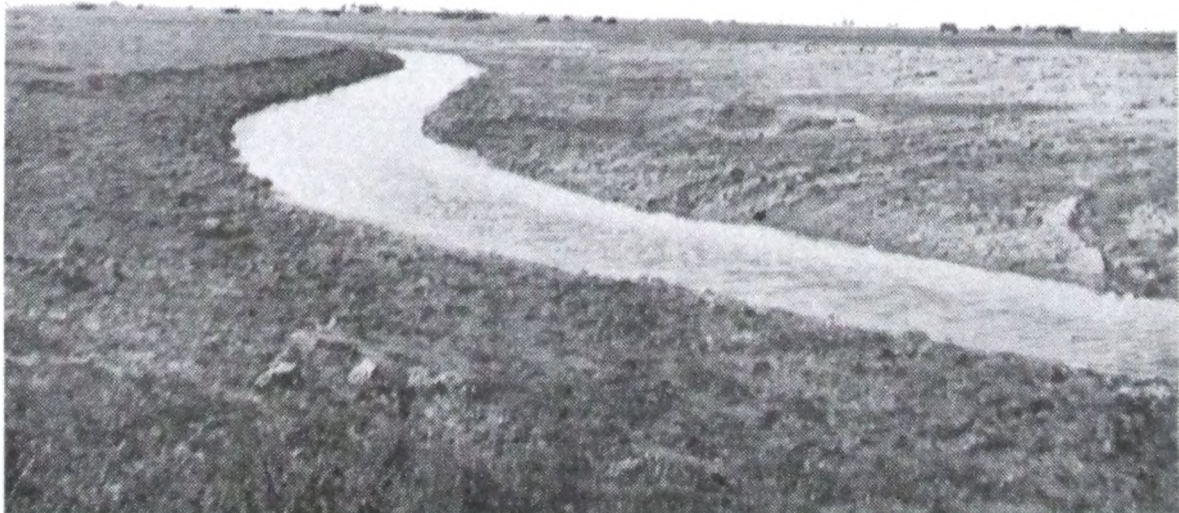
Fot. N° 34. — Canalización del Arroyo «El Siasgo». Vista de un trecho de canal terminado.
