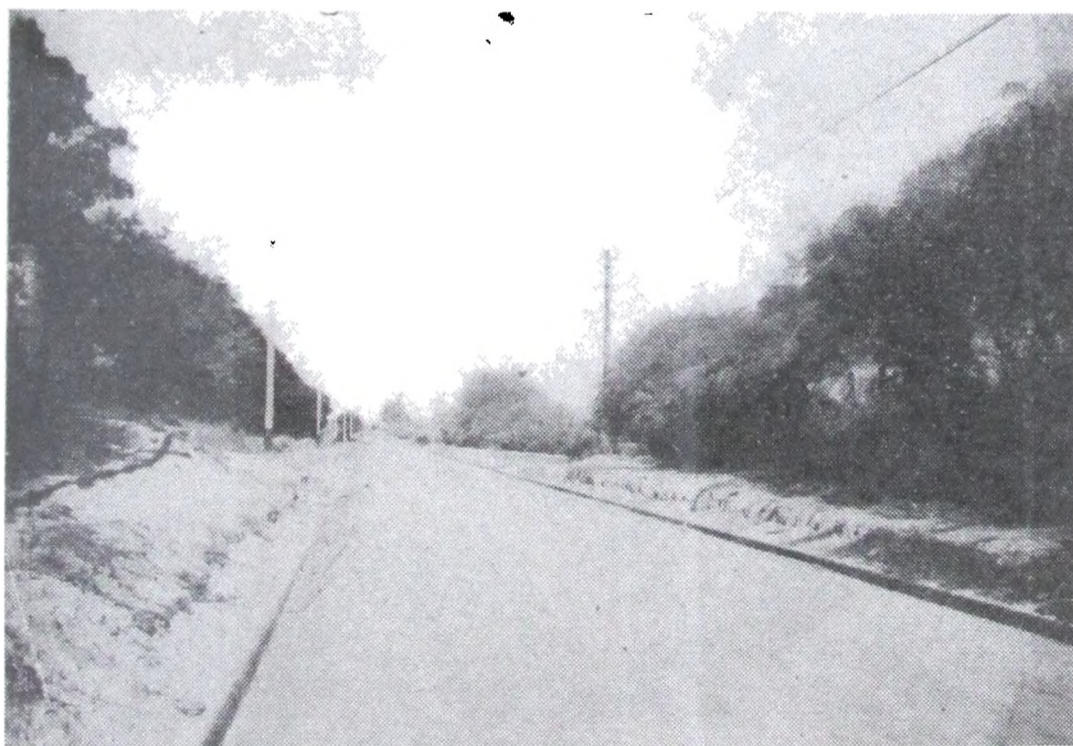
Calle Molina Arrotea. Pavimento Hormigón Armado.
