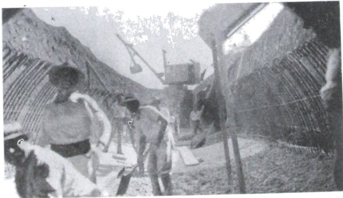
Hormigonado de la platea del conducto de desagüe en la Avenida Granaderos.
