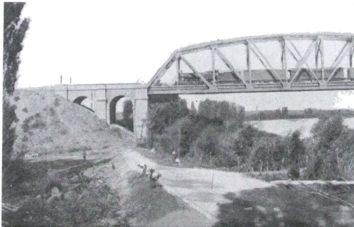
28/XI/1938. — Después del desmonte y al iniciarse la construcción del terraplén
