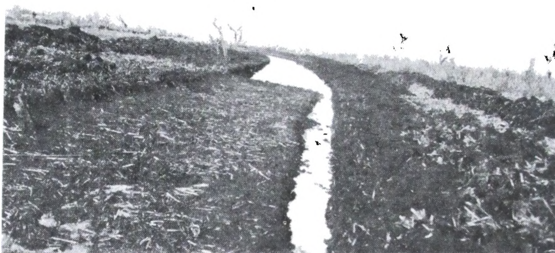
Arroyo Méndez Grande (3ª sección de Islas).— En primer plano una faz de los trabajos de la cuadrilla; limpieza y guadañado y una canaleta para desagüe. En segundo plano se puede ver cómo va quedando el arroyo una vez terminado.
