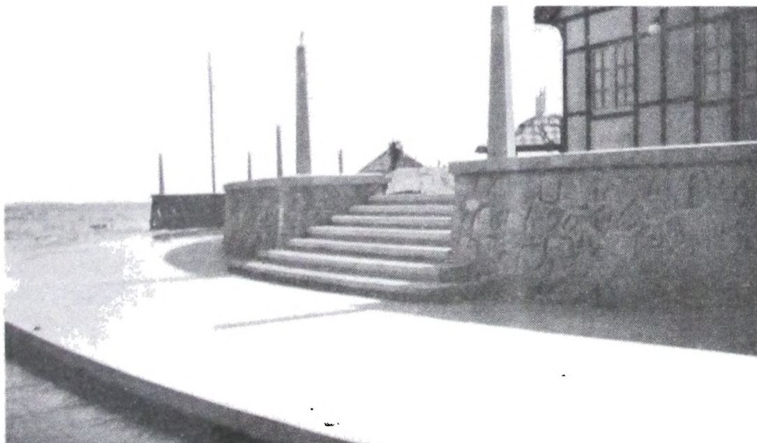
Detalle de la construcción
