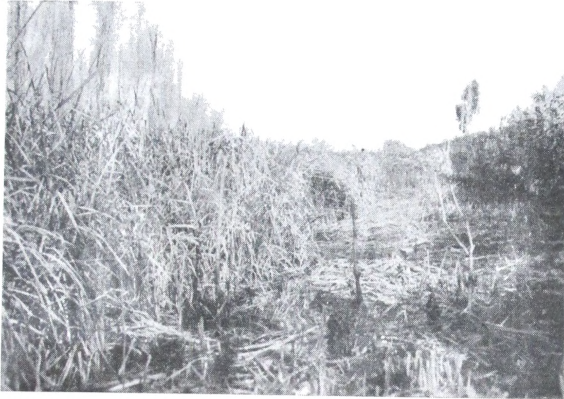
Arroyo Rico (2 a sec. de Islas). — Vista del arroyo antes de su limpieza.
