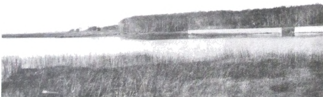
Estado de los trabajos al 31 de diciembre de 1938. — Tramo A
