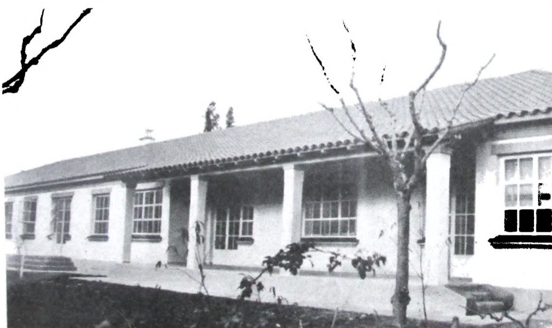
Vista de las galerías de cura
