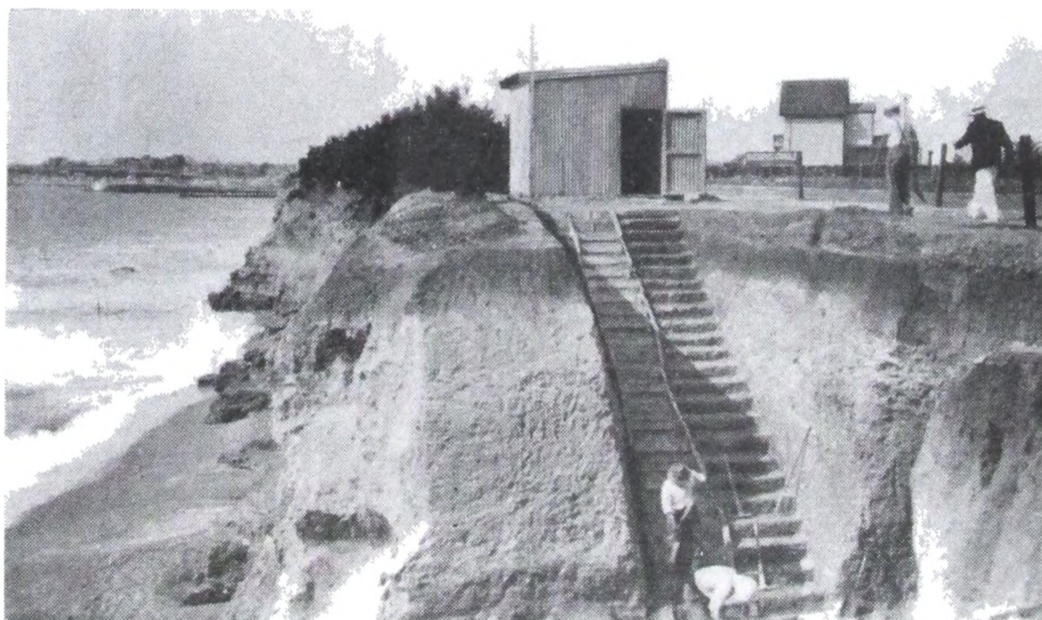
Nº 6. — Espigón «Asilo Unzué» — Año 1938. — Escalera practicada en la tosca. Se colocaron peldaños provisionarios de madera, reemplazados posteriormente por hormigón.
