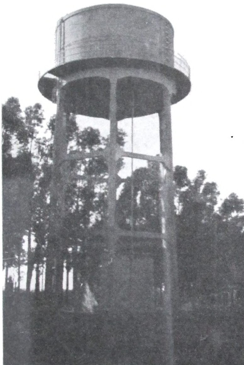
Tanque de hormigón armado
