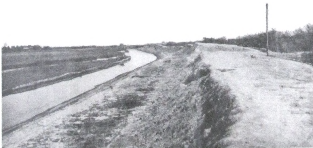
Durante los trabajos en el tramo del Hm. 0 al 6.
