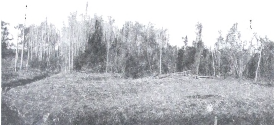
Arroyo Manzano de la Barca (3 a sección de Islas). — Tramo a canalizar en las proximidades del Río Paraná Guazú. Puede verse el lugar, antes del dragado del citado arroyo, que una vez canalizado unirá el Río Barca Grande con el Río Paraná Guazú, con una vía navegable de unos 5,5 kilómetros de longitud.
