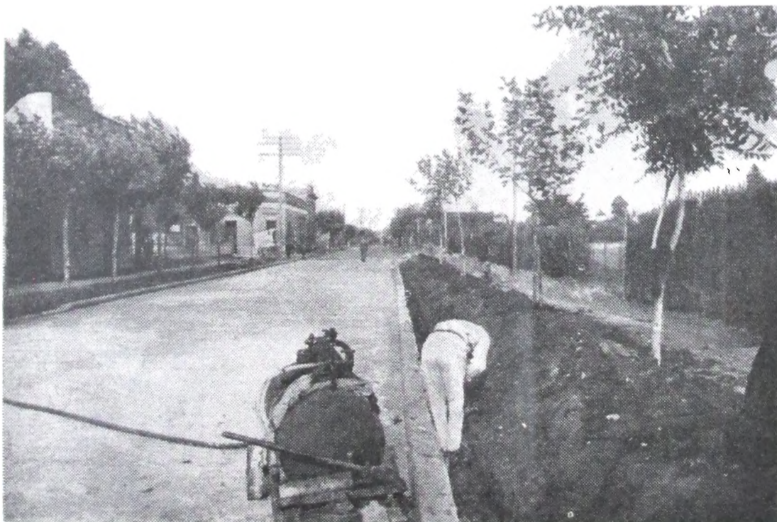
Pavimento de Hormigón Armado.
