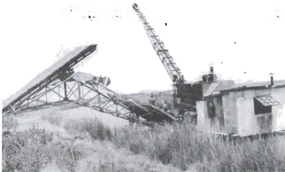
Fot. N° 26. — Prolongación del canal de «El Palenque» al Cañadón del Malo. Excavadora sobre pontones utilizada en la ejecución de esta obra.
