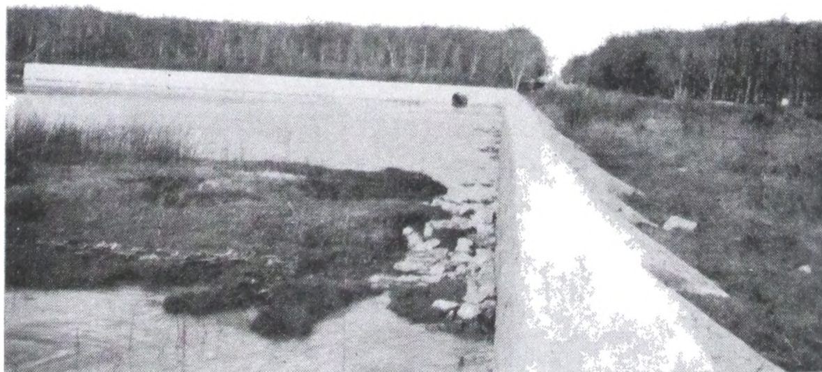
Estado de los trabajos al 31 de diciembre de 1938.— Tramo B
