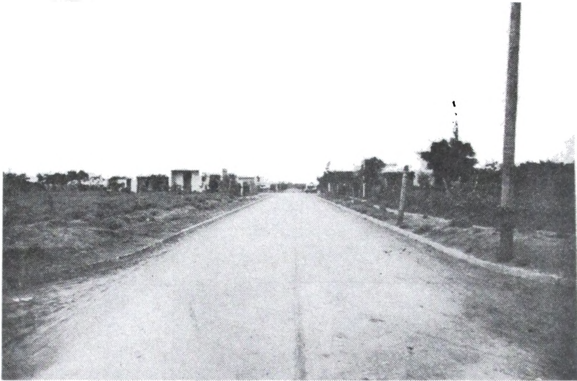
Avenida Cruz. Pavimento Hormigón Armado.
