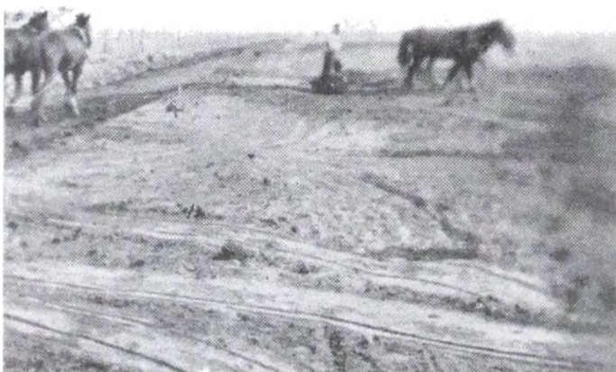
Excavación con palas de buey en Estación 21.
