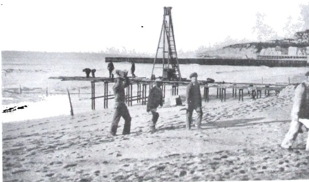
Nº 16. — La Perla — Año 1938. — Limpieza de playa, viéndose en segundo término al espigón La Perla N° 2 en construcción.
