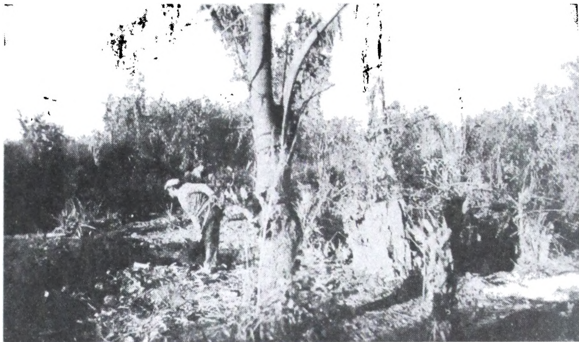
a). 22/II/1938. — Progresiva 1200 hacia la 1250. Antes de iniciar el desmorte
