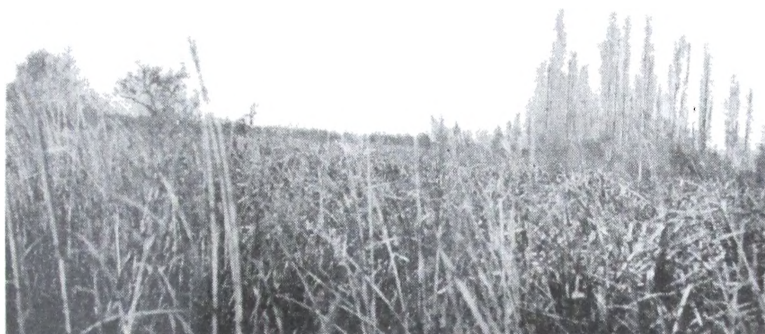
Arroyo Las Piedras (4ª sección de Islas).— Vista del arroyo antes de su limpieza. Nótese el pajonal en el cauce.
