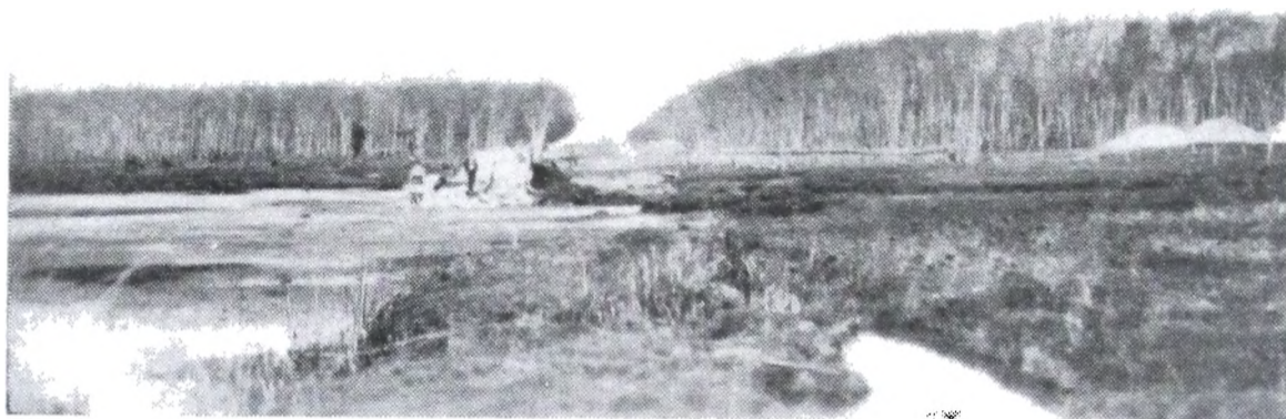
Vista tomada antes de iniciarse la construcción.— Tramo B
