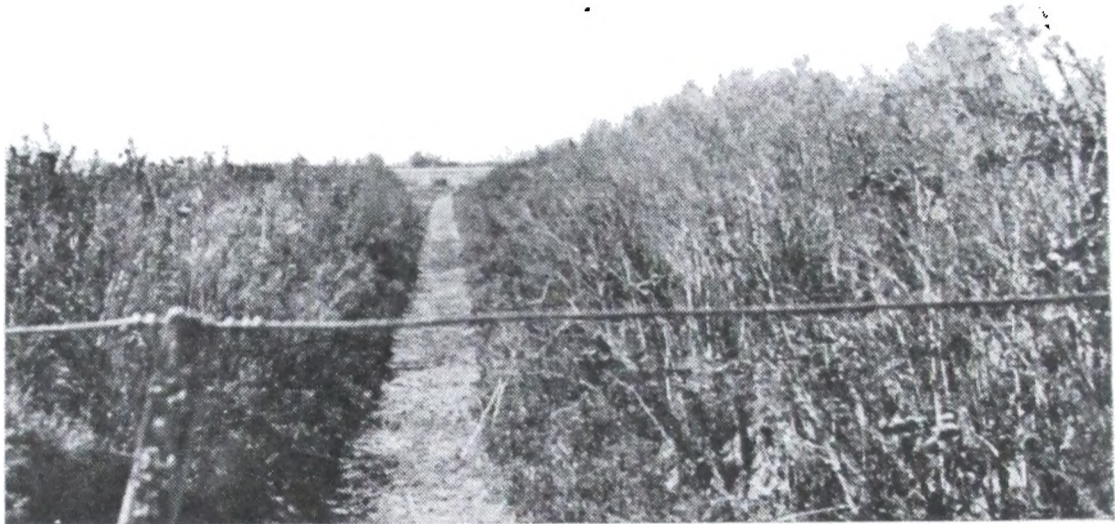
Fot. N° 33. — Limpieza de los canales de Lezama. Trecho de canal terminado.
