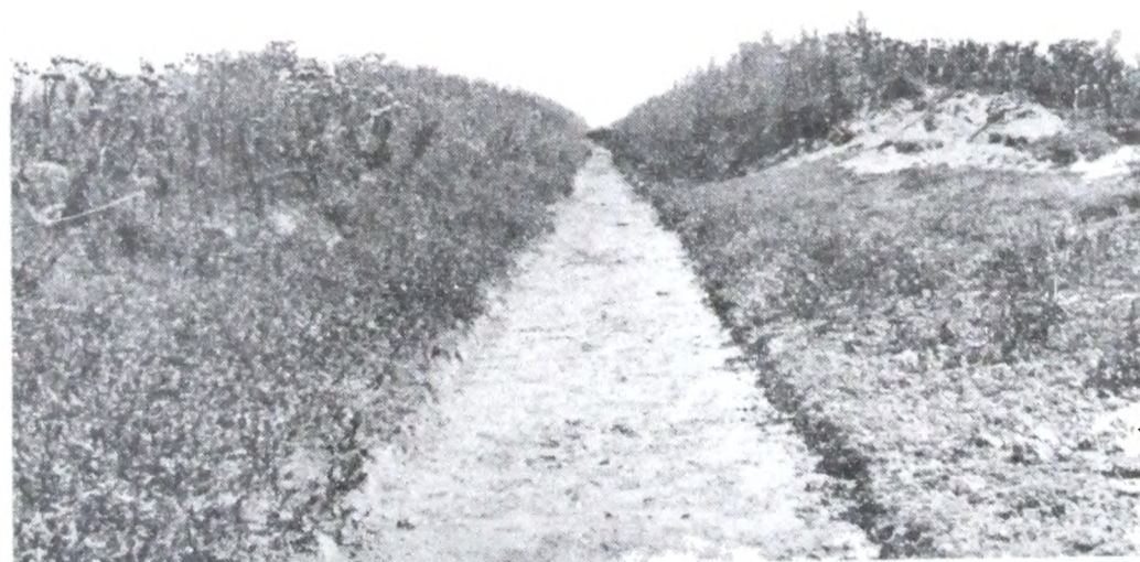
Fot. N° 32. — Limpieza de los canales de Lezama. Trecho terminado.
