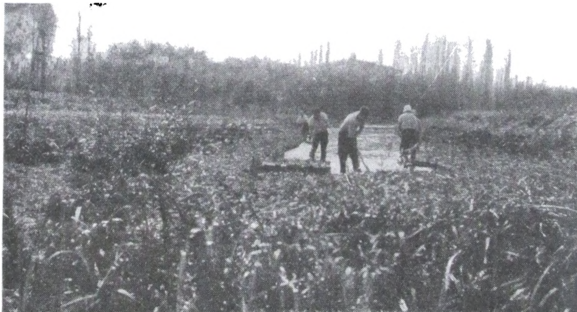
Arroyo Canelones (2ª sección de Islas). — Esta vista muestra los trabajos de la cuadrilla en la rectificación del Arroyo Canelones para unirlo con el Arroyo Fredes.
