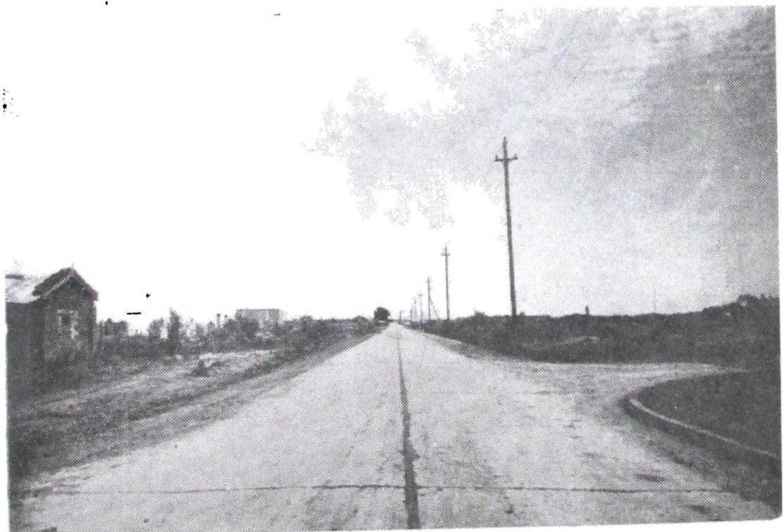
Avenida Tapiales. Pavimento Hormigón Armado.
