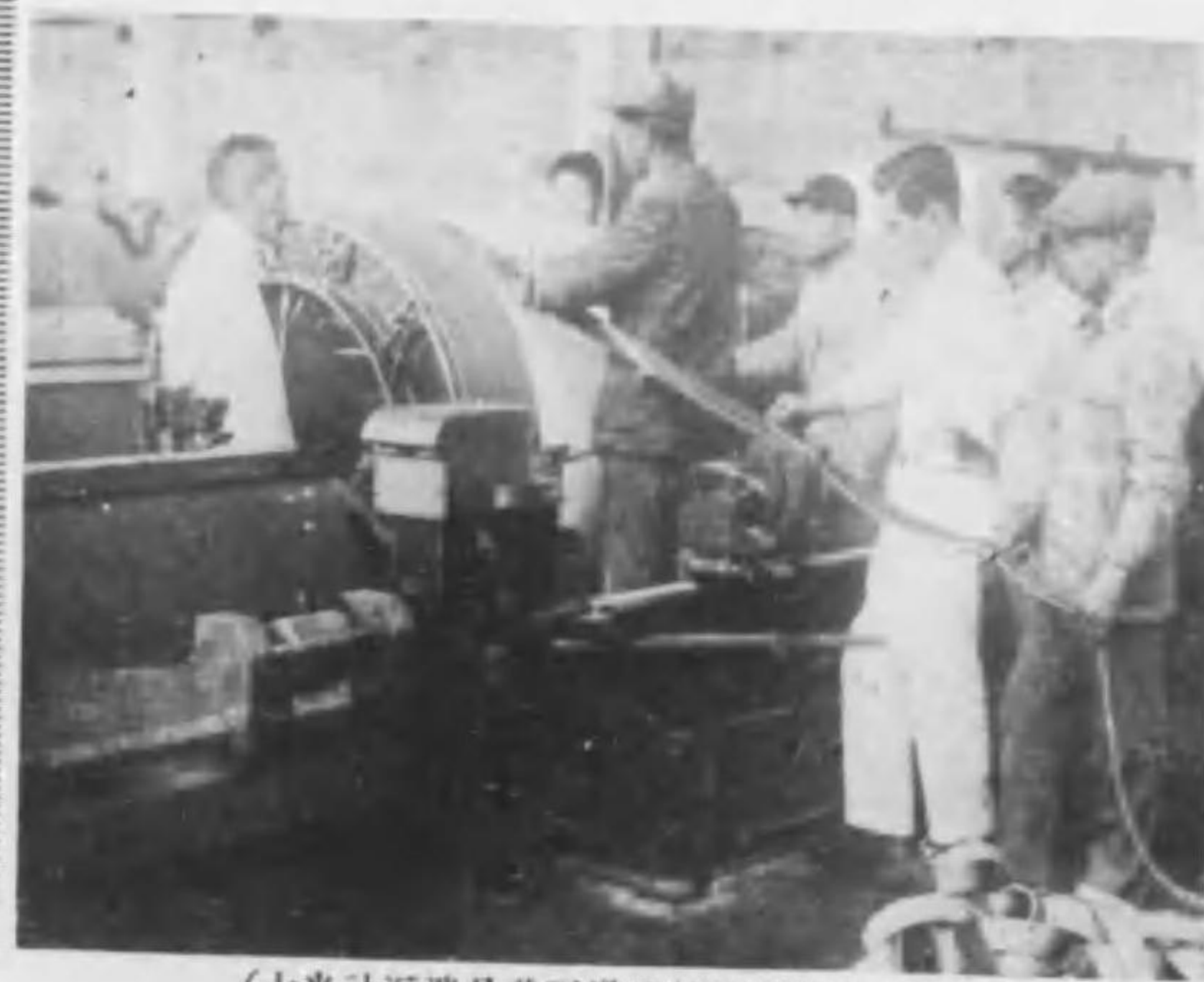
(大光社派遣員某工場殿梳棉機据付實況)
