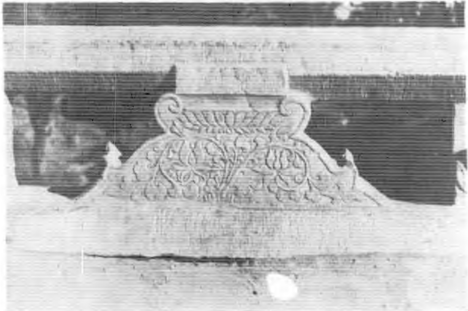
永通橋正德二年欄版駝峯 (甲)
