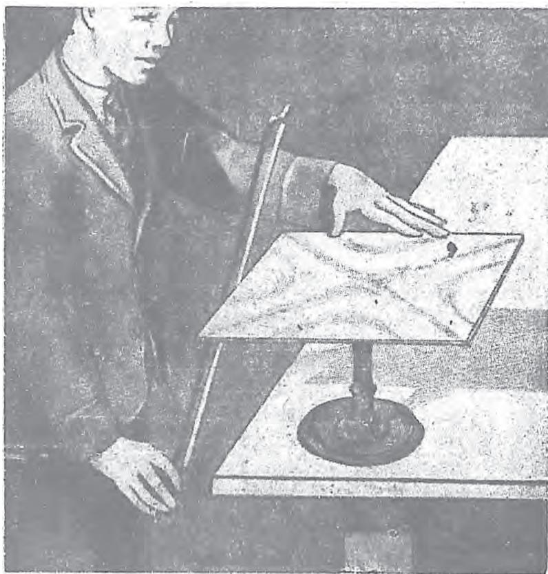
圖五 把細砂置在板上，用弓弦在板緣拉動，砂即排成各式花紋。
