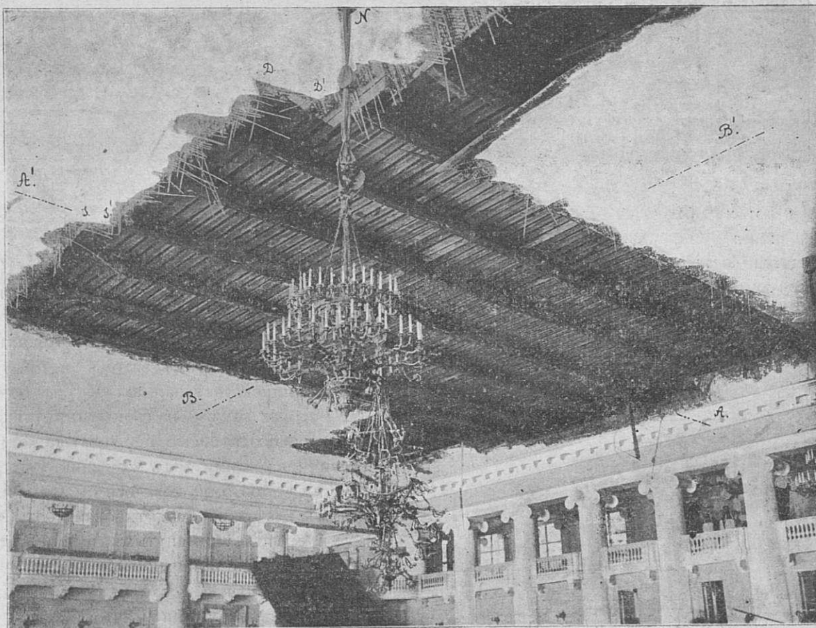
Фиг. 1. Потолокъ зала Таврическаго дворца послѣ обрушенія.
