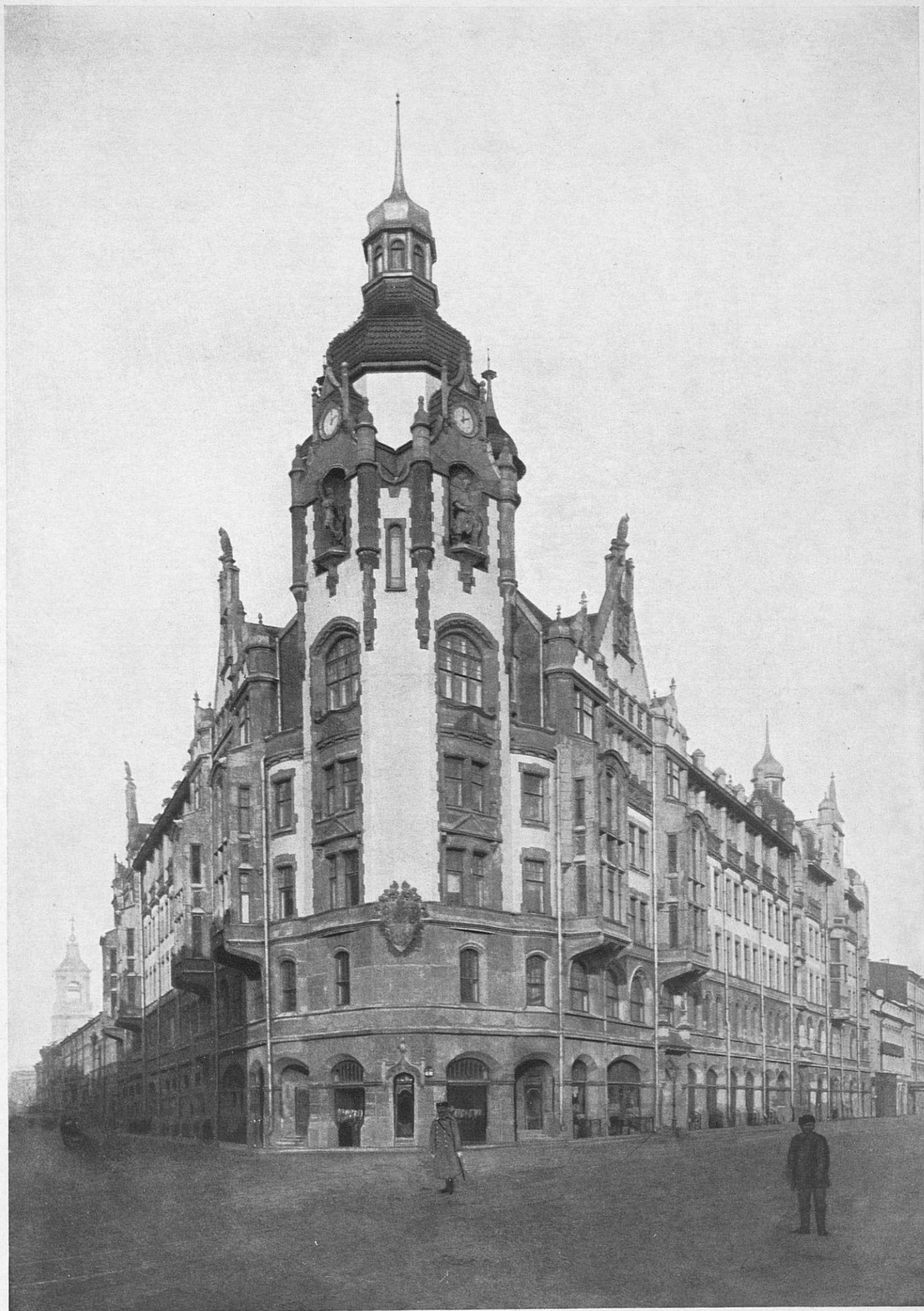
Видъ съ угла Садовой ул., и Вознесенскаго проспекта.
