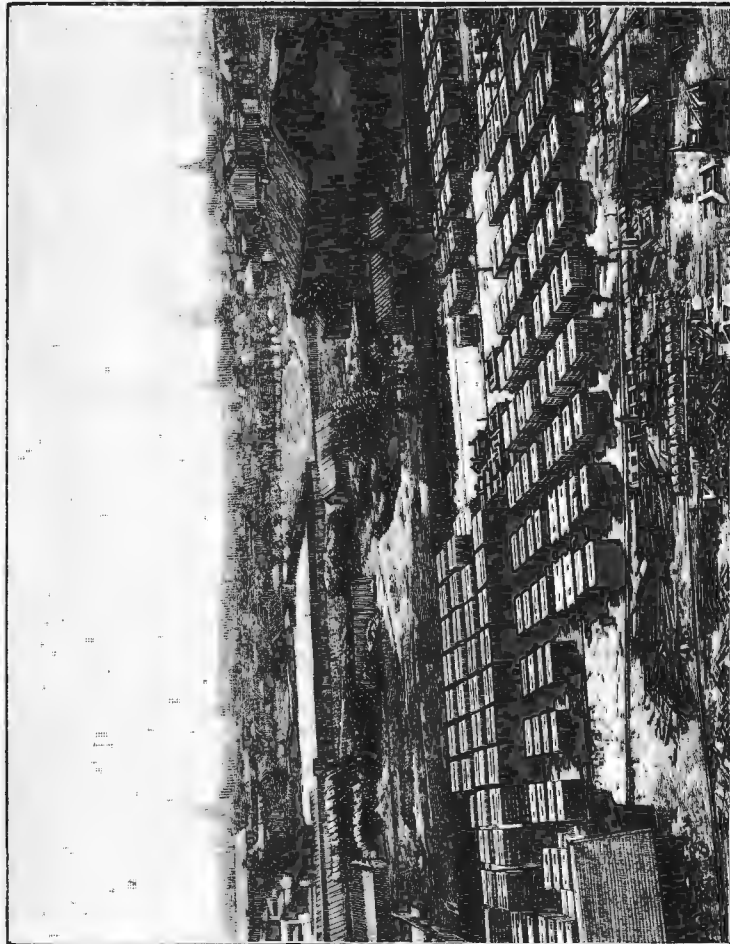
Сооруженіе коммерческаго порта въ Либавѣ. Рис. 6. Общій видъ расположенія массивовъ. Съ фот. грав. Флягель.
