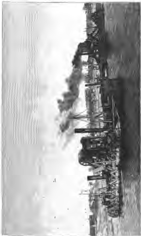
Сооруженіе коммерческаго порта въ Либавѣ. Рис. 3. Землечерпательная машина, работающія въ ковшѣ. Съ фот. грав. Рашевскій.
