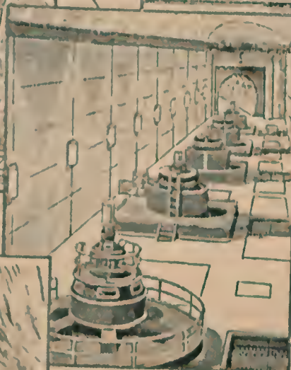
Usina Nilo Peçanha com capacidade instalada de 330.000 kw, a 1ª usina subterrânea a funcionar na América do Sul. Uma usina semelhante está sendo construída em Cubatão, onde 200.000 kw de energia elétrica serão adicionados ao sistema em 1956.
