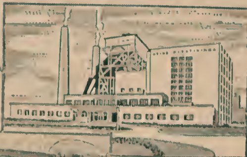
Usina Termelétrica Piratininga em São Paulo, com capacidade instalada de 100.000 kw.
