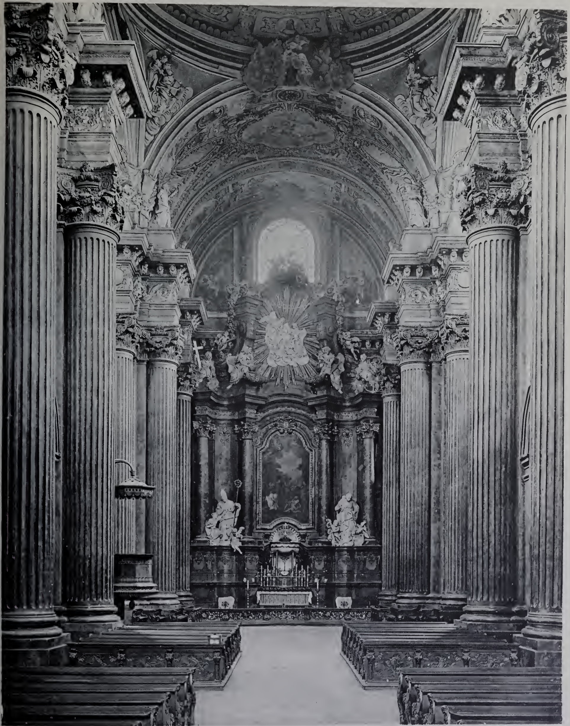
Architekt: Bartholomaeus Wasowski.
