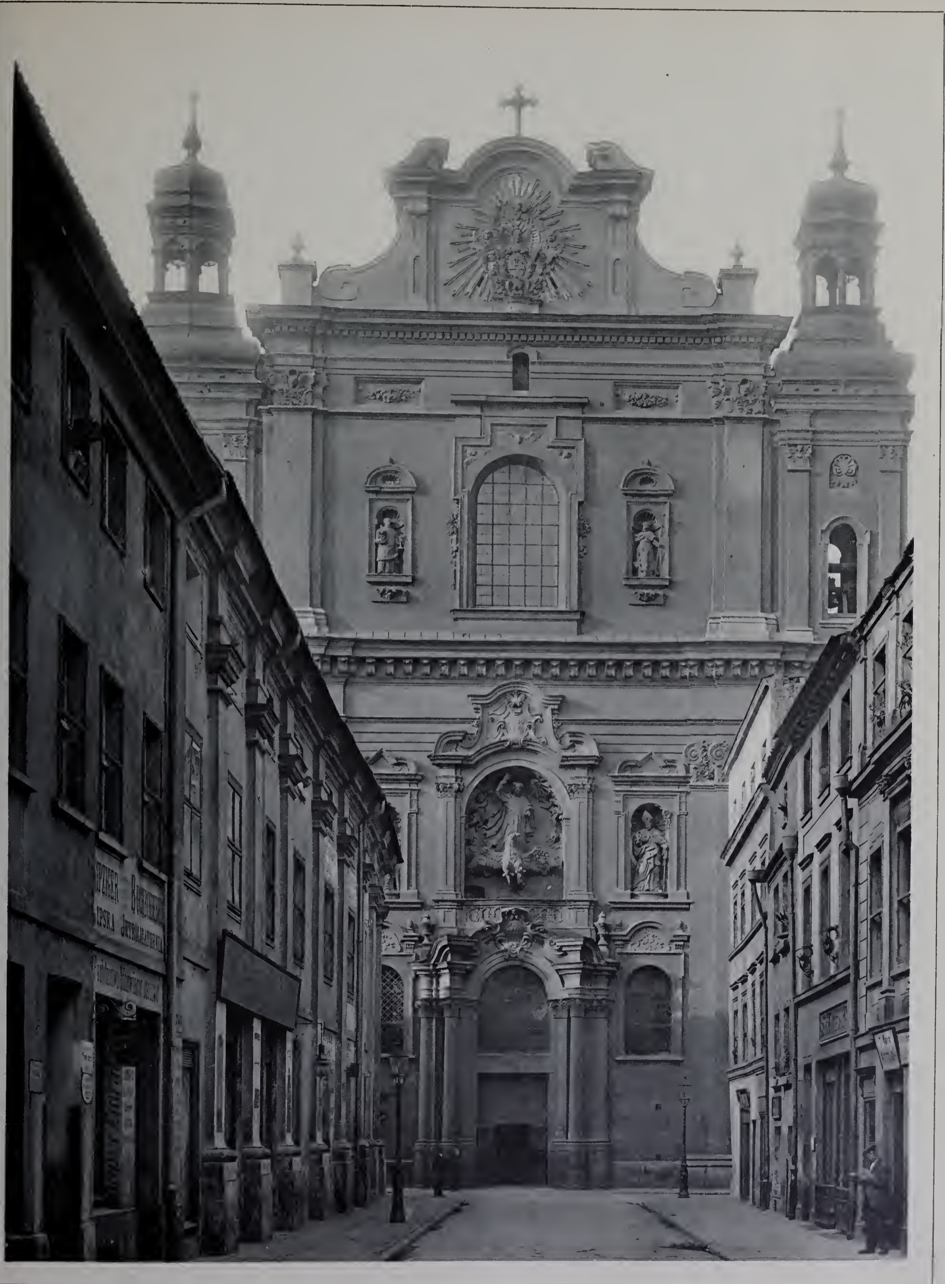
Architekt: Bartholomaeus Wasowski.
