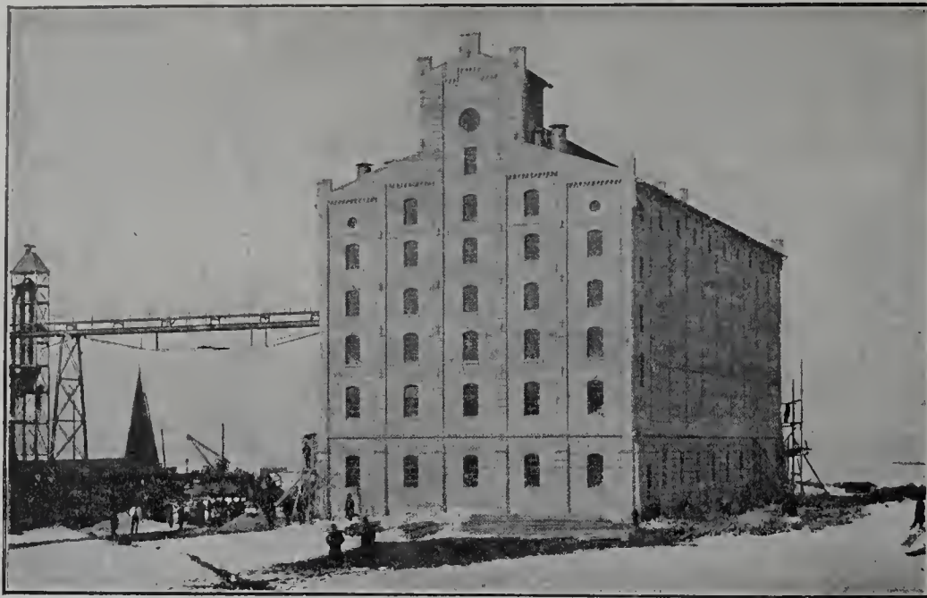
Silo in Eisenbeton am Hafen von Haidar-Pascha, Konstantinopel. Erbaut 1902.
