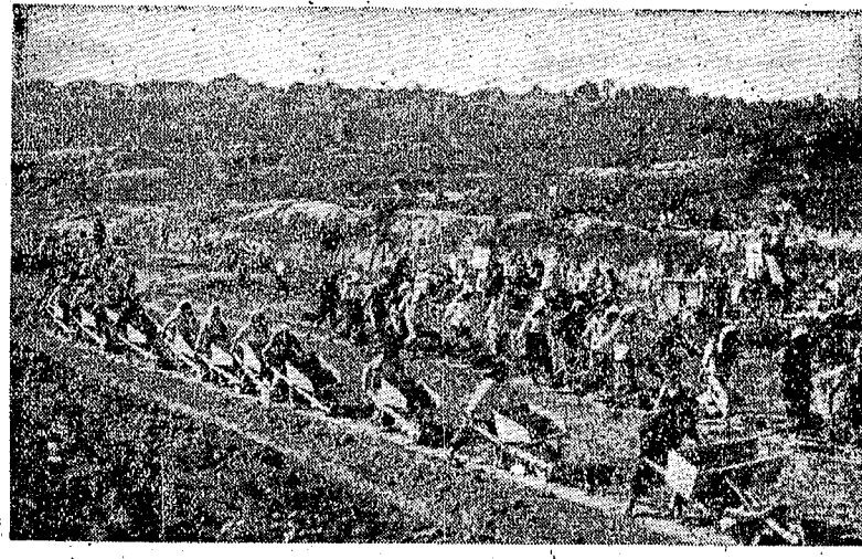
常德县南流堤工地上民工们正在紧张地施工，工人们干劲十足，这是他们辛勤劳动的缩影。
