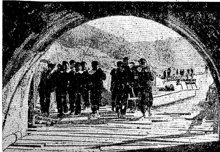
组织劳力提高工效 水府庙水库是全省重点工程之一，工地上的劳力组织得最好，工效最高，工费不断下降。这是民工们采用“小半”运石方法，把条石运往电站工区。(刘振国摄)
