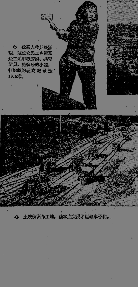
土铁轨在工地,基本上实现了运输机械化。
