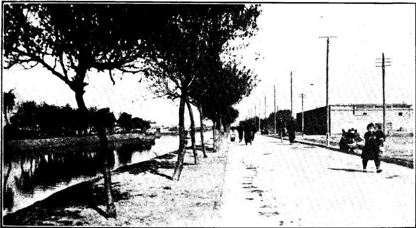
八里台大道磚基潑油築工竣情形
