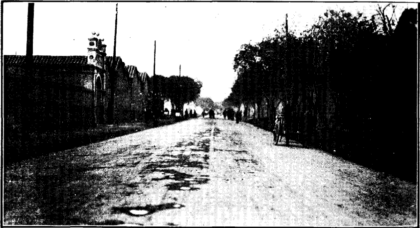
河 北 四 經 路 磚 基 油 潑 修 築 工 竣 情 形
