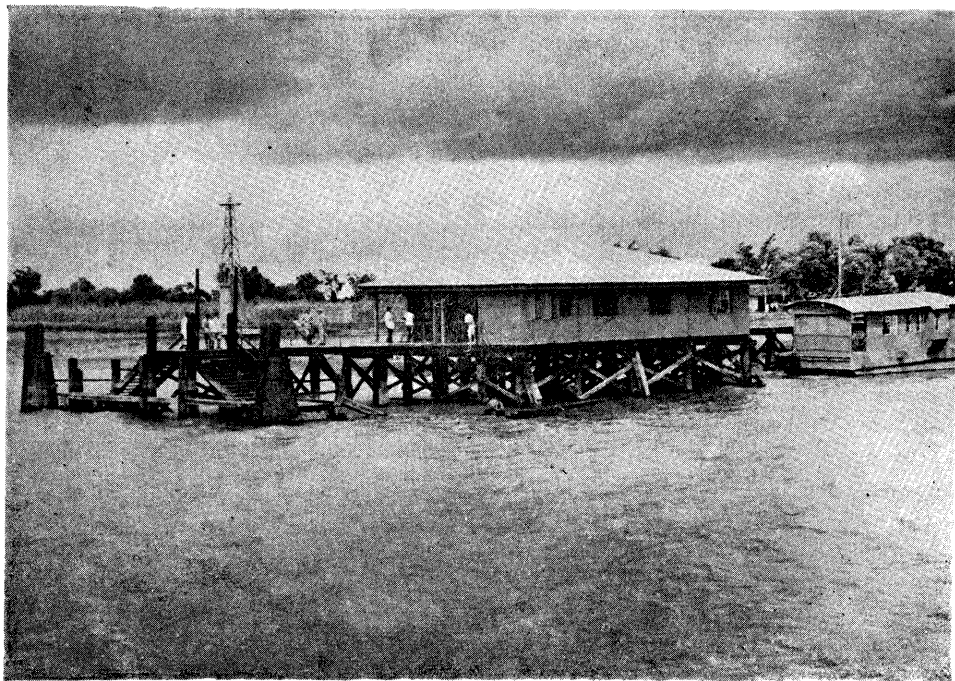
東溝碼頭梅花樁修復後全景
