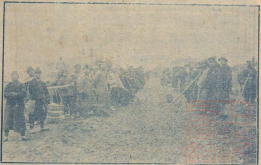
河南省公路局修築鄧州綫開辦朱段隨路施工之情形
