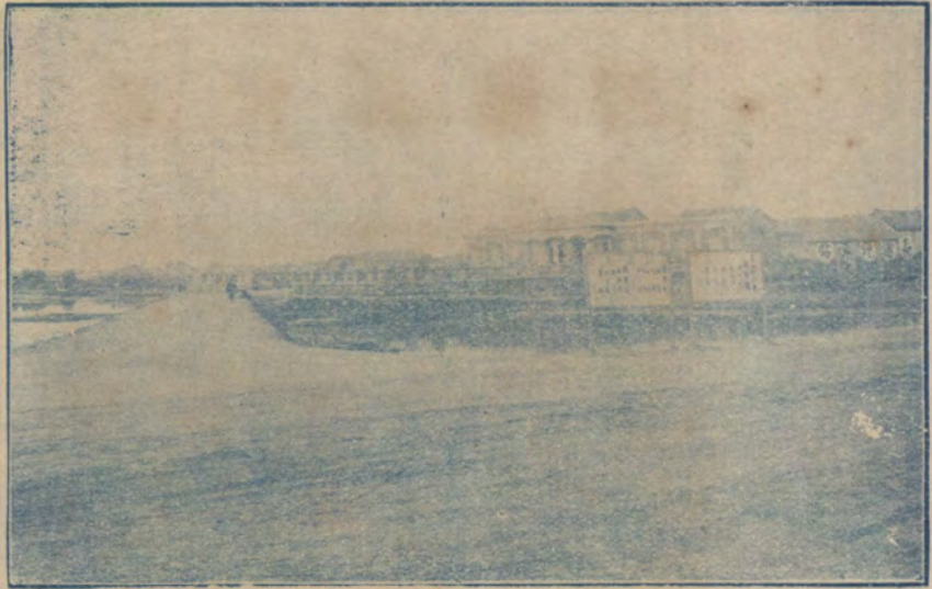
牌站之站封開車汽途長廳設建省南河
