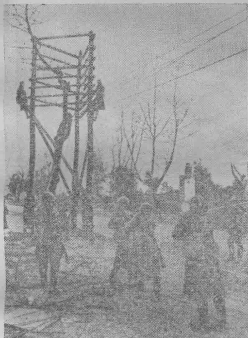
◁ 修复通信线路
