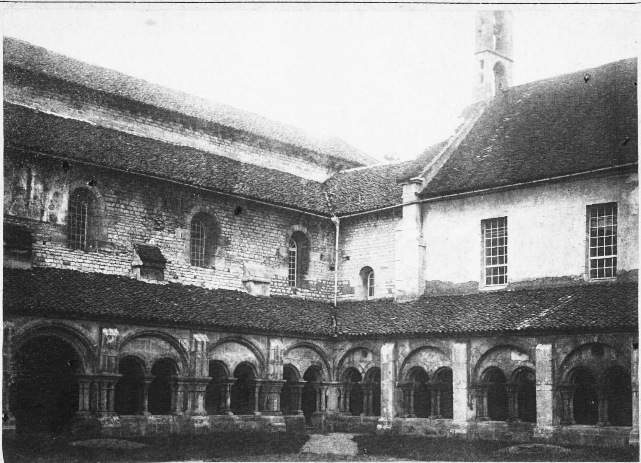
VUE EXTÉRIEURE DES CLOITRES
