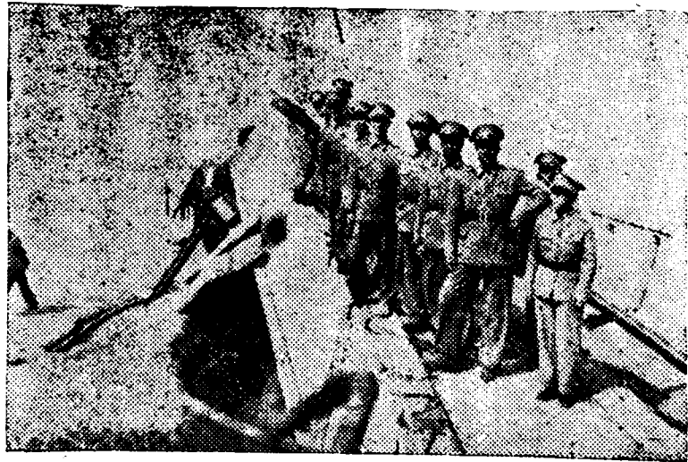
在破壞後的黃河鐵橋上
