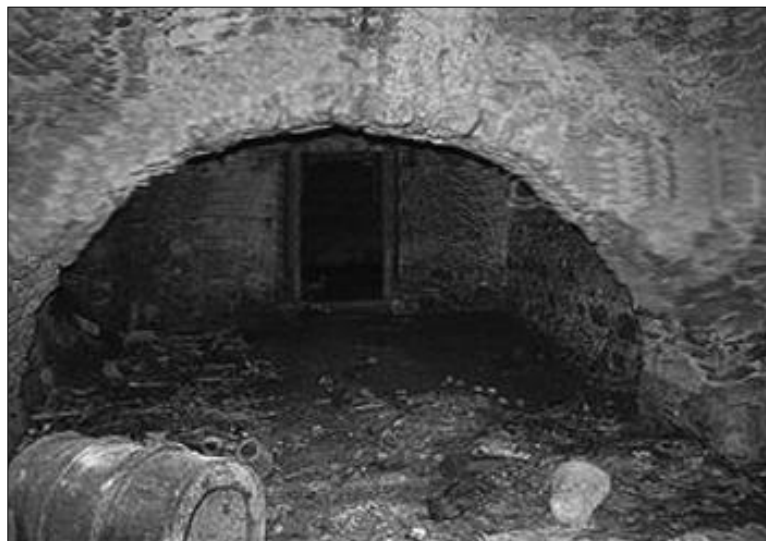
Підвальне приміщення маєтку
