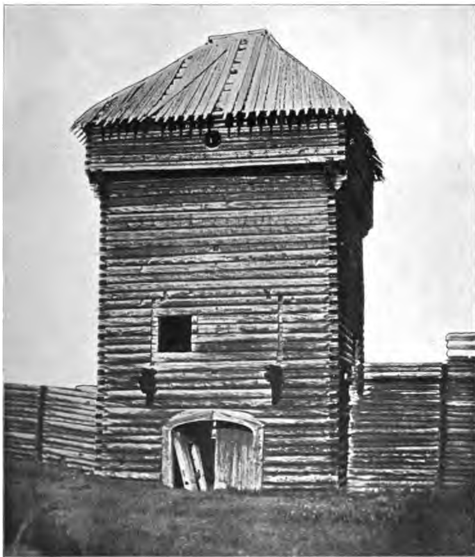
Средняя башня остатковъ Якутскаго острога съ наружной стороны.
