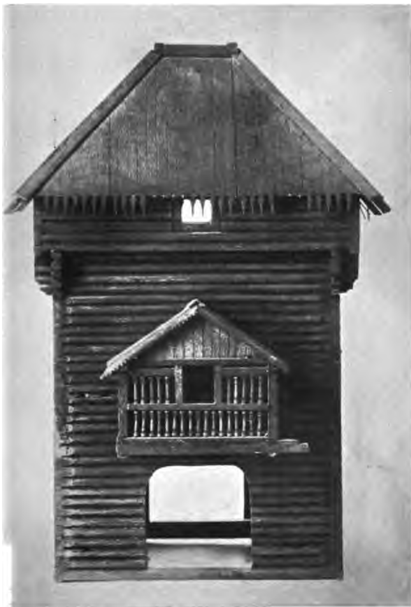
Отдельная, восточная башня Якутскаго острога. Фасадъ внутренней, западной стороны.
