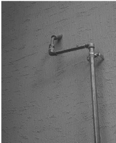
[그림] 외부에 설치된 금속플렉시블 호스의 부적합 사례
