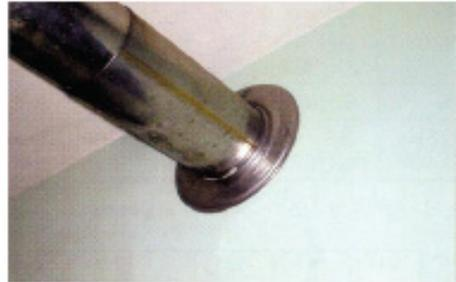
[그림] 밀폐식 연소기의 배기통 설치 예
