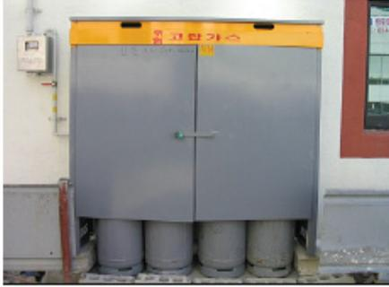
[그림] 용기보관실 설치(O)
