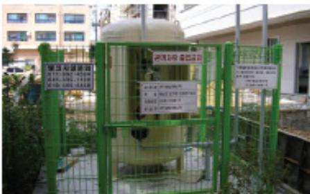
[그림] 소형저장탱크 주위 경계책 설치(O)
