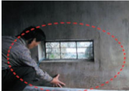
[그림] 환기구가 바닥면에 접하지 않은 사례(X)
