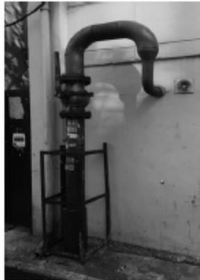
[그림] 부적절한 "C" 형태 강관제 구조물 설치 사례
