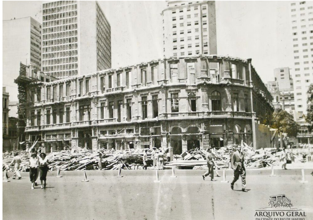
Figura 7 – Demolição do Hotel Avenida, avenida Rio Branco, Rio de Janeiro, década de 1950. Fonte: Arquivo Geral da Cidade do Rio de Janeiro, Pasta 278/B, R. 1004/12.
