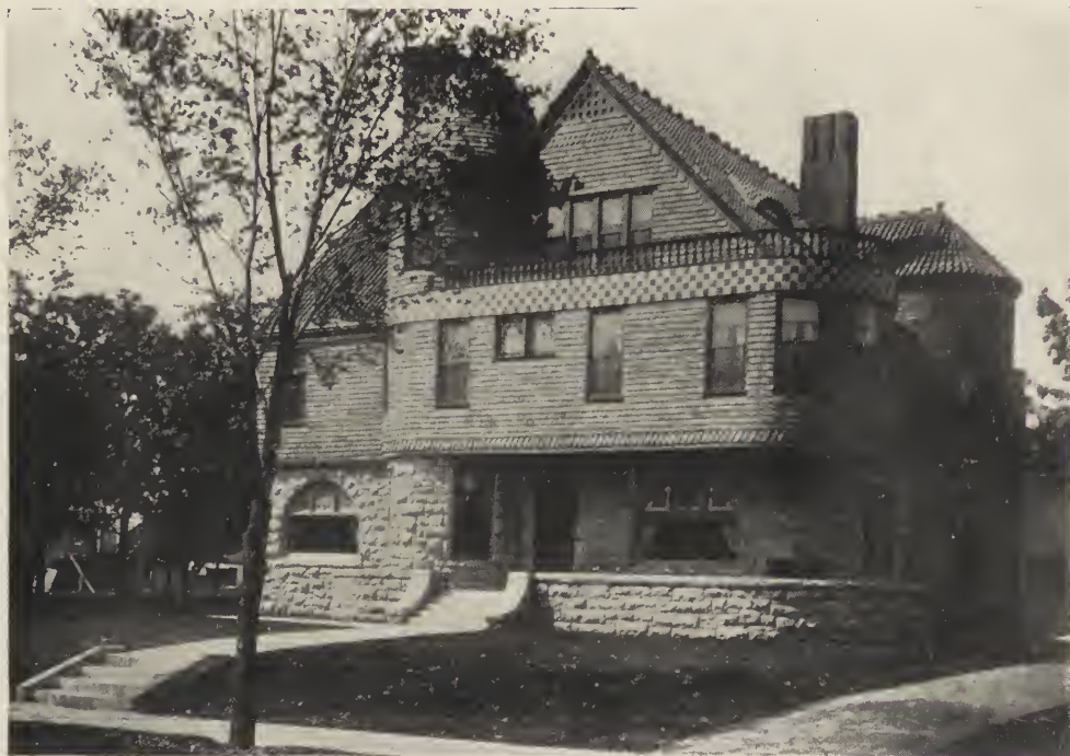
FIG. 14. DWELLING IN LOS ANGELES, CAL.
