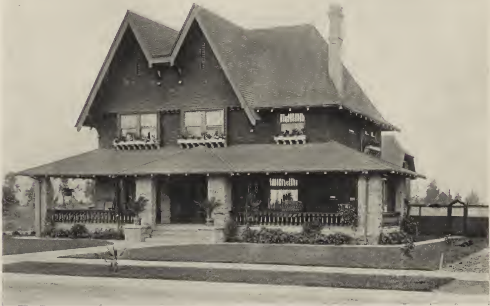
FIG. 13. DWELLING IN LOS ANGELES, CAL.
