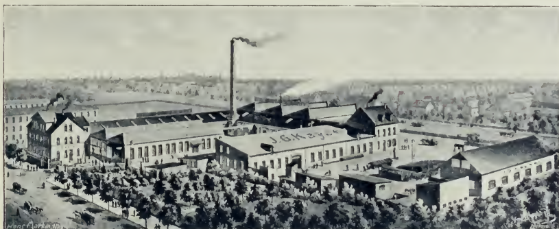
Fabrik-Etablissement in Nürnberg-Glaishammer.
