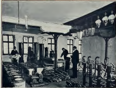
Stadtlager in Nürnberg, Brunnengasse 23 und 25 Cloiset- und Pumpenlager
