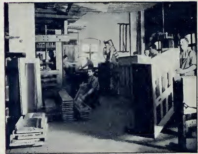
Arbeitsraum für Umbau
