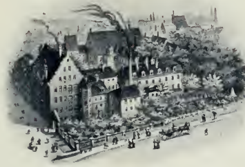
Gesamtanicht des Etabliements
