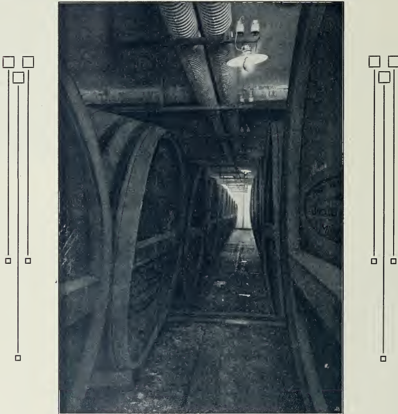
Schnitt eines Teiles des neuen oberirdischen Kellers mit einem Fassungsraum von 4 Millionen Liter. An der Decke Vorrichtung für künstliche Kühlung
