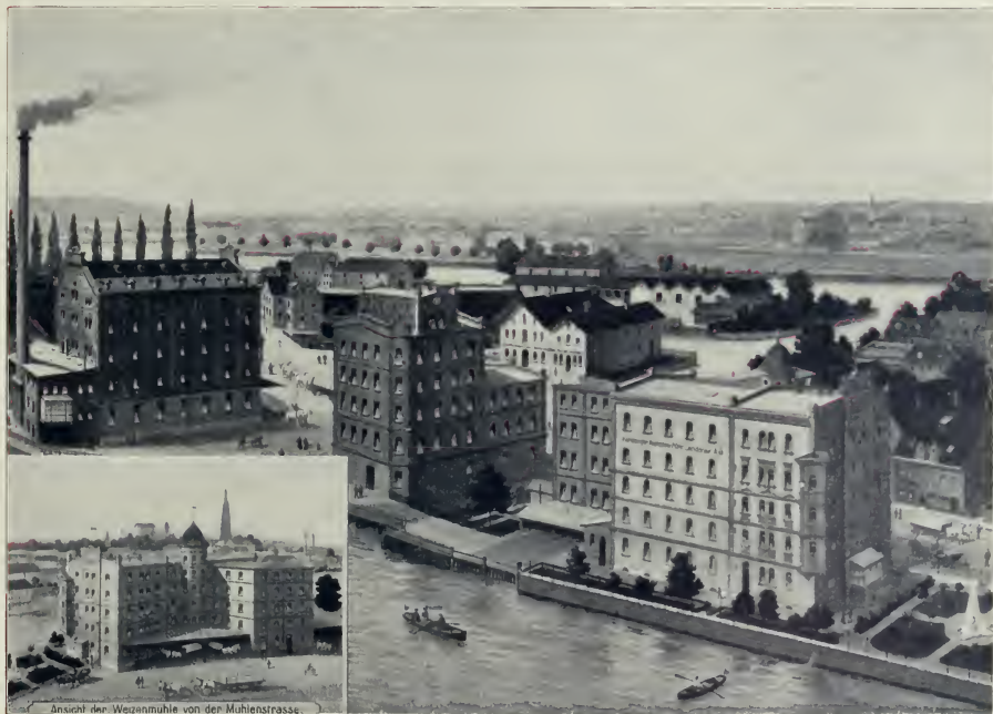
Ansicht der Weizenmühle von den Mühlenstrasse.
