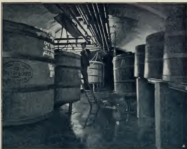
Anblick eines Teiles der Gärkeller, nahezu 600 der riesigen Gärbottiche enthaltend; an der Decke Vorrichtungen für künstliche Kühlung
