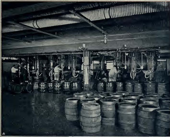
Zentralabfüllhalle mit Apparaten nach dem Patent Colby
