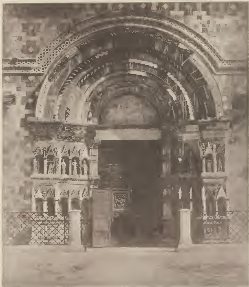
TAV. 146 — AQUILA, Porta principale della Chiesa di S. M. a di Collemaggio. (sec. XIII).
