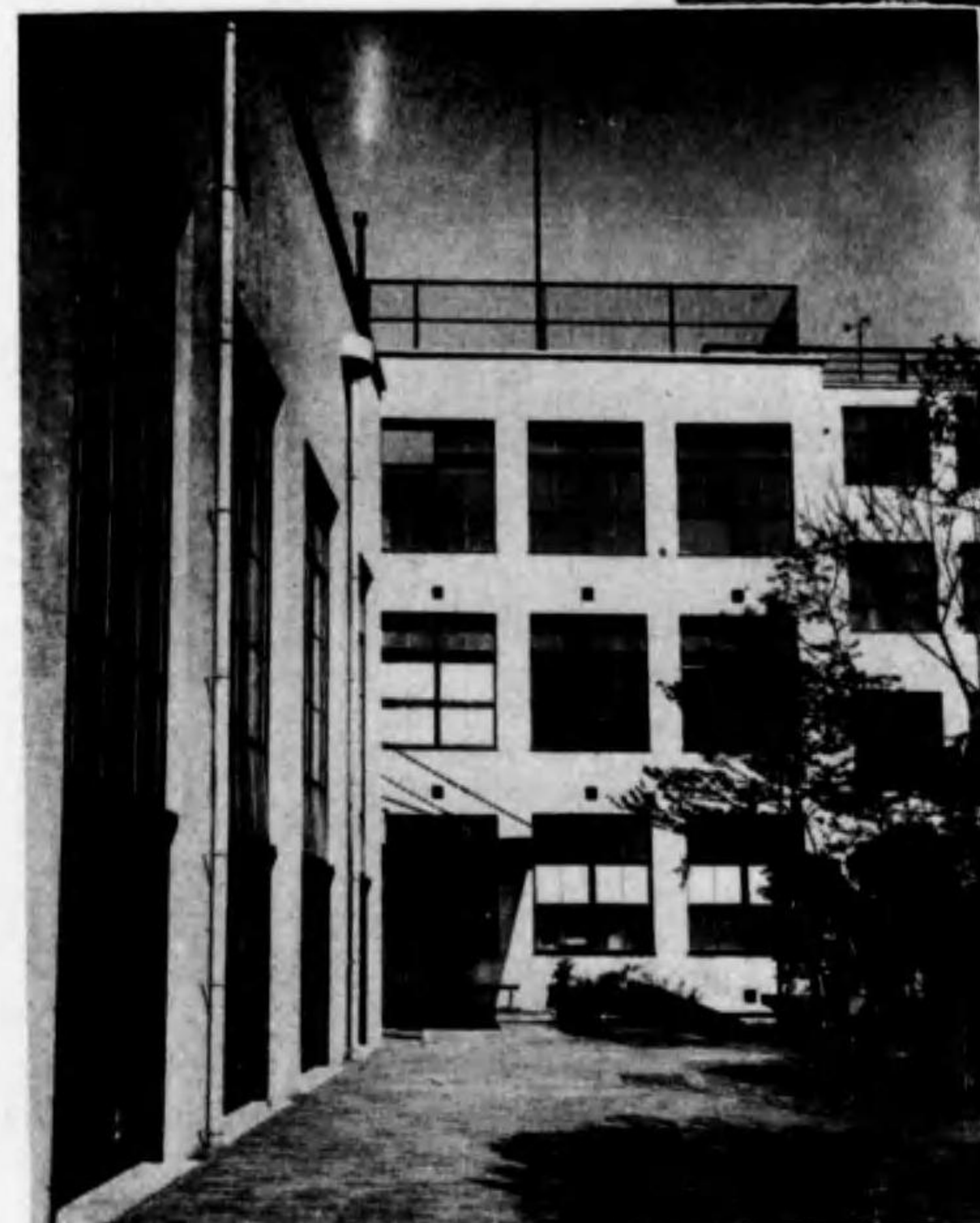
正面より玄関廻りを望む
