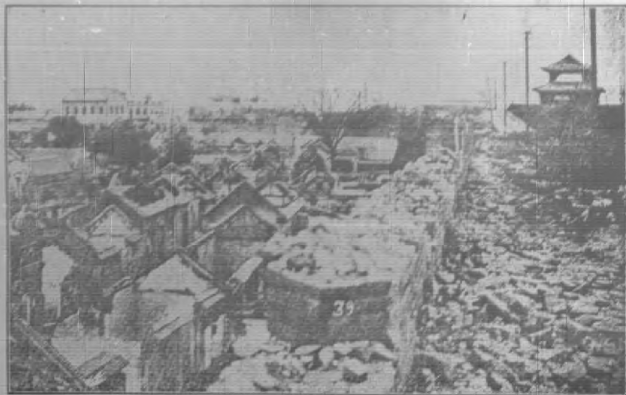
西門城牆外被日軍砲擊之後之一部
