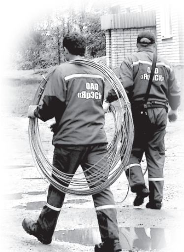
Электрики обходят дома восточного района, устраняя многочисленные аварии на электросетях
