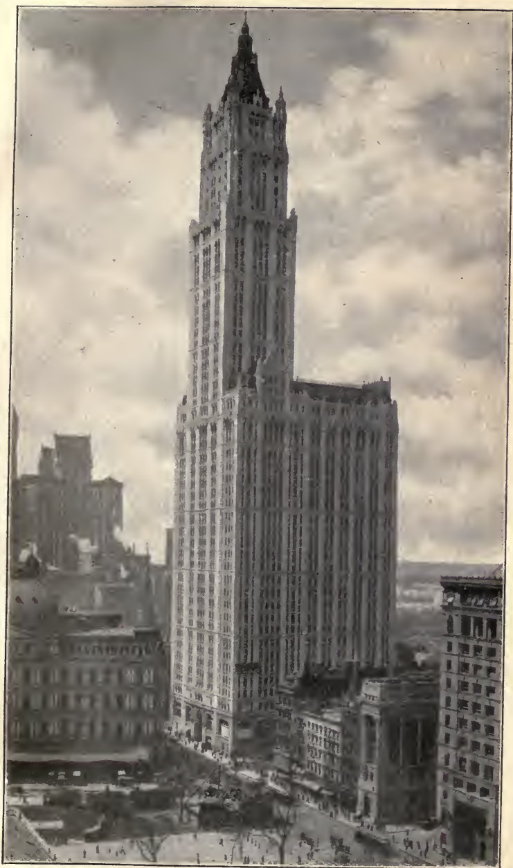
New Yorks höchster Wolkenkratzer Woolworth Building
