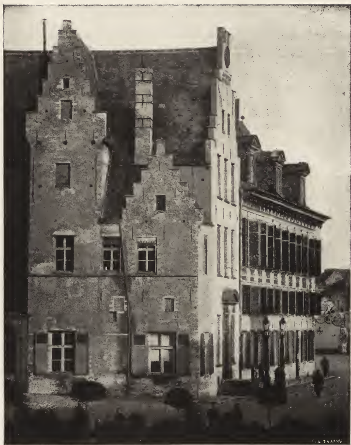
Planche II — Façade de l'Hôtel de ville, du côté de l'église métropolitaine avant la restauration
