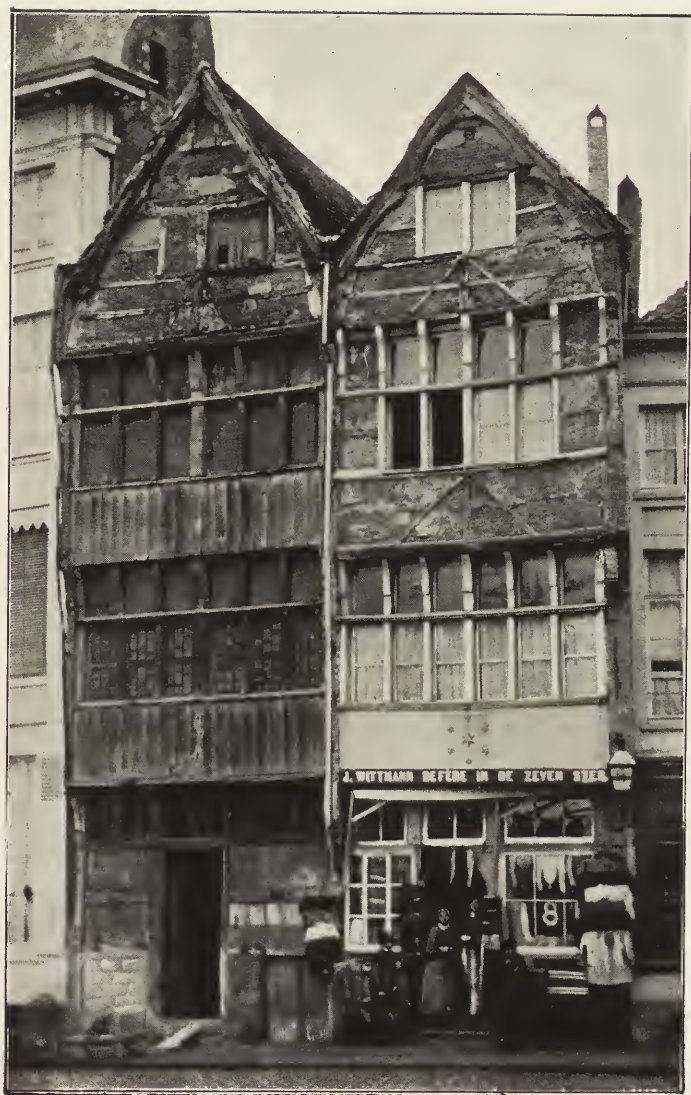
Planche VI — Maisons du xvii e siècle, démolies en 1861
