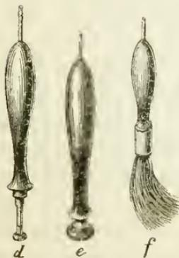
Schliessen der Kette auf dem Körper, zur directen Muskelreizung sowie zur Reizung der Nervi phrenici und ihrer Genossen bei Asphyktischen benutze <sup>1)</sup>. Ich gebe zugleich eine Abbildung der den Stöhrer'schen Apparaten beigegebenen Electroden (vgl. Fig. 9) und zwar der mit breiter Platinplatte versehenen (e), sowie der mit dem Kohlenknopf armirten Electrode (d), sowie endlich des Pinsels von Silbergespinnst (f).
