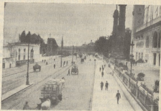
Les Quais vus de la Passerelle et la terrasse fleurie.
