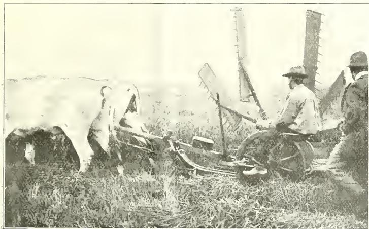
Fig. 134. — Moissonneuse-javeleuse pour le riz, à moteur, de M. Balbo-Bertone.
