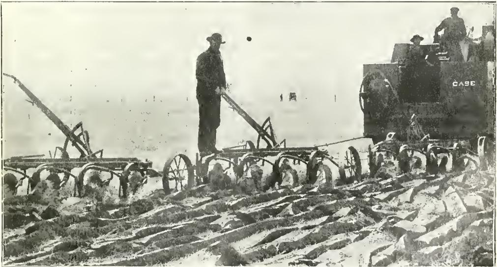
Fig. 48. — Charrues tirées par une locomotive routière Case.
