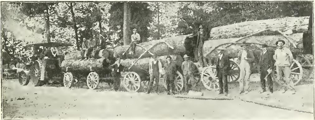
Fig. 67. — Locomotiv>e-routière Case appliquée au transport des arbres abattus.
