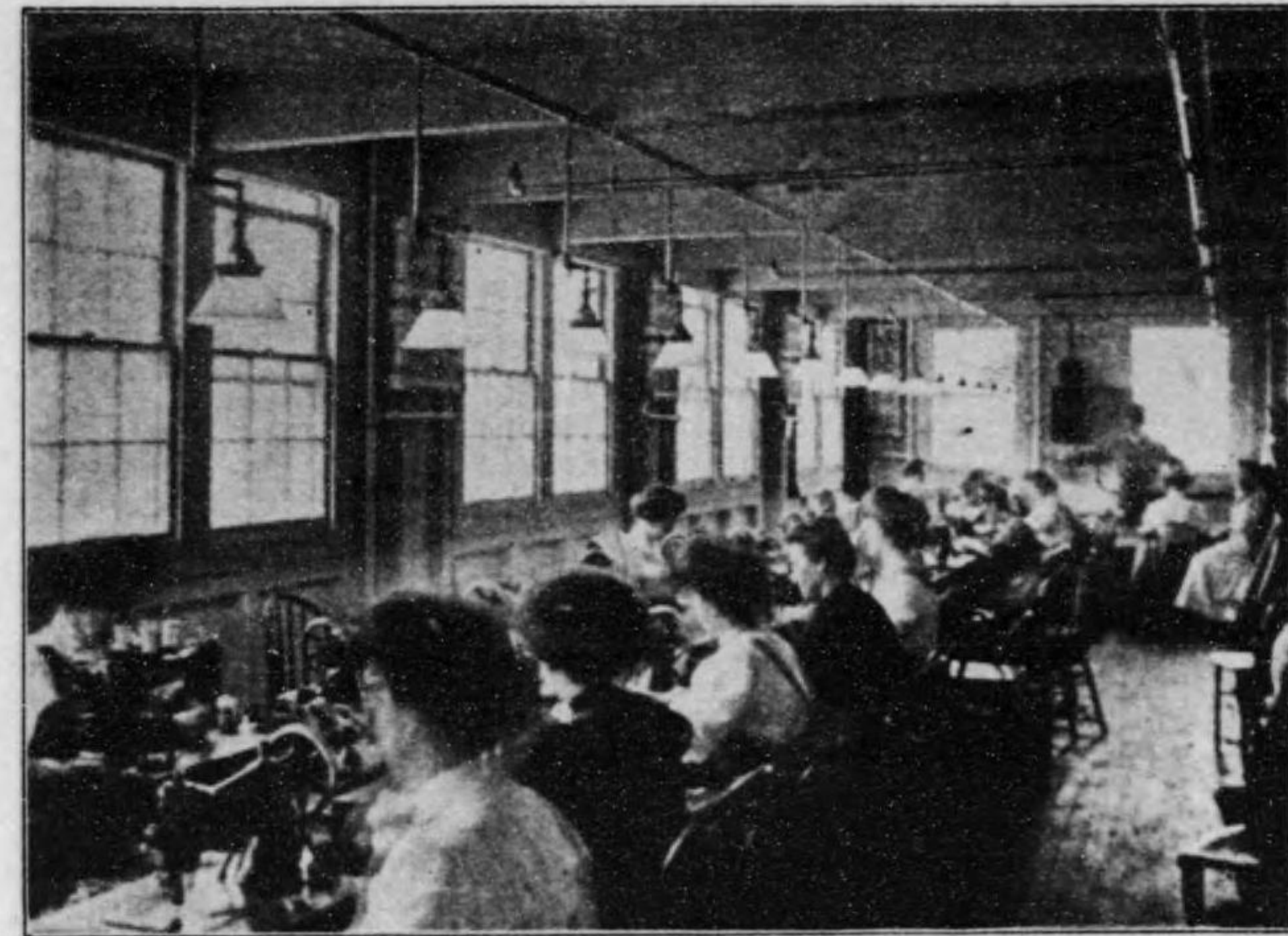
第五圖 天井の低き室に於ける瓦斯照明設備の晝景。本寫眞は光源の 配置を示せるものにて 照明の如何を示せしものに非ず。
