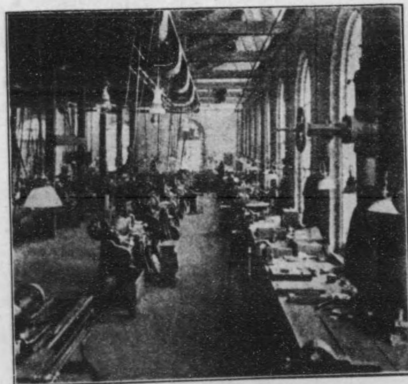
第八圖 相當に高き天井を有する室に於ける瓦斯點燈設備の晝景。 圖の中央、工作機械上にある有孔反射笠に注意すべし。
