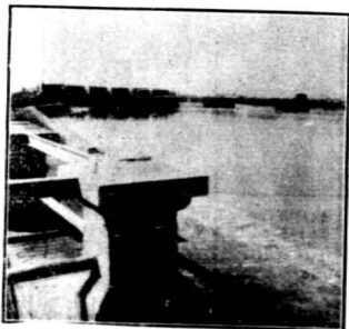
十 總幹渠上之「水閘」橫跨總幹渠者為壘運水閘 (Crossregulator) 左右兩岸即許多次幹渠或支渠之運水閘也。
