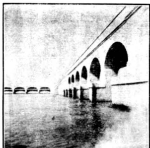
五 運渠進水閘，注意象式式當裝，其目的在招誘水面清水進渠，（水面下近壩處，身偏向下游，所以排聚泥沙使不進渠也）
