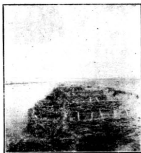
十四 幹渠高堤之安全, 全賴有適當厚度之 Ber m, 以資保護。圖中所示, 為藉透水管之阻力, 浮積泥沙, 自動造成 Ber m 之妙法。此種自成之 Ber m 極為堅實, 故堤內滲透水坡, 更屬安全。
