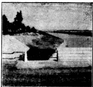
七 運渠之起點，注意近開處之壘閘部份，壘運水閘當自門頂上過取表面清水，故開身者加長，才能得到規定流量也。此為防砂設備之一種。
