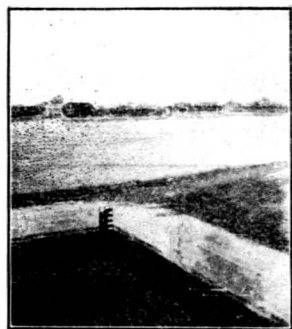
十三 水尺井 (gauge well) 重要運渠進水湖及分水閘上下游, 均設水尺井, 以期水位讀數準確, 不受波浪等之影響, 水尺井與運渠用水管連通。
