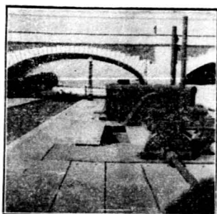
六 鋼門橋於兩岸多建一孔，其用處極大：鋼門可自此孔起卸，一也；Abutment 在岸容易建造，二也；增加美觀三也。此照攝自邁水閘之鐵門橋上，若景即活動壩鋼門橋左岸第一孔也。
