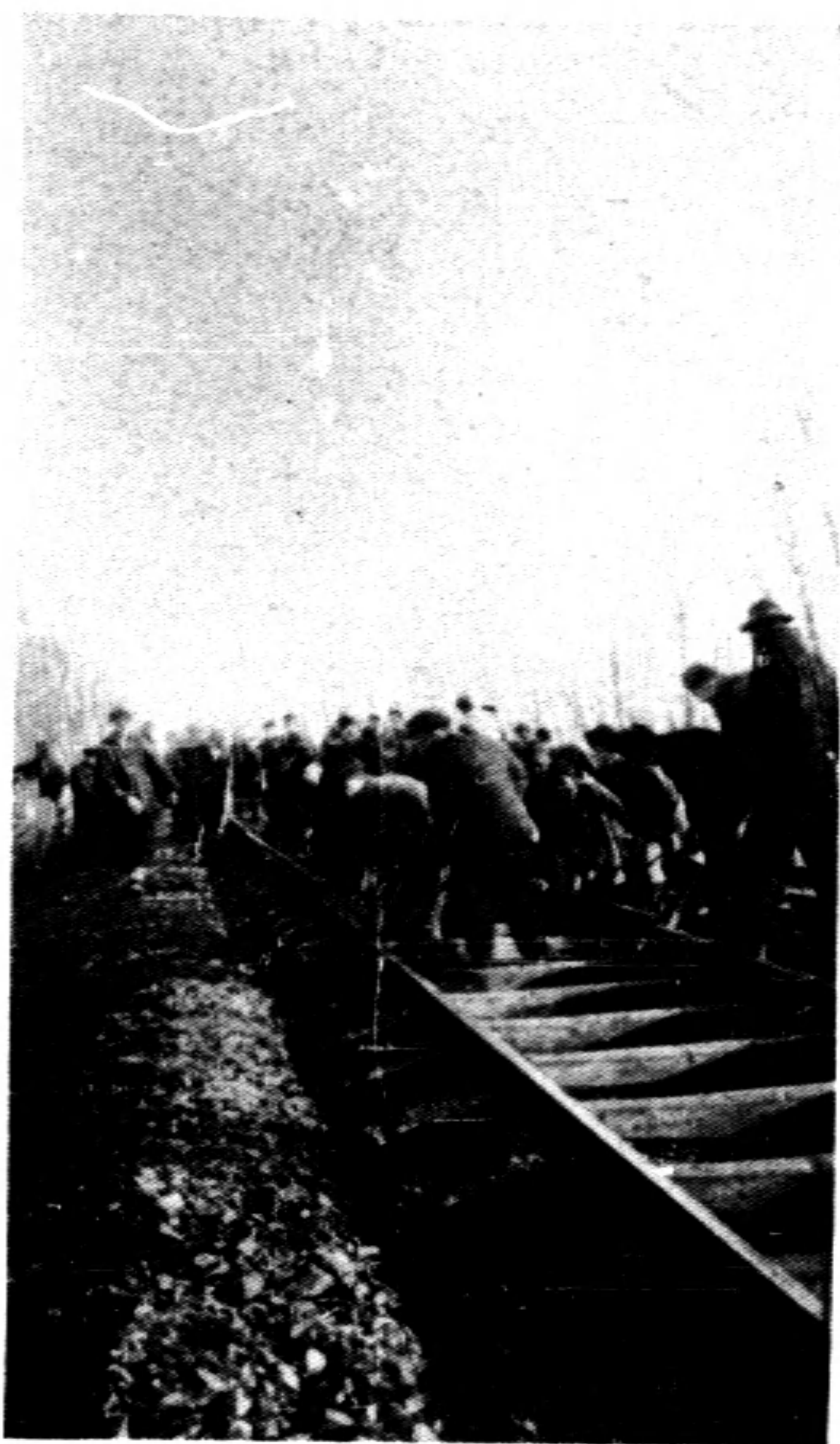
照片(四) 撥出舊軌道情形
