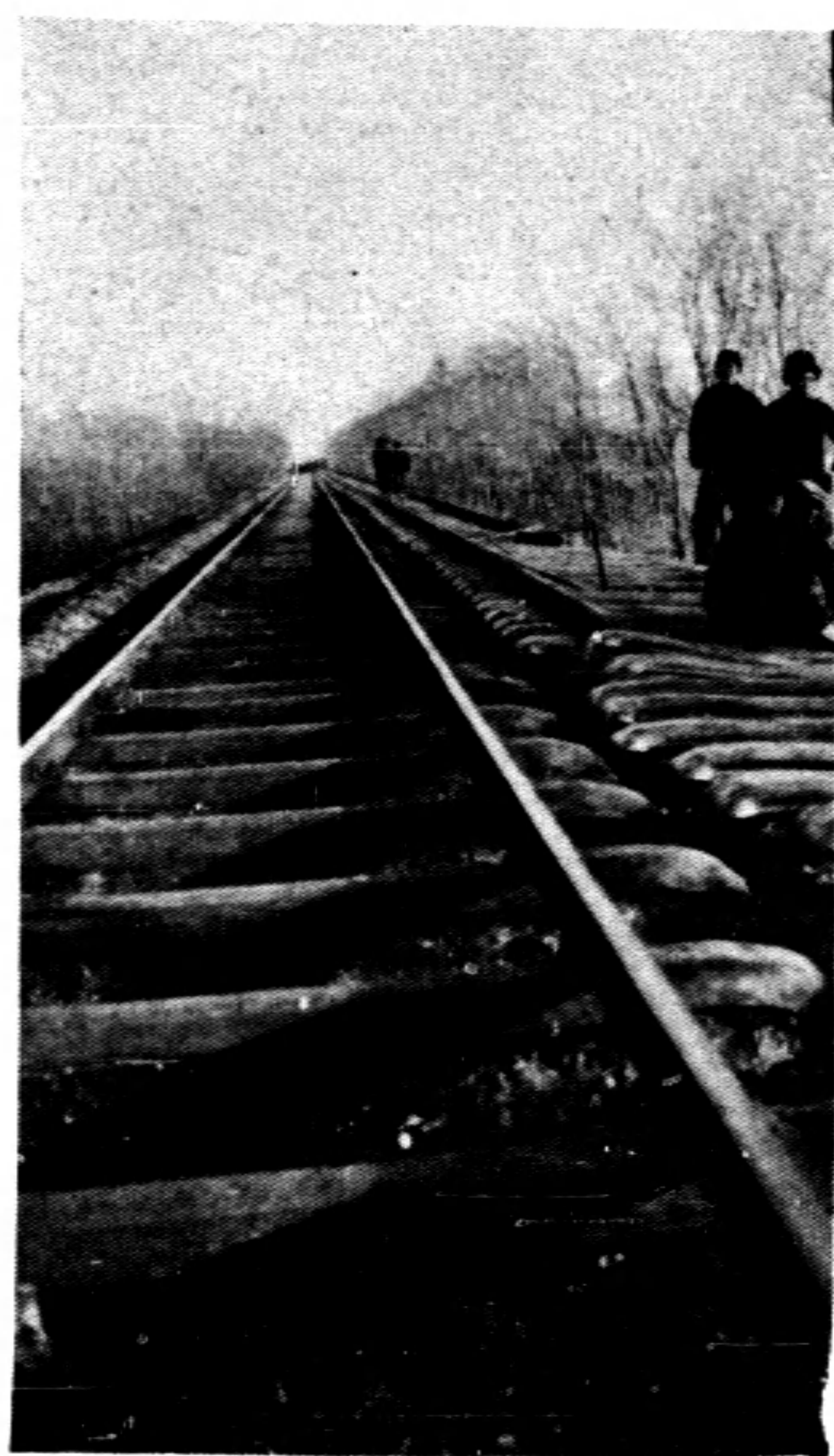
照片(六) 裝配新軌道情形
