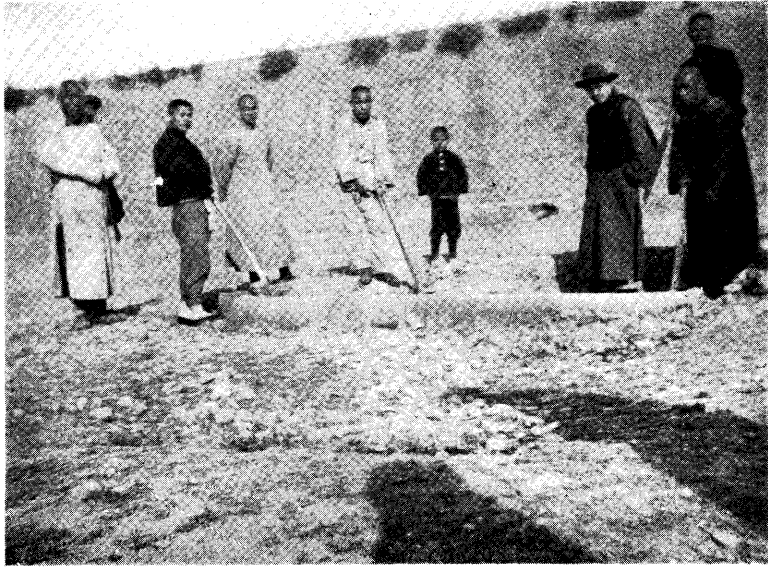
本館發掘西直門炮局埋覆古炮狀況
