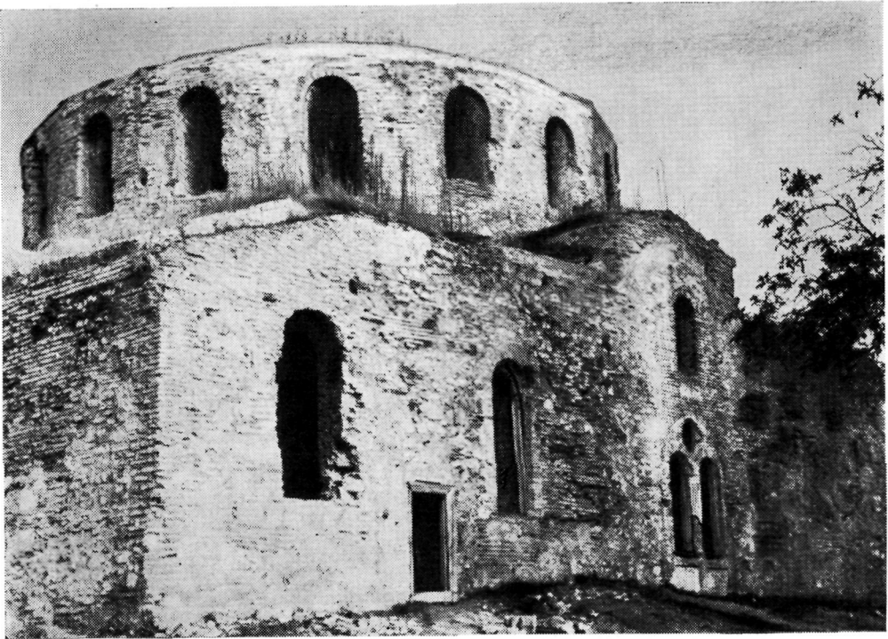
Рис. 4. Церковь в с. Дранда, общий вид с юго-западной стороны
