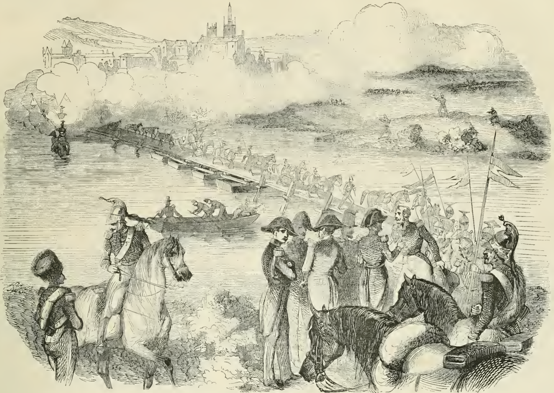
Camp de la Moselle. — Journée du 25 août — Pont jete sur la Moselle près Moulin-lez-Metz, et passage de la brigade de cavalerie commandée par le general Boyer, en présence de Mgr le duc de Nemours.
