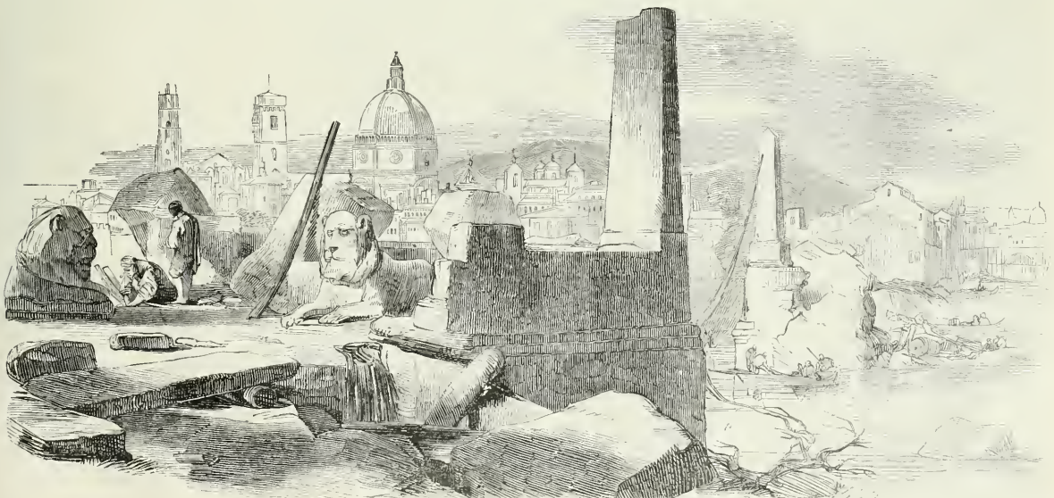
Florence. — Vue du pont de Perro, après la dernière inondation.)
