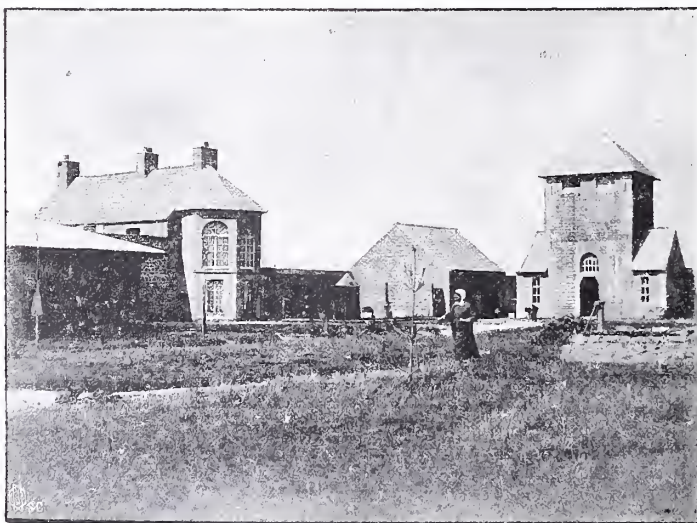
LABORATOIRE MARITIME DE TATIHOU. — Château d'eau et entrée des bâtiments.
