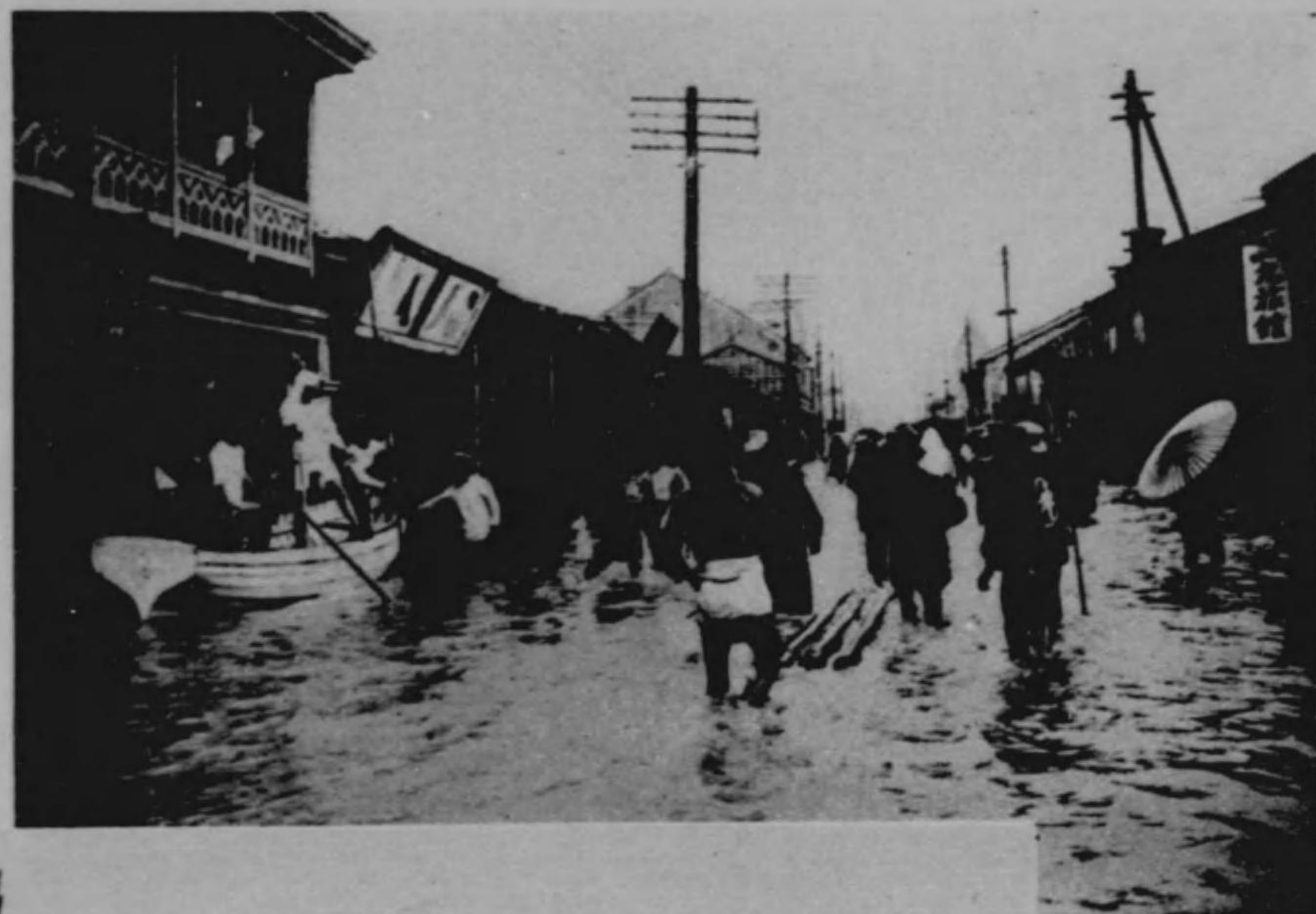
臺北 府前街通り風水害状況
