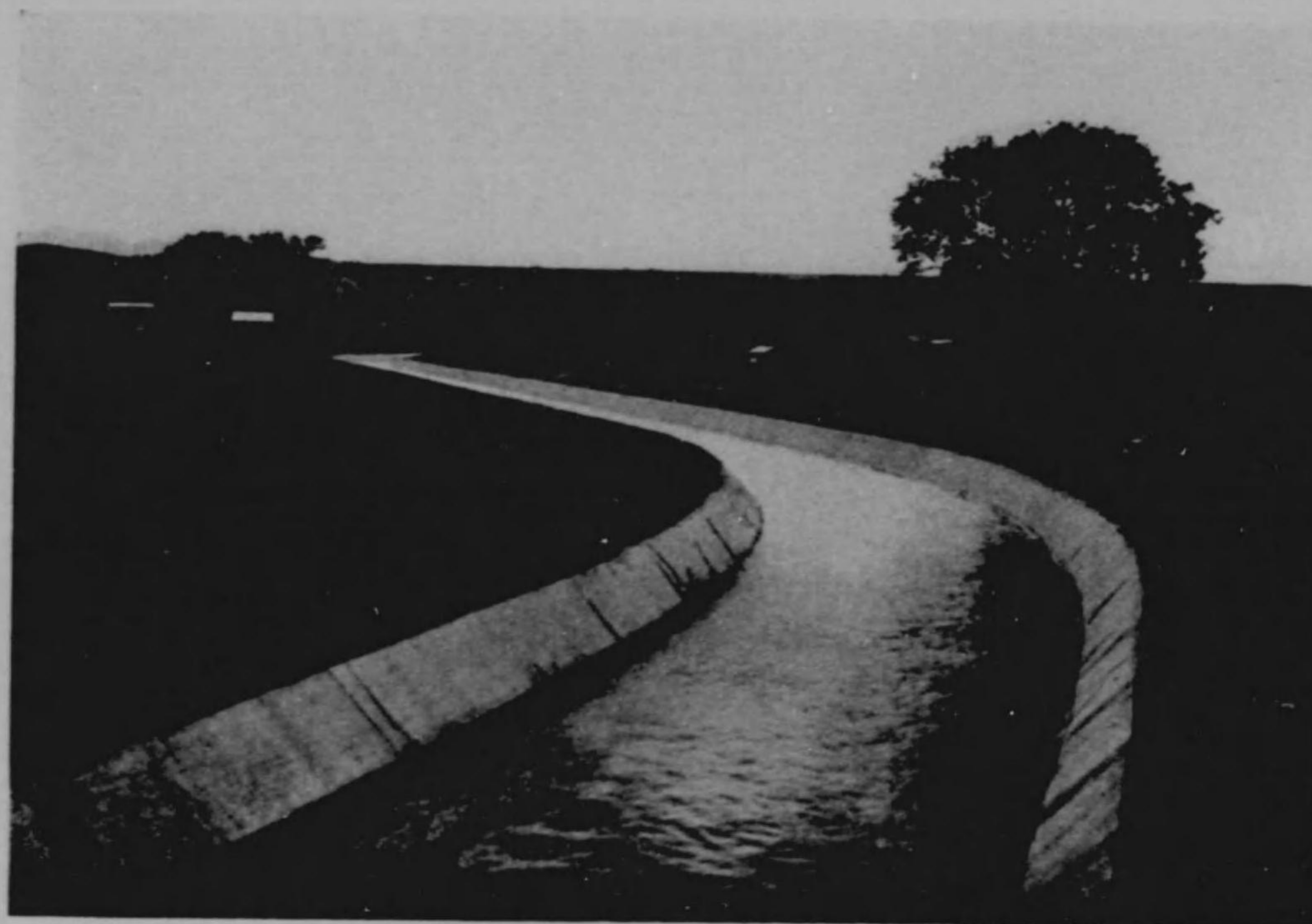
嘉南大圳 南北幹線導水路
