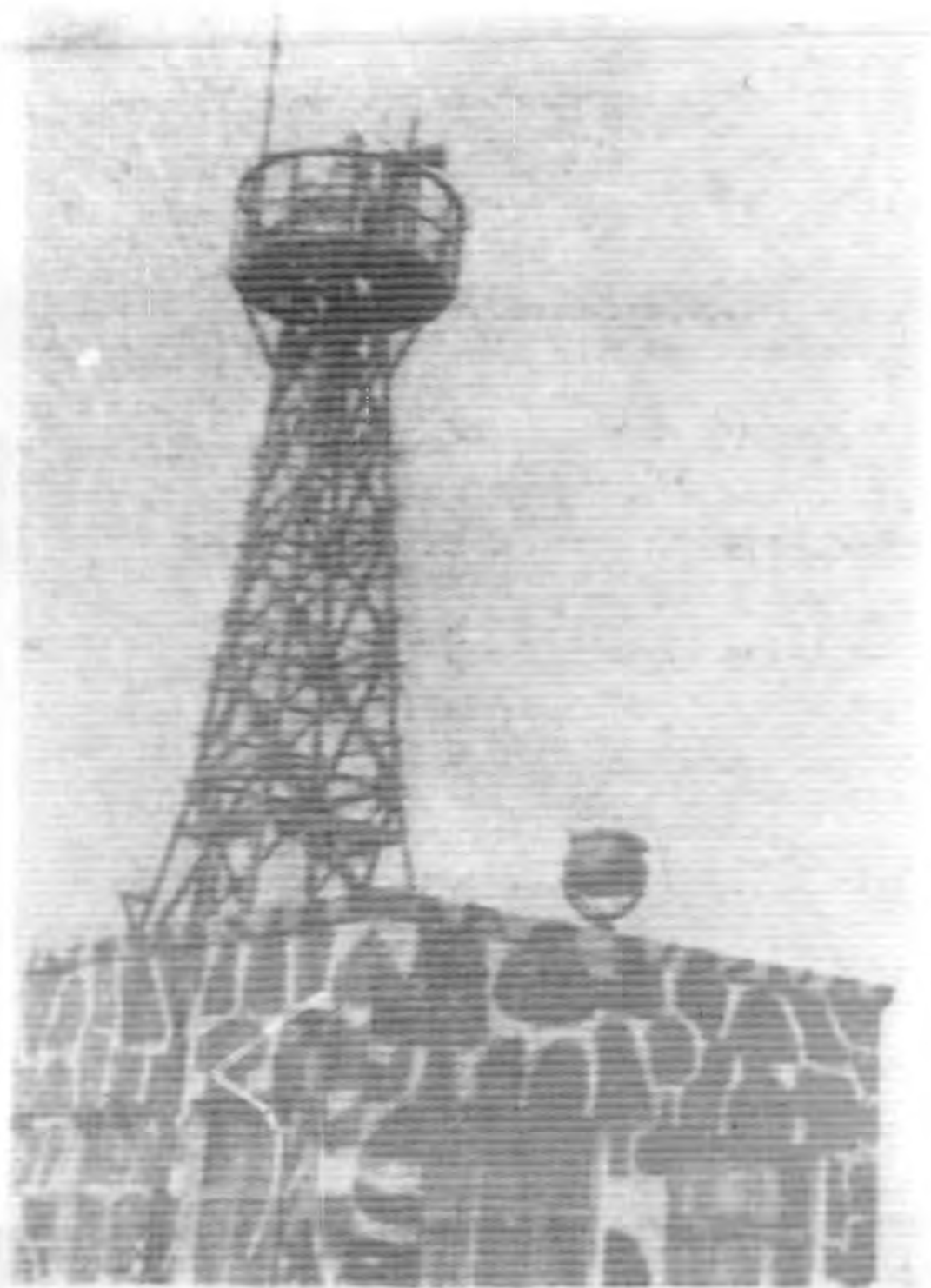
機場內昇降指揮塔
